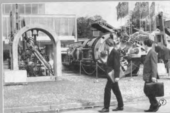
⑦トンネルボーリングマシン
