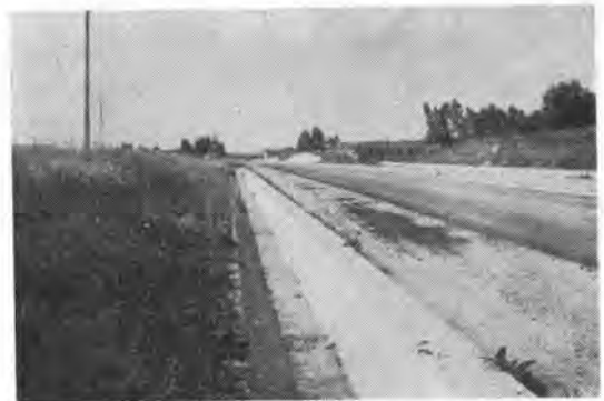
写真-2 イタリアの Auto-strada の施工現場
