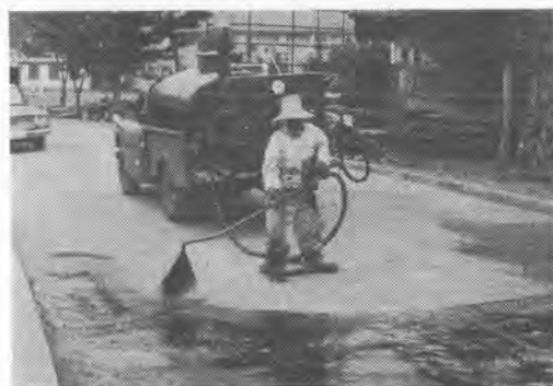
ローリ型アスファルトエンジンスプレーヤー 1500ℓ
