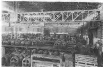
写真-6 電機工場
