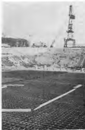
写真-11 アイ河河底トンネル工事現場
