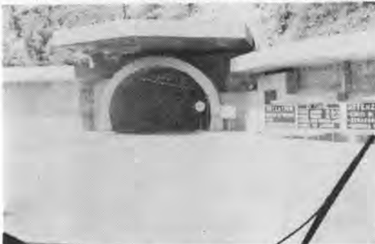
写真-5 モンブラントンネル入口
