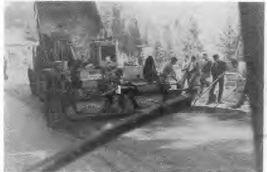
写真-6 フランス・シャムニーからジュネーブへの途中の舗装補修現場
