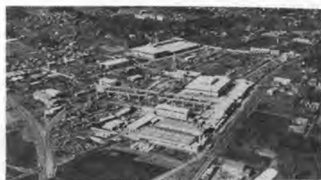
写真-1 大宮工場全景
