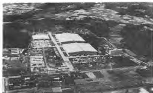
写真-1 相模工場全景
