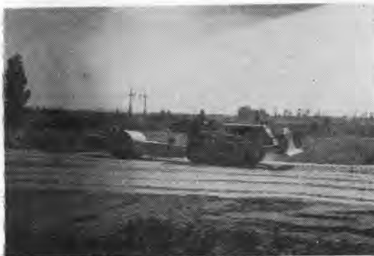
写真-1 イタリアの高速道路 (Auto-strada) の施工現場
