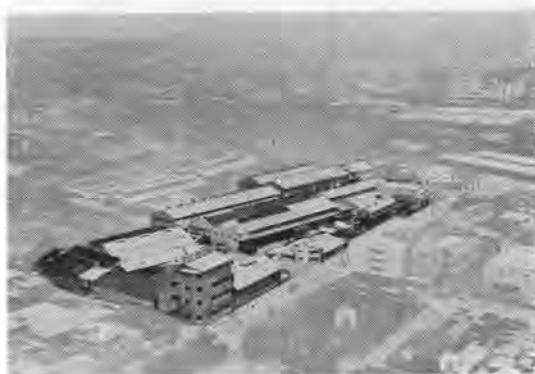
写真-1 本社工場全景
