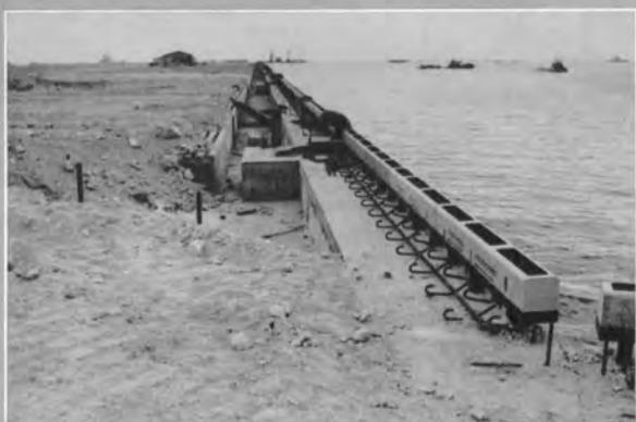
↑車止め取付け
