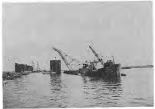
写真-4 施工中の全景
