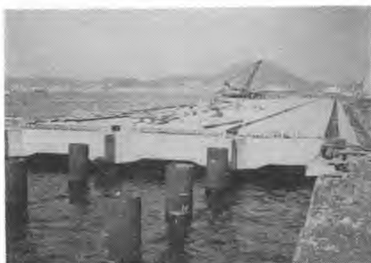
写真-3 けた、版の据付け状況
