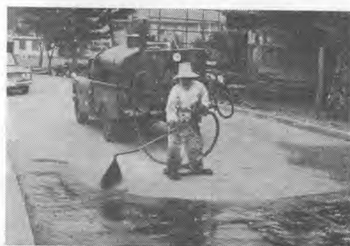
ローリ型アスファルトエンジンブレイヤー 1500ℓ
