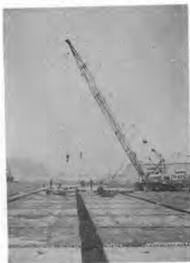
写真-2 トラッククレーンによる版据付け
