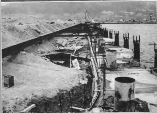
↑ 蓋コンクリート打設
