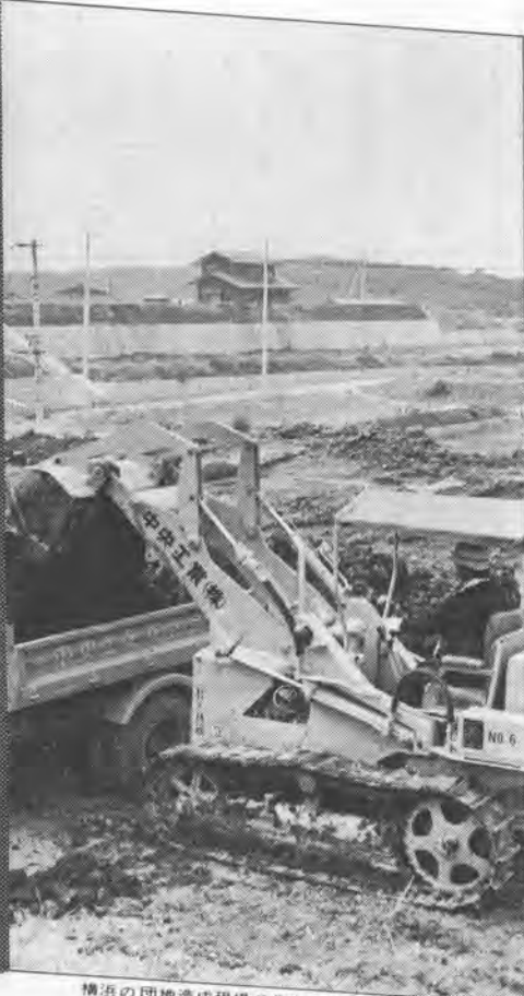
横浜の団地造成現場で作業中の中央工業(株)様のBS3
