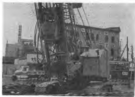
退避時はタワーを前倒し、地上高を4.5m以下にして架空線などの上空障害を避ける
