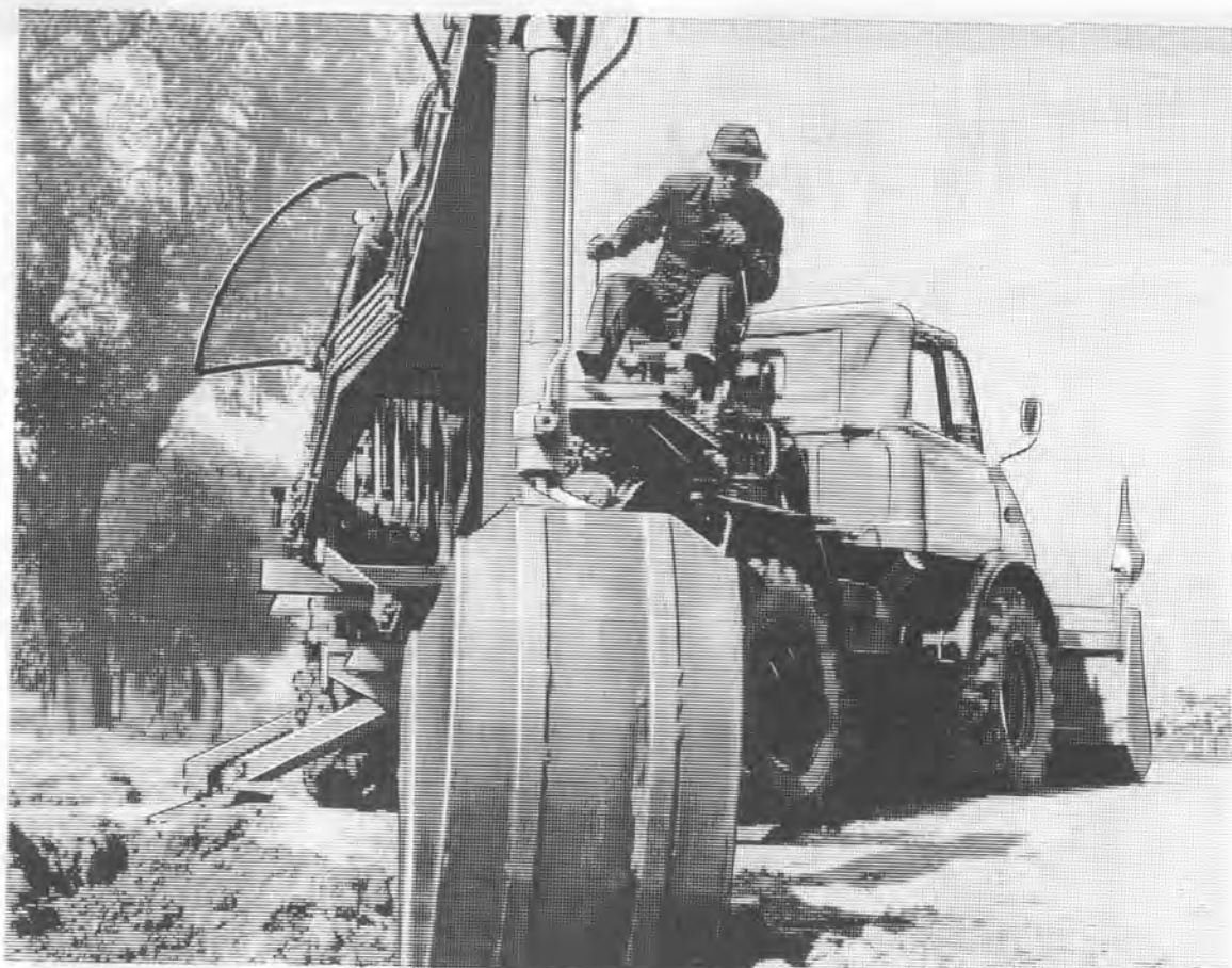
前に取り付けけたバケットは理想的な掘さく機になります
