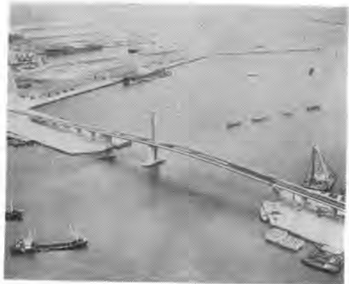
写真-1 摩耶大橋
