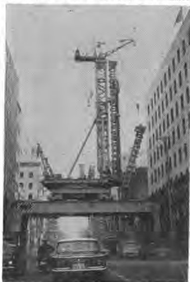
写真-5 大阪地下鉄6号線施工中のゴライアス搭載アースオーガ
