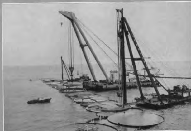
↓ コンポーザ工法による中詰改良
