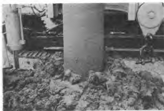
写真-6 (a) シルト層の掘削・引抜き、この後、バキューム作用により掘削土砂が引込まれた。
