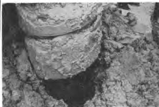
写真-6 (b) まだスクリーは約 1 m ほど地下にあるが、スクリーにはほとんど土は付着してなかった。
