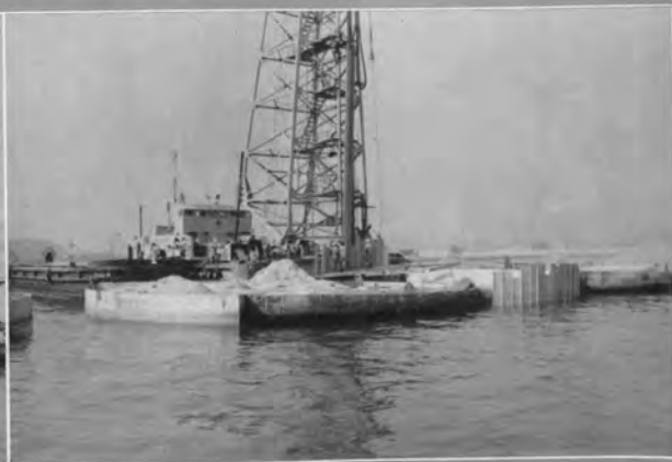
↓ セル連結矢板建込み
