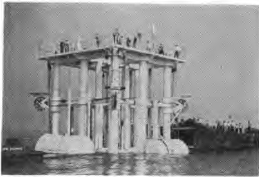
写真-1 現場の固定用バージに接着した 試験工用支持わく
