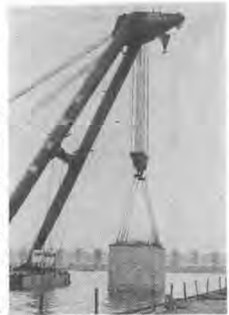
写真-2 1,000tづり起重機船によるケーソンの運搬据付け
