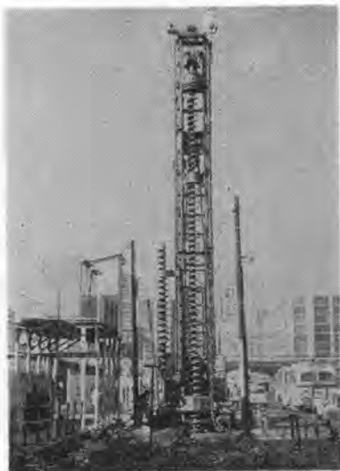
写真3 40 H 型掘進機構と専用タワー
