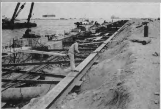
↑プレキャストけた据付け完了
