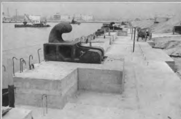
↑現場打ちコンクリート
