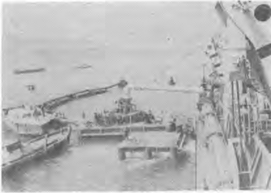
写真-2 受船式玄外排送設備
