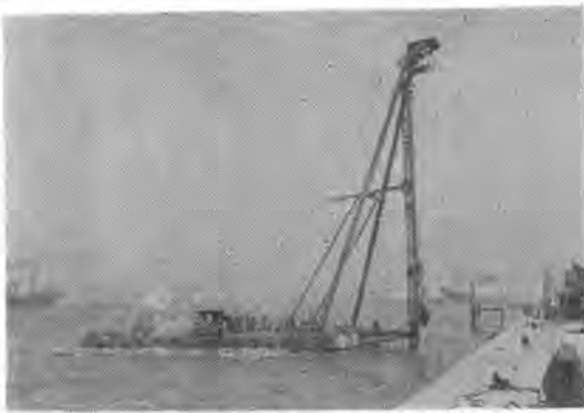
写真-1 くい打船 (起重機船兼用)
