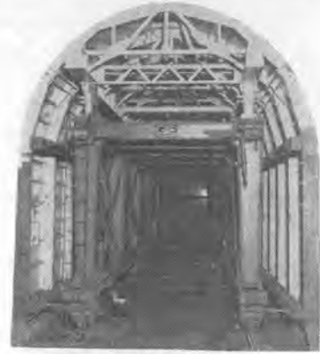
写真は国鉄新清水隧道工事用 スチールフォーム 鉄建建設株式会社 大成建設株式会社 前田建設工業株式会社 納入
