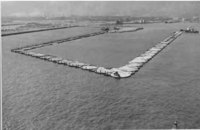
→ 施工中の摩耶ふ頭第4突堤
