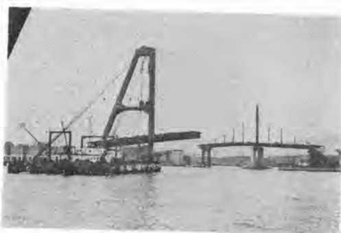
写真-6 P_8 \sim P_9 仮支柱径間のけた架設状況
