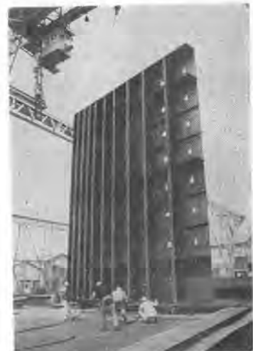
写真-3 鋼製L型の製作 (底面)
