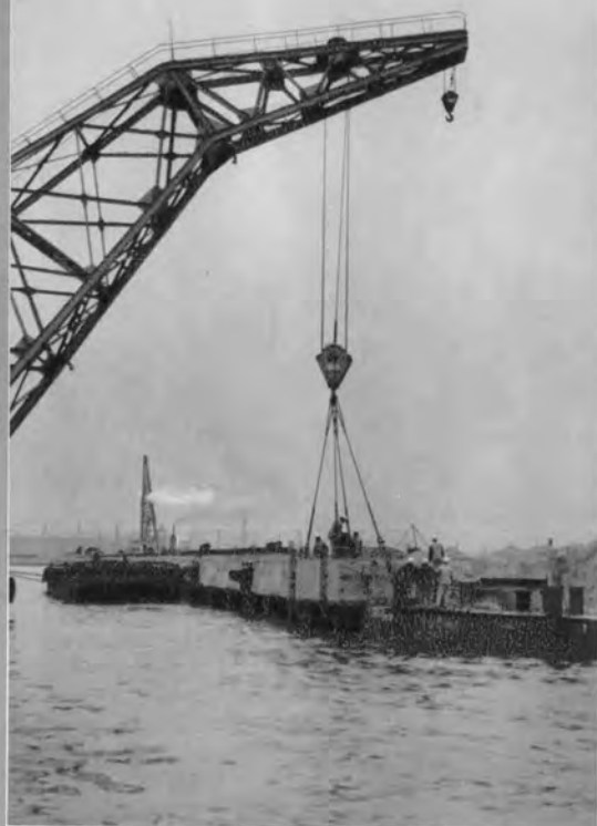
↑プレキャストけた運搬据付け
