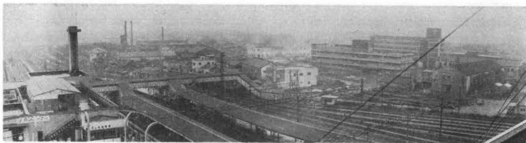
写真-6 相生駅(神戸方から相生駅構内を望む)
