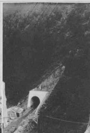
↑窪江線第4工区第1家地川すい道入口
