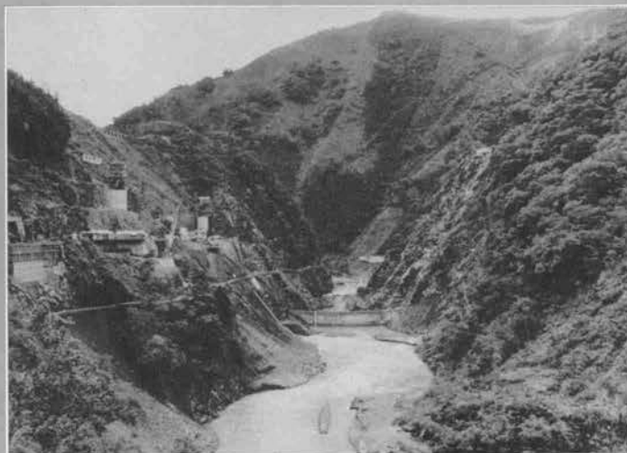
↑小見野々ダム掘削状況(上流より望む)
