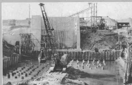
↑排水函きょ部分が竣工し、排水機場基礎の掘削中基礎ぐい(鉄筋コンクリートパイプφ=300mm l=12m)をディーゼルハンマ(20型)で備ぐい打ちした。
