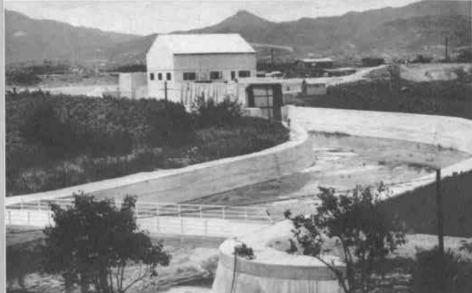
↑完成した川島地区第1排水機場 横型斜流ポンプ(排水容量6m 3 /sec 2台)
