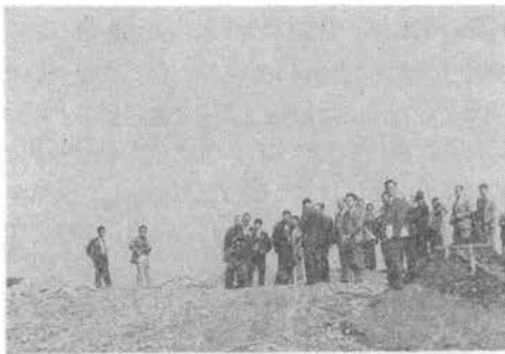
写真-3 東名高速道路富士川工事現場
