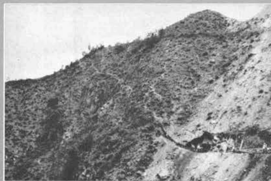
↑工事前の状況（この山腹を片切片盛した）
