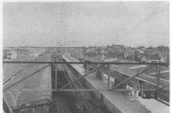
写真-4 西明石駅—この上部を山陽新幹線が斜めに通過する。（神戸方から門司方を望む）
