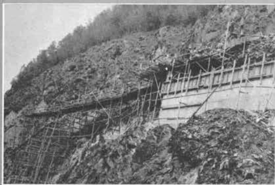
↑ 工事中の状況（山腹に擁壁を作り、擁壁と地山の間に盛土して路体とした）
