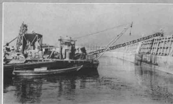
↑ 台船仮設による堤体コンクリート打設中 (TP+1.20m~+3.20m)
