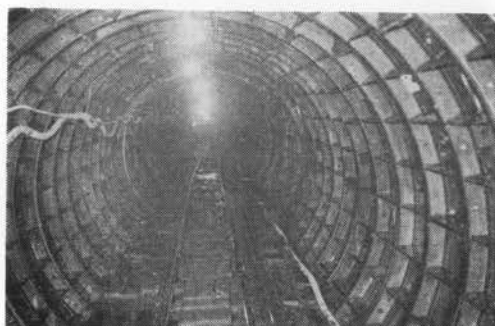
写真-11 セグメント組立完了
