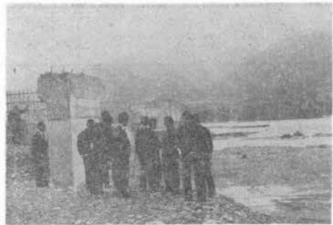
写真-4 東名高速道路富士川橋りょう工事現場
