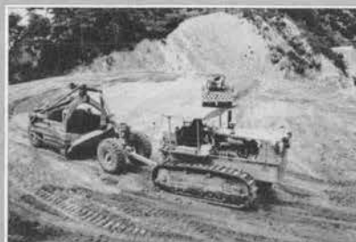
↑ 通谷調整池主堤用土運搬のキャリオールスクレーパーと転圧作業のタンピングローラ
