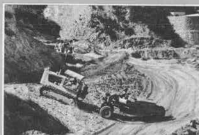
↑ 通谷調整池左岸上流部土取場におけるキャリオールスクレーパーによる築堤上の運搬
