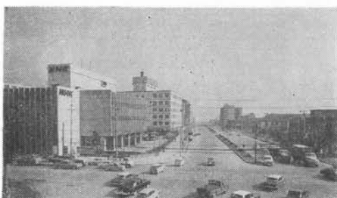
写真-1 谷四立坑から東の方、森の宮停留場方面を望む（中央の道路下を通過する）
