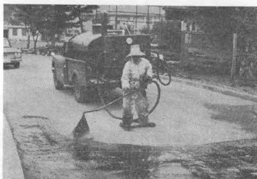
ローリー型アスファルトエンジンブレイヤー 1500ℓ
