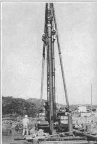
↑中村線第4伊与喜川橋りょう基礎ぐい打ち(鋼管パイル)
