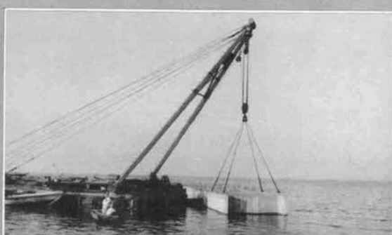
↑ 起重機船によるセルラーブロック据付け施工中 (ブロック重量(中空)約24t)
