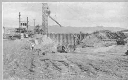
↑堤防開削および基礎掘削 堤防開削部は鋼矢板(l=12m)で仮締切りし、バックホウおよびダンプトラックの組合せで掘削した。
