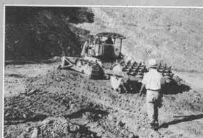
↑ 通谷調整池主堤築土のかきならしと転圧作業のD50ブルドーザーとタンピングローラ
