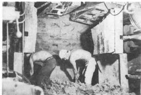
写真-4 最上段中央部の掘削作業中
