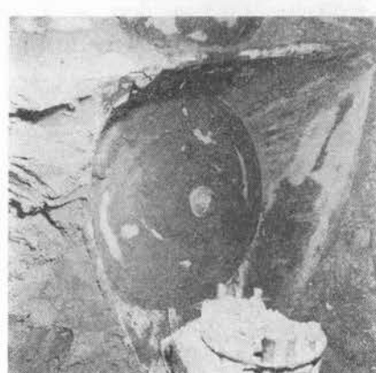
写真-10 立坑へ出たシールド前面上部
