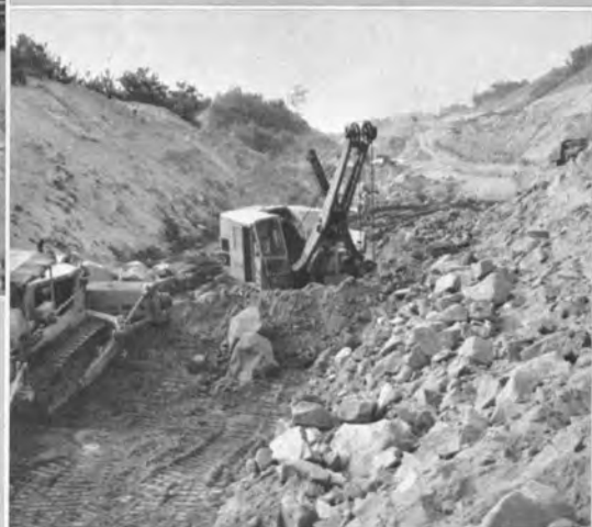
→ 名古屋建設局岡崎付近：花こう岩地帯を 路線が通過するため、ショベル掘削でも 相当大きな岩塊が生ずる。
