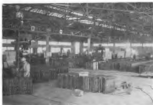
写真-6 第5工場セグメント組立ライン
