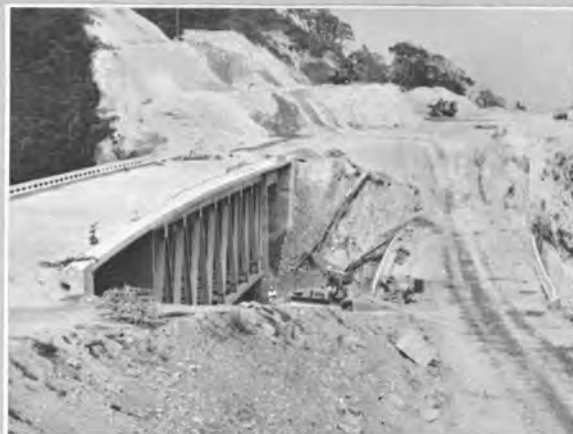
蒲原工事由比港橋のコンクリート打設状況
