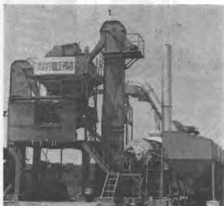
KYC アスファルトプラント
