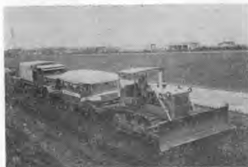
写真-2.1 ブルドーザのけん引試験
