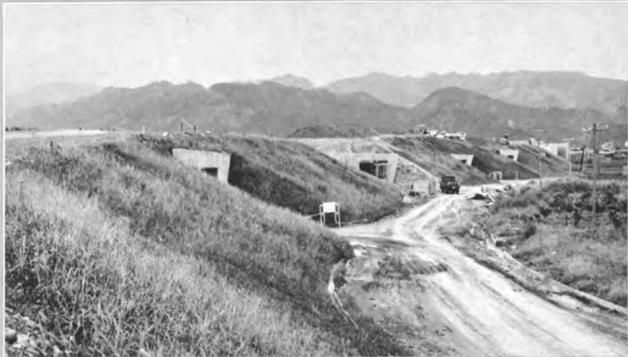
↑ 清水東工事清水インターチェンジ付近： 土作業はほぼ完成して、上部路床の整形が実施されている。
