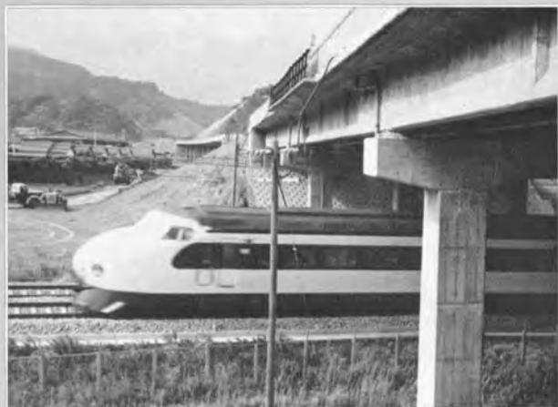
↑ 国鉄東海道新幹線を跨ぐ岩淵高架橋：事前着工により 新幹線開通までに工事が完成していた。
