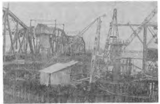
写真-4 荒川橋りょうのケーソン施工中
