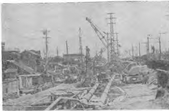
写真-2 リバースサーキュレーションドリル施工中
