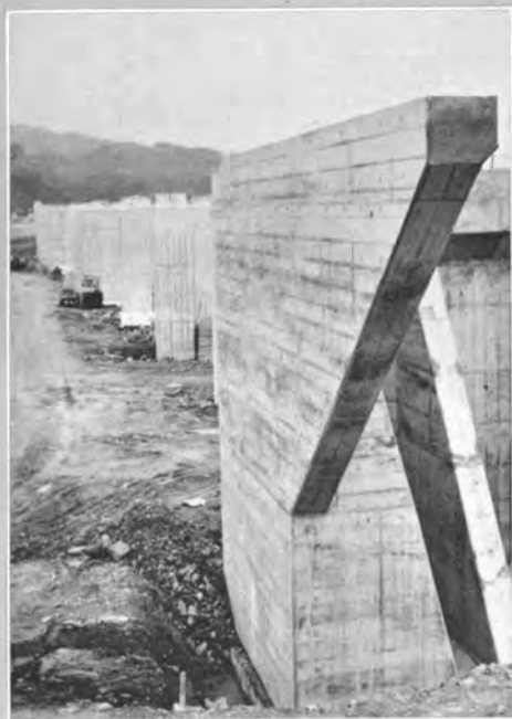
← 清水西工事の高架橋下部工
