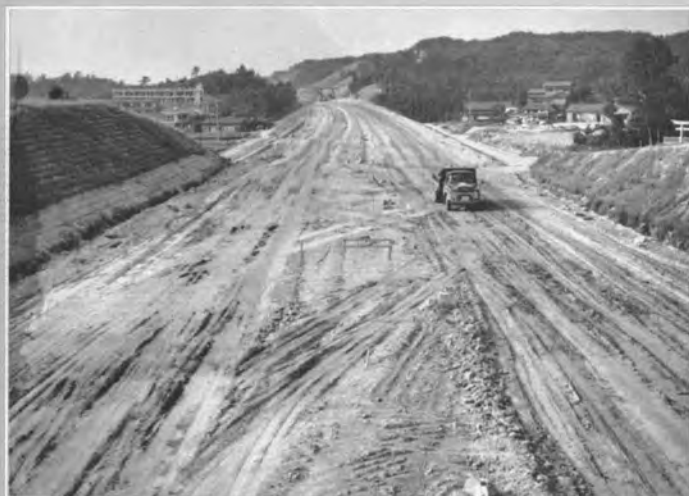
← 下部路床面まで仕上げた岡崎工事の一部
