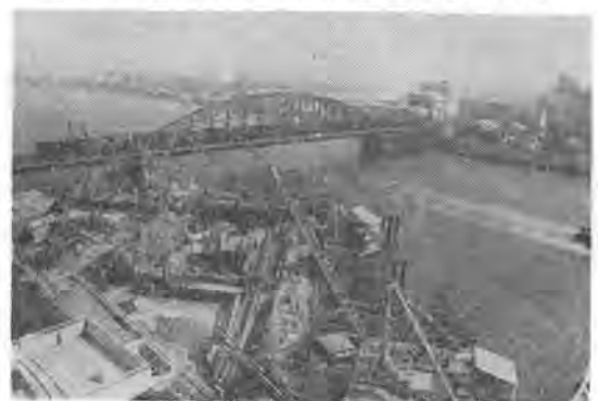
写真-1 隅田川右岸ケーソン No. 1, No. 2 東京起点 2.4 km 付近(東京方より望む) (昭和 41 年 10 月 15 日・両国工事区)
