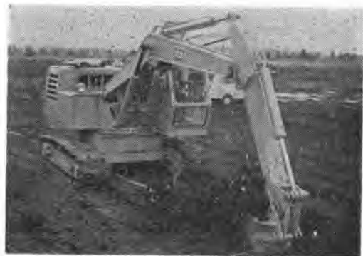
写真-71.1 みぞ掘り作業試験中の日立UH03型油圧ショベル
