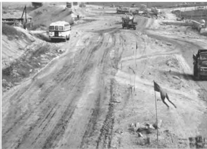
→ 名古屋建設局岡崎付近：花こう岩地帯を 路線が通過するため、ショベル掘削でも 相当大きな岩塊が生ずる。
