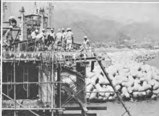
蒲原工事由比港橋のコンクリート打設状況
