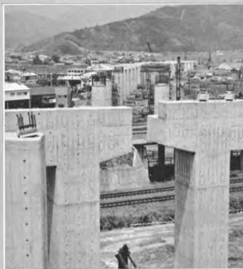
↑ 下部工の大部分が完成した中吉田高架橋
