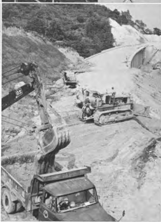
↑ 蒲原工事向田川橋付近の切土作業
