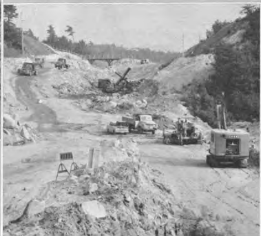
→ ショベルとダンプによる切土作業 (岡崎工事)
