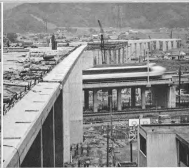
↑ スラブのコンクリート打設が進む中吉田高架橋： 延長約1,327mのほぼ中間で国鉄新幹線と交差する。
