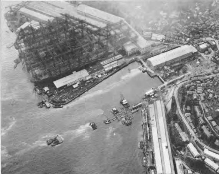
← ケーソン沈設位置の浚渫（着工当時） （上辺は既存船台）
