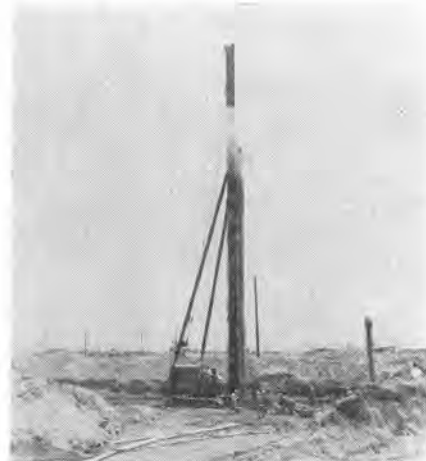
写真-2 稼働中の直結パイルドライバ付 U 106 ASL
