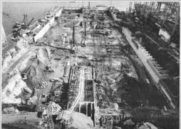
→ 渠内工事全景
