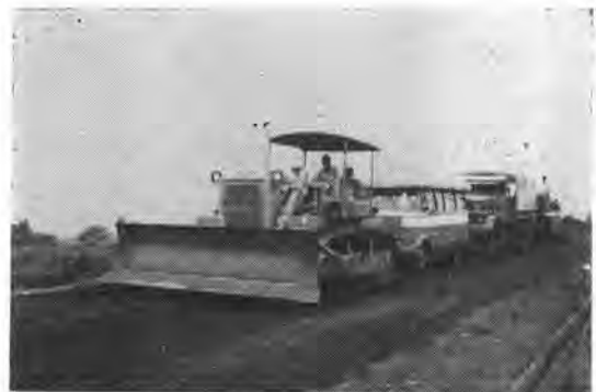
写真-74.1 けん引試験中の CAT D6C 型ブルドーザ
