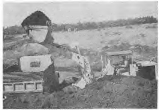
写真-3-2 車輪式トラクタショベルの積み込み作業試験
