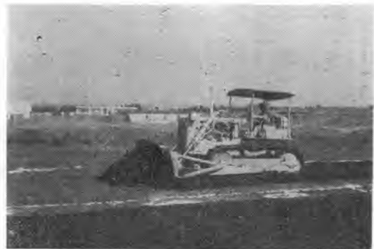
写真-75.1 作業試験中の CAT D6B 型ブルドーザ
