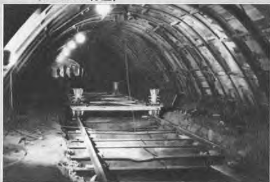
↑篠栗ずい道坑内上部半断面掘削 (出口付近)
