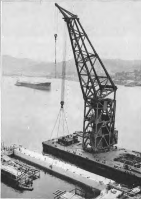
↑最終締切工事 （150t浮クレーンにて本ゲートの建付中）
