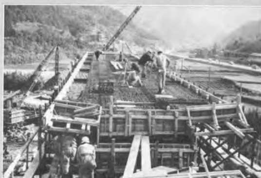
↑第2多々良川橋りょう施工中
