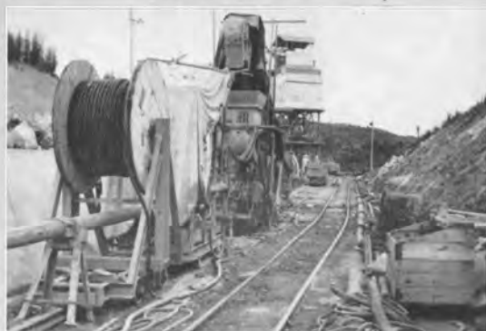
↑篠栗ずい道 (延長4.550m) 出口切取 (9.400km付近)
