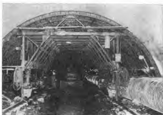
写真-2 風管の布設状況
