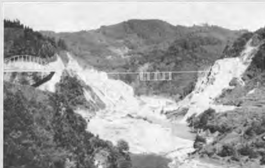
↑上流側から眺めた松原ダムサイト
