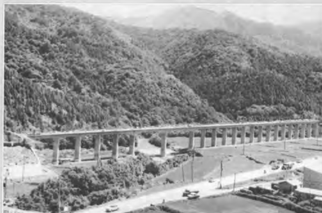
↑第2多々良川橋りょう全量 (2.200km付近)
