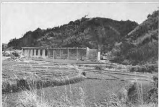
↑黒石橋りょう全量 (10.660km付近)
