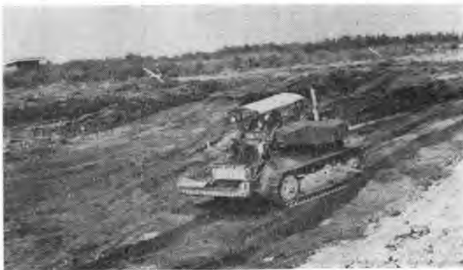
写真-4 スクレーブドーザ
