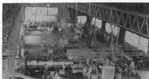
写真-1 千葉整備工場内部
