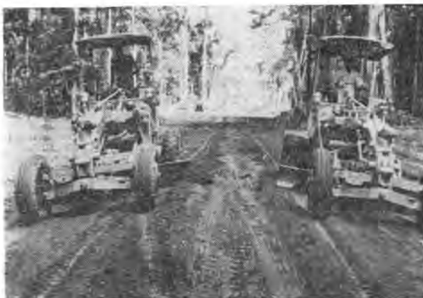
写真-2 ジャングル内の中央道建設
