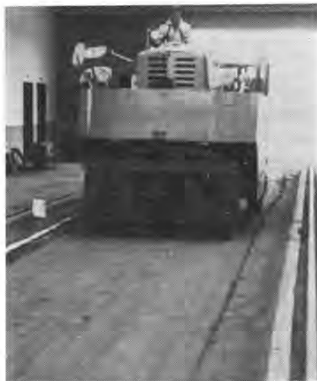
写真-4・1 土の締固め試験中のタイヤローラ
