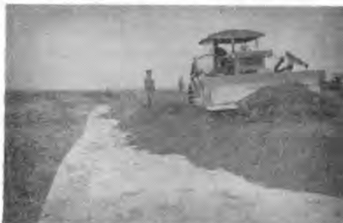
写真-11 ヘドロ上の道路盛土試験状況 (八郎潟)
