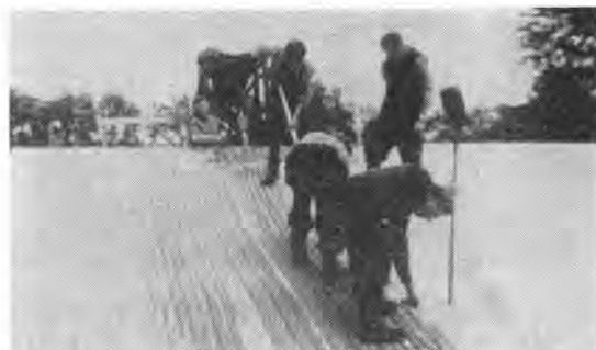
写真-4 オランダ・エムス河の水路斜面保護の施工状況
