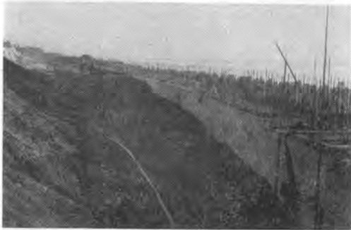
写真-2 (b) 海砂による盛土
