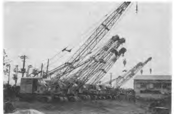
写真-1 クレーン置場
