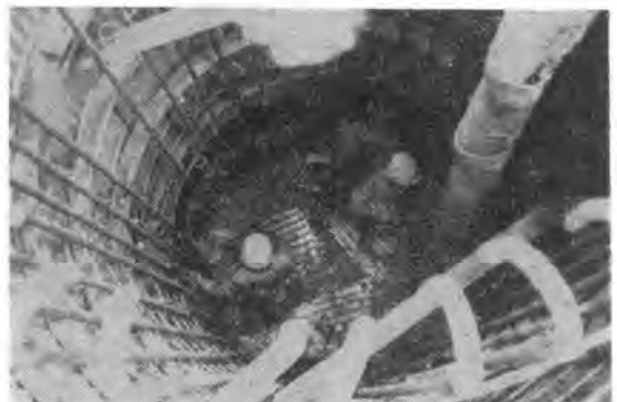
写真-4 深礎コンクリート打ち
