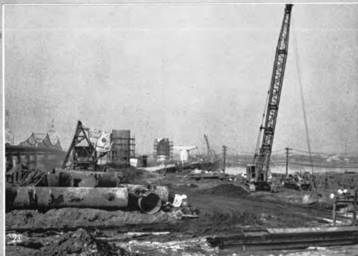
㉒ コンクリートタワー設備による梁コンクリート打設作業 パイプサポートおよび梁の木製型わくが非常によく仮設されている。
