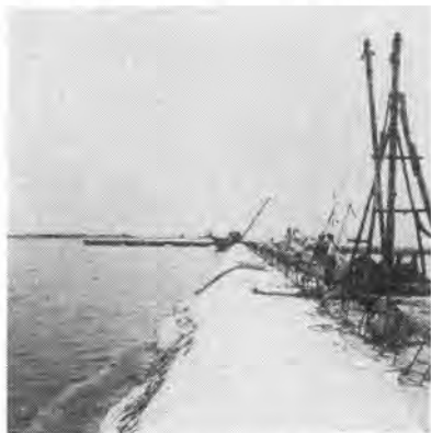
写真-2 岸壁保護工事の一例
