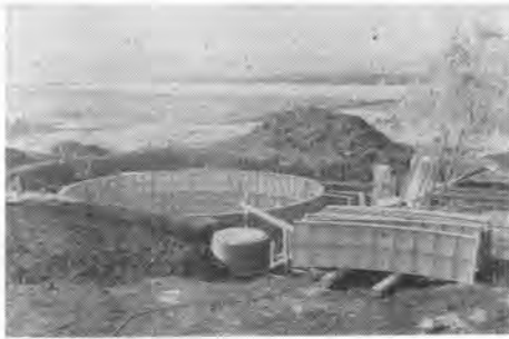
写真-13 立坑上部施工中
