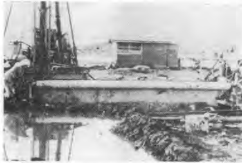
写真-5 ビニロンターポリンによるシャホ膜工法
