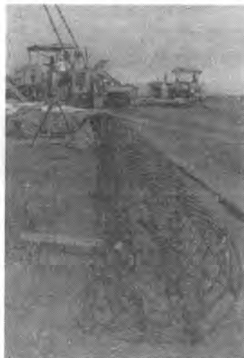
写真-6 ベノトぐいの鉄筋
