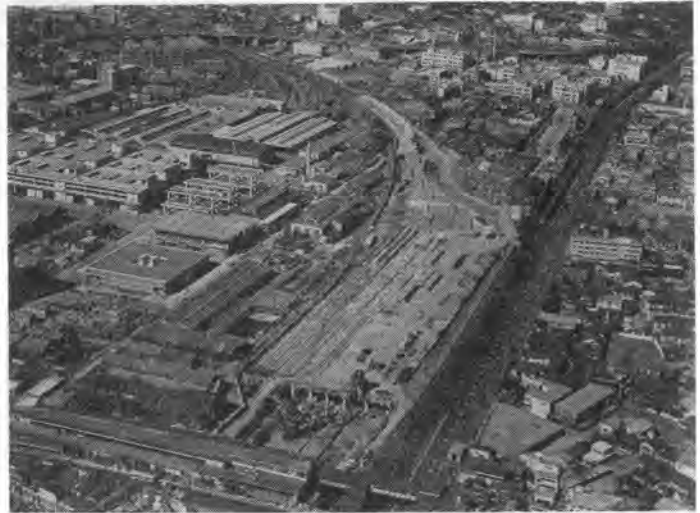
写真-1 工事地区全景
