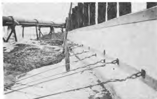
写真-3 埋立工事における土の流亡防止柵の一例
