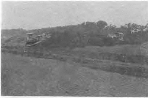
写真-2 (a) 海砂による盛土
