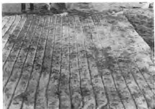
写真-7 マットレスによる斜面保護
