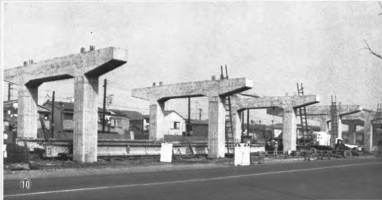
⑩ RC T形橋脚の完成
