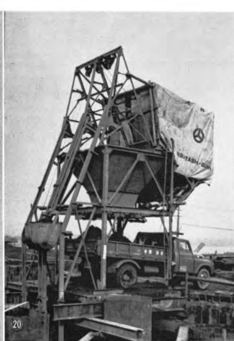
⑳ スキッパー設備を利用した締切内掘削作業
