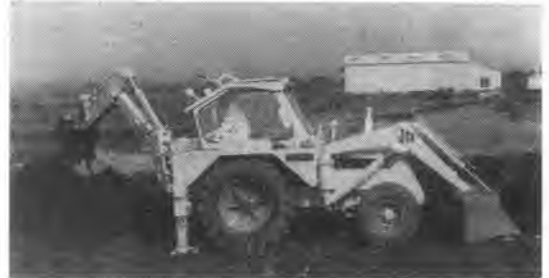
写真-78.1 みぞ掘り作業中の 汽車製造 KSK・JCB-3型エキスカベータ
