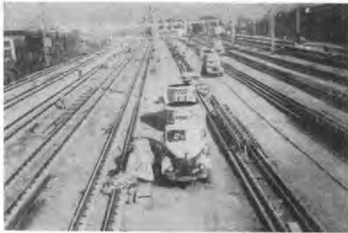
写真-7 施工中のコンクリート道床
