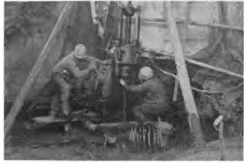
写真-10 B.H.P. 工法による止水壁工事
