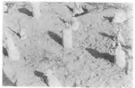
写真-6 東海製鉄におけるマイス工法施工状況
