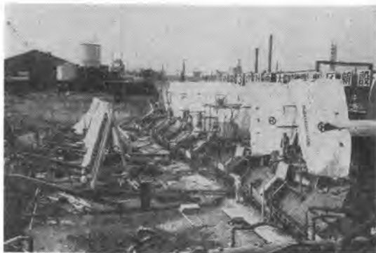
写真-3 掘削中の深礎工
