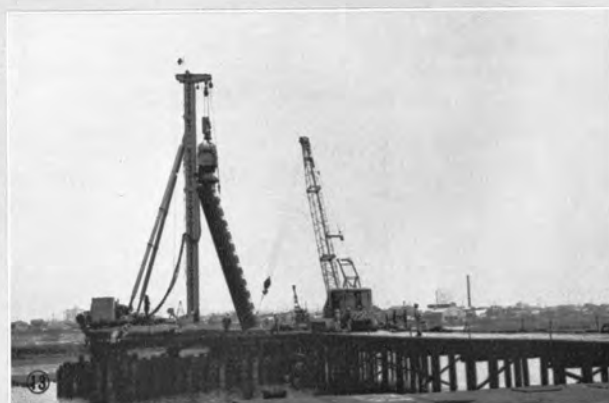
⑫ トラッククレーンに取付けられた落錘（角分銅）によるシートパイル打ち作業 現場は多摩川大師橋下流約100mの地点で、仮栈橋上から行なわれる。
