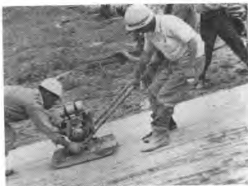
写真-8 マットレスの転圧状況
