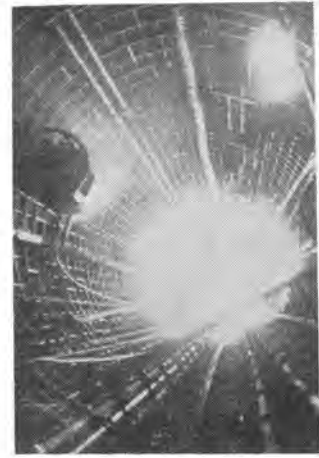
写真-12 立坑内部より上部を望む
