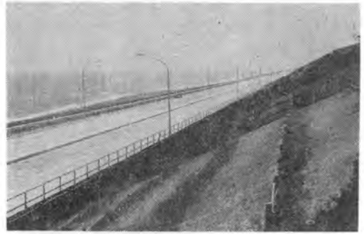
写真-3 のり面保護工 (芝吹付けおよびよし工)
