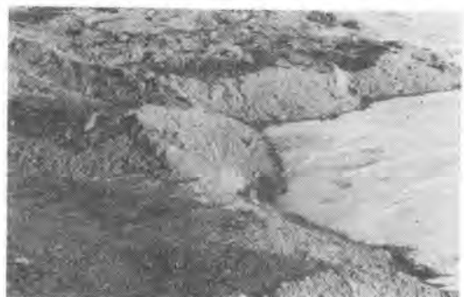
写真-12 まき出し先端部に発生するシートの引張力 (福山)
