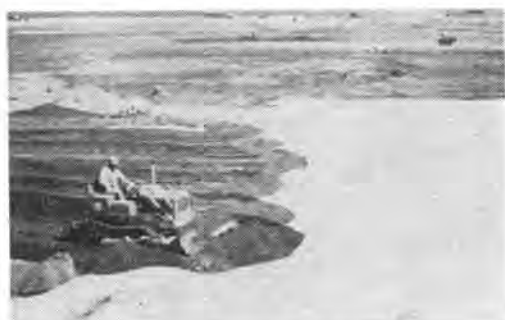
写真-13 シート上のまき出し施工状況(堺)
