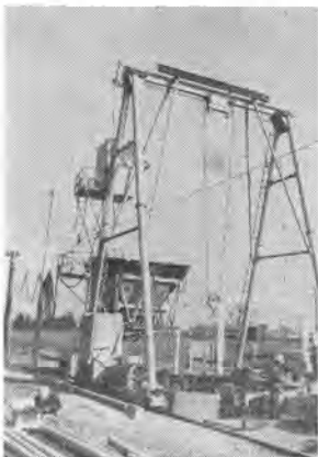
写真1 浅い立坑に適するずり上げ設備
