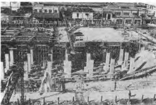
写真-6 鉄筋コンクリート工
