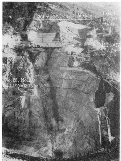
写真-3 奈川渡ダムサイト右岸施工状況 (41年10月末)
