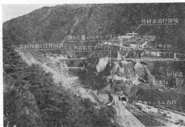
写真-5 稲核ダムサイト施工状況(41年10月末)
