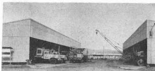
写真-2 重機格納庫
