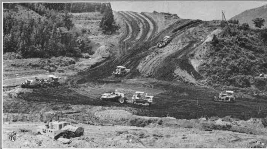
⑭ キャリオールスクレーパによる土のまき出し作業 (西桂地区)
