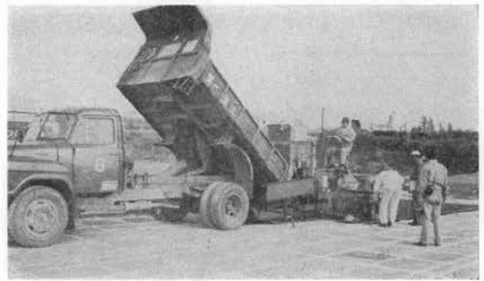
写真-7-1 アスファルトフィニッシャ舗設試験
