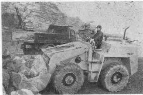
写真-2 トラクタショベルの碎石原石積込み試験
