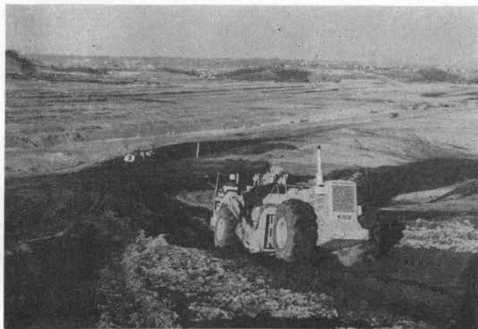
写真-5 切土部からみた現場の一部とはじめて登場したツインモータスクレーパ
