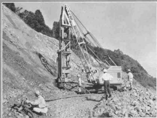
⑦ 藤野東工事(マキナンテリーによる硬岩掘削)
