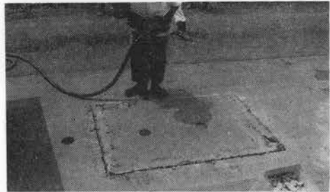
写真-5 フォースパッチャのアスファルト舗装版破壊試験
