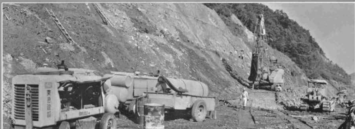
⑧ 藤野東工事(マキナンテリーによる硬岩掘削 全景)
