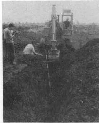
写真-3 油圧式ショベルの掘削試験
