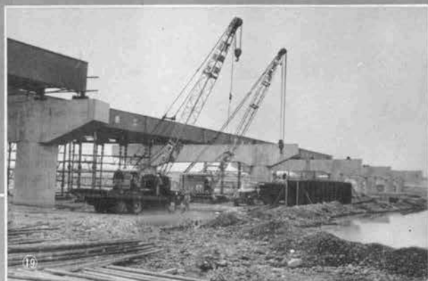
⑲ 桁架設中の多摩川橋
