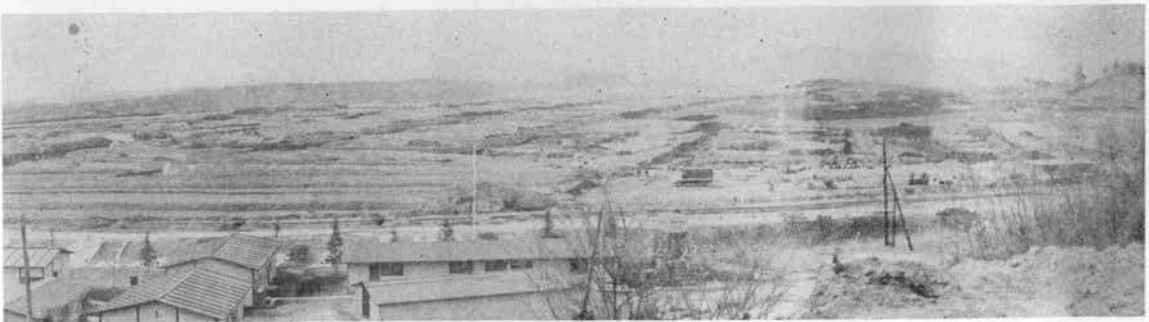
施工状況(上の写真は昭和 41 年 11 月、下は昭和 42 年 3 月)
