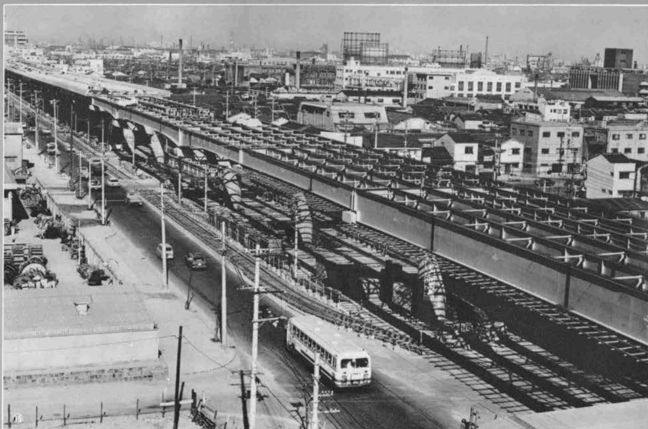
⑮ 神戸 柳原一月見山間 鷹取町付近 市電を仮移設してその中央で工事を進めている。工事完了後は市電は高速道路の路下に収められる。
