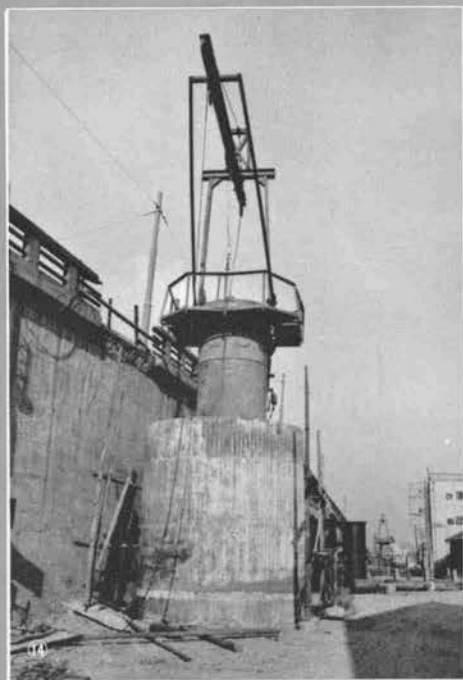
⑭ 神戸 柳原一月見山間 明治橋付近 高さ8mにも及ぶ擁壁とわずか0.5mの距離に深さ20mのケーソンを沈設中
