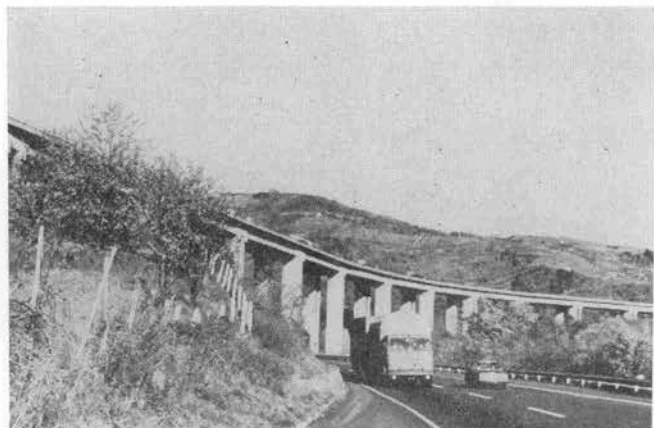
写真-7 イタリア・ミラノからジェノバへ至る道路 (下が旧道路で下り専用、高架が新道で上り専用)
