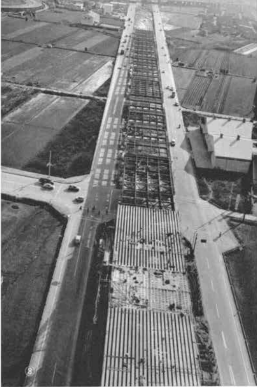
⑨ 大阪3号線 天満入堀中の下部工事 基礎はウェル、昔ながらのデリッククレーンが活躍しているが、この機械は据付けが簡単なこと、損料の安いこと、アーム長の長いものが得られるなど、捨てがたい面がある。
