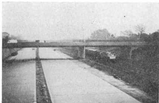
写真-1 イギリス・M1 新設工事中
