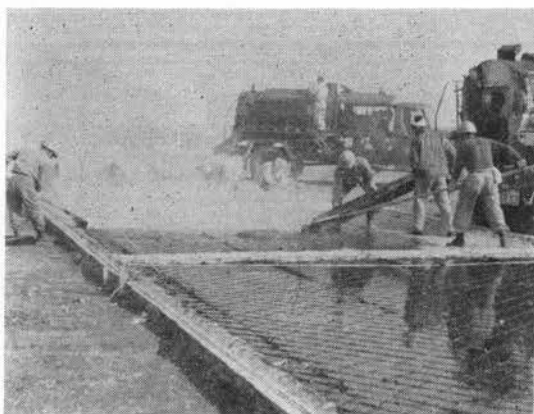
写真-6 アスファルトクッカによるマスチック合材の流し込み作業中
