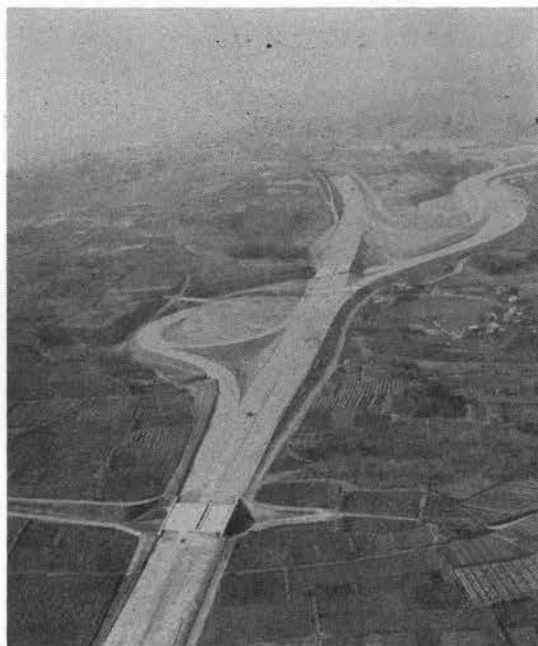
写真-1 舗装着工を待つ八王子インターチェンジ付近 （府中側上空から富士吉田側を望む）
