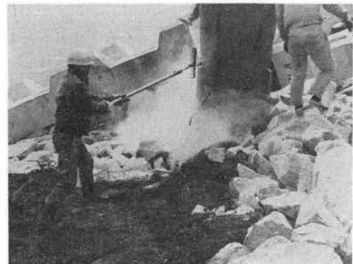
写真-4 サンドマスクを特殊バケットにより流し込み中
