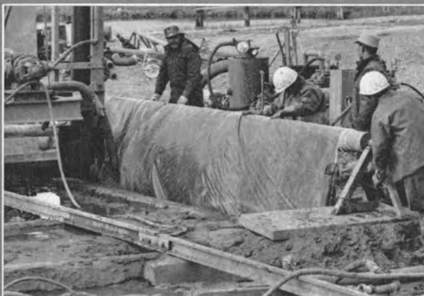
↑シートセッティング中のトレンチ穴 (千葉・小櫃川モデル河口湖止水実験工事)
