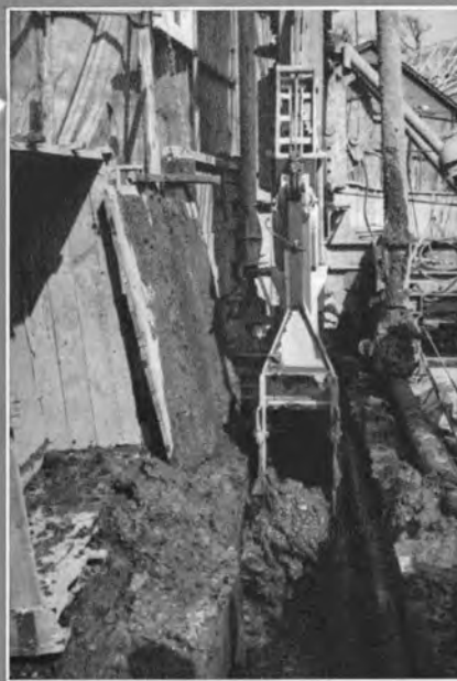
エルゼ掘削機で側方掘削中
