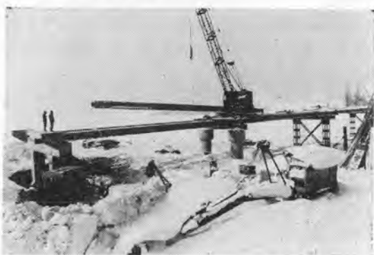
写真-5 冬期降雪時の工事施工
