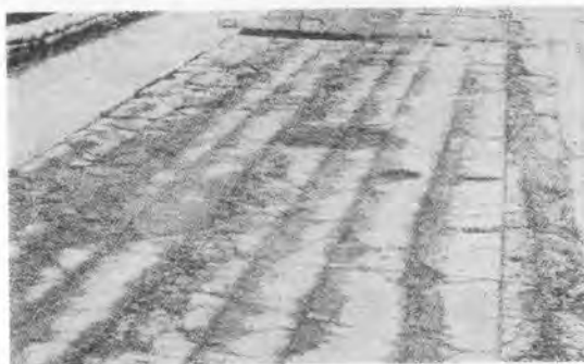
写真4 デルマックのランマにより破砕されたコンクリート版の表面
