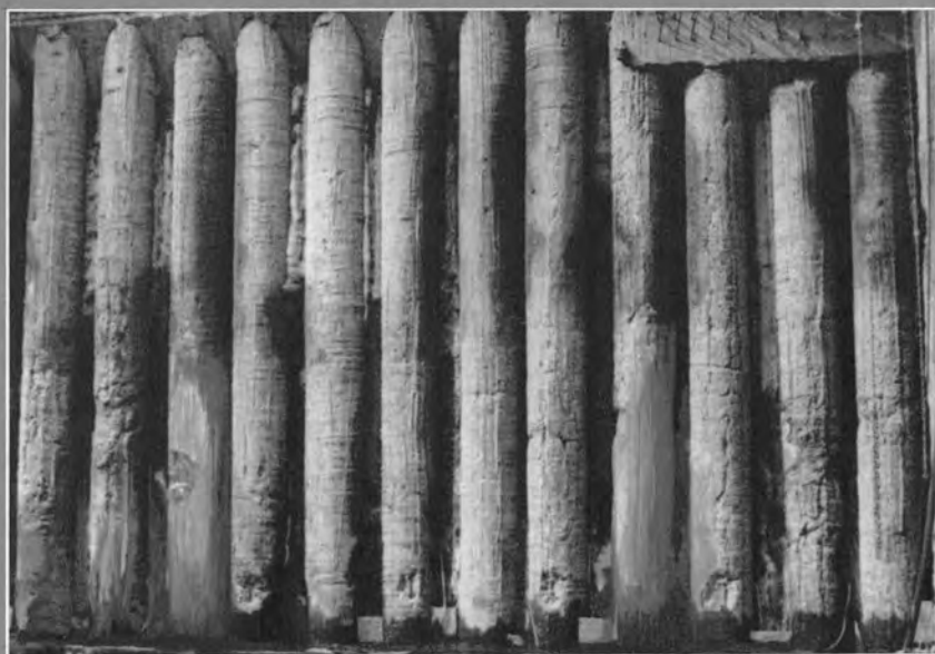
↑霞ヶ関超高層新三井ビル基礎工事の ジェットウォール工法による土留壁
