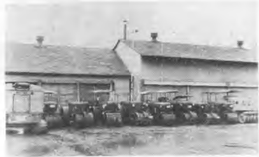
写真-1 整備工場の一部
