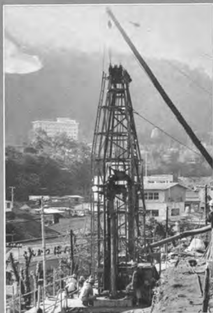
KCCドリル(輸入機)による硬岩掘削施工 (小田急・箱根 湯本駅工事現場)
