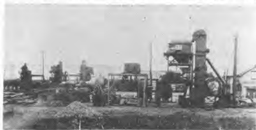
写真-3 舗装機械の整備
