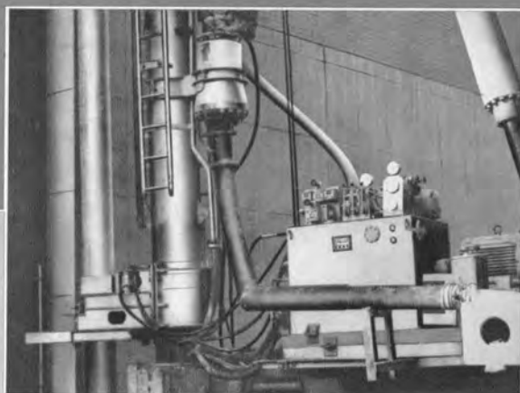
パイプロージャによるでき上り 場所打ちぐい（荻窪付近・環状8 号道路擁壁築造工事）
