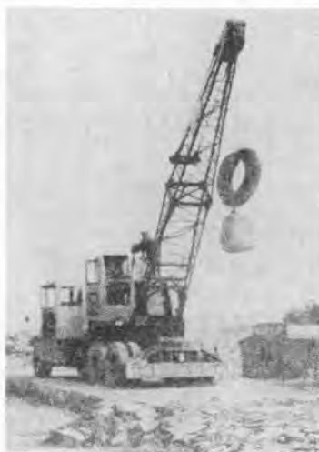
写真-2 重錘と打撃力のダンピングのためにトラックタイヤをつけた P & H のクレーン
