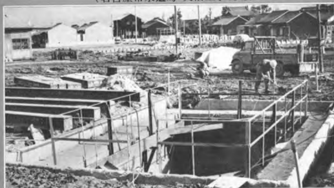
施工されたシャフト (名古屋市水道局 大治工事現場)
