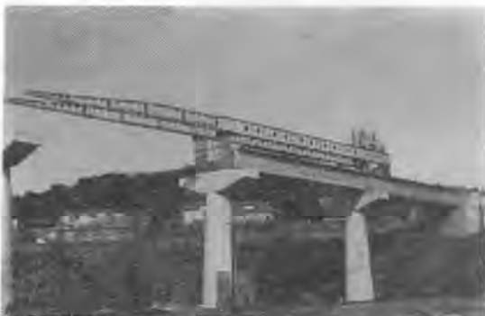
写真-3 東北線金田～目時間第7馬淵川橋りょう架設中
