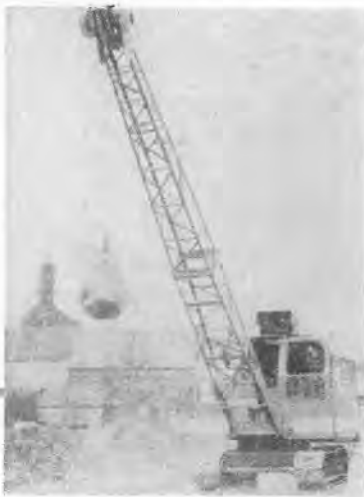
写真-1 コンクリート版を破碎するための 1.1t の重錘をつけたショベル
