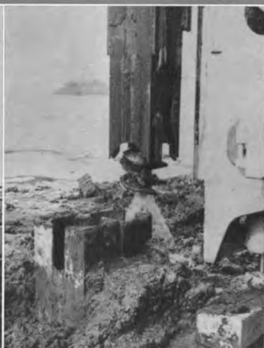
四角いケーシングによる T. A. W. 施工中の状況
