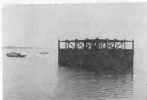
写真-8 えい航中の P、ケーソン
