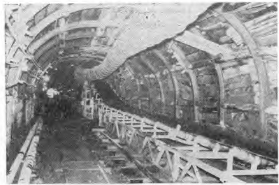
写真-3 1基 100 m のベルトコンベヤの接続部
