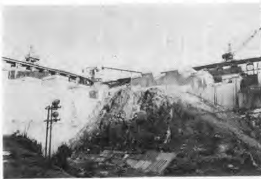
写真-3 下久保ダム建設状況
