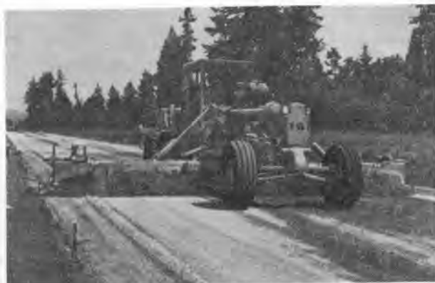
写真-1 9 m 幅ブレードによる敷きならし作業 速く正確な施工には、重量、馬力が大型のグレーダの選定が重要である。
