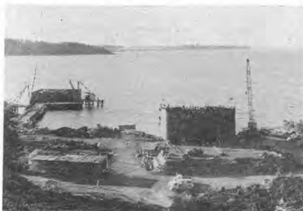
写真-3 造函・進水台および艀装栈橋(手前 P 1 , 奥 P 2 )
