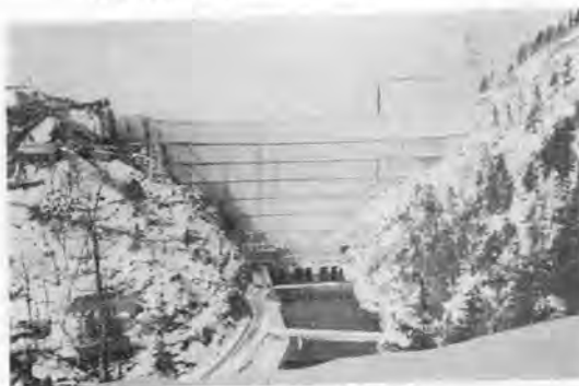
写真-2 完成した矢木沢ダム
