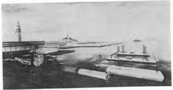
写真-3 トンネルセクションの沈設
