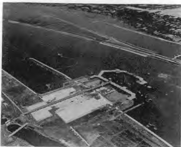
写真-1 利根川河口堰建設状況(昭和42年4月末)
