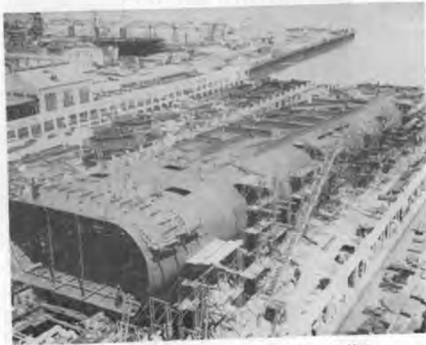
写真-2 造船所におけるトンネルセクションの築造
