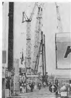
林立するクレーン
