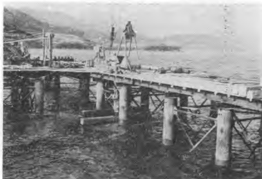
写真-5 鋼製支保わく(P 2 用)
