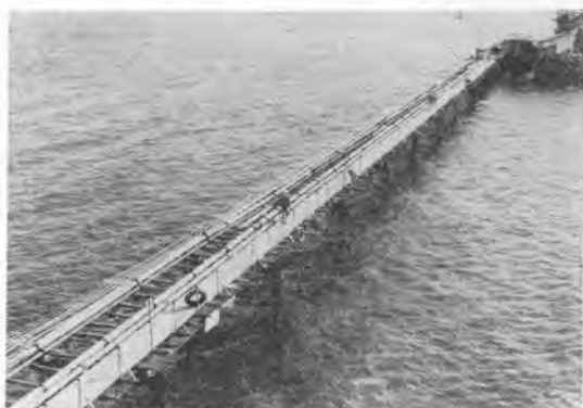
写真-2 鋼製栈橋(左から照明用電線、動力用電線、低・高圧送気管、コンクリートポンプ配管、歩道)である。
