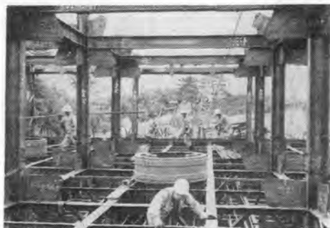
写真-6 組立中の P 4 鋼製ケーソン
