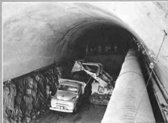
⑫ 側壁部コンクリート打設、足付け状況
