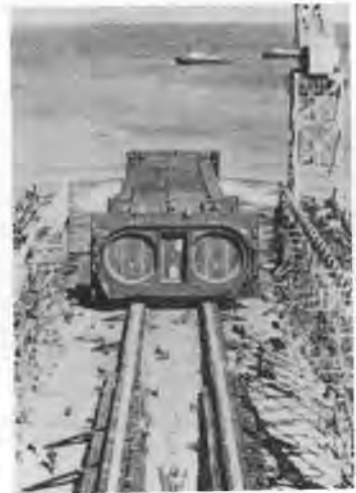
写真-1 トンネルセクションの進水
