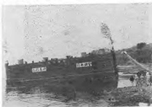
写真-7 進水中の P、鋼製ケーソン
