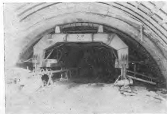
写真-5 テレスコピック型スライディング セントルフォーム（背面より）
