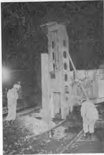
写真-2 くい打機 (H 鋼ぐい 2 本目溶接作業中)
