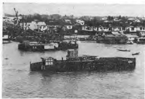
写真-4 仮締切り
