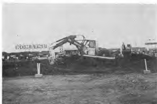
写真-14 小型油圧掘削機の実演
