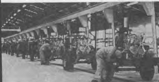
●200米コンベアラインの組立工場
