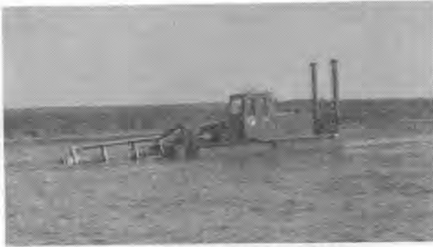
写真-3 小型ポンプ式浚渫船（建設省製）
