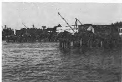
写真-3 基礎ぐいを打ち終わった状況
