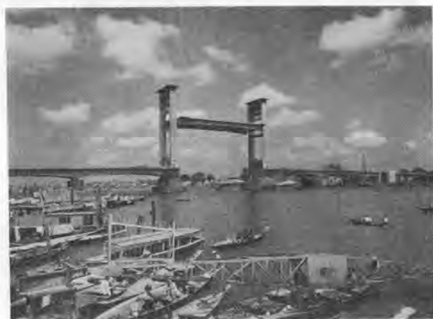
写真-1 ムシ河橋 (ブンカルノ橋) 全景
