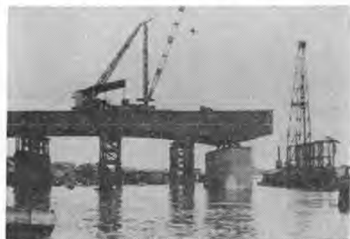
写真-7 けた架設状況
