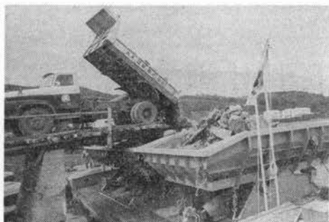
写真-1 石材の積出し
