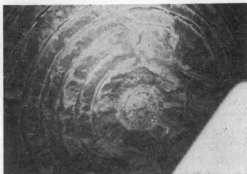
写真-2 切羽の状態
