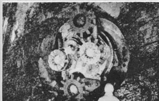
↑ ウォルマイヤ式クルップ改造機のドイツ・ エッセン炭坑坑道における貫通の瞬間 (グルックアウフ誌14巻7号より)
