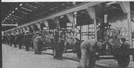
●200米コンベアラインの組立工場
