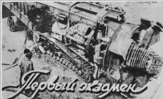
ソ連の坑道掘進機PK-8(1964) 掘削径3.4m 出力180 PS 自重57 t ↓ (グルックアウフ誌14巻7号より)
