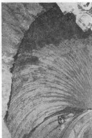
写真-2 ウォルマイヤ・ハベガ式掘進機で切削した切羽面
