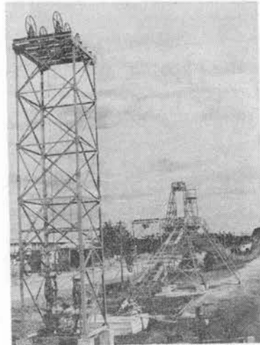
写真—6 平行線ケーブル架設の実験
