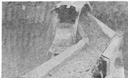
写真-2 しらす土壌の掘削
