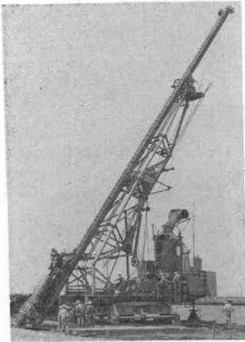
写真-2 くいの打込み(その2)
