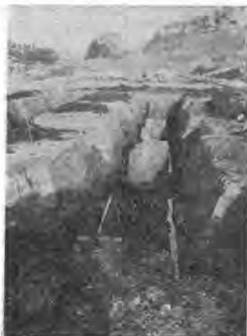
写真-2 掘り出されたでき上がりぐいの頭部
