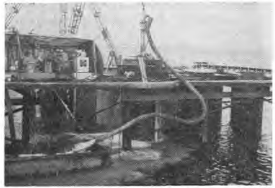
写真-2 水上におけるせん孔作業中
