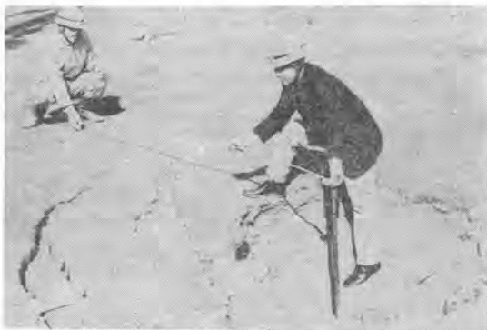
写真-6 地盤が少し軟かいときの沈下状況 半径 4 m ぐらいの所で影響している。
