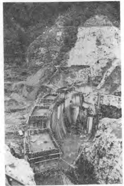
写真-3 稲核ダム工事現場
