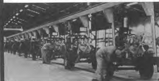
●200米コンベアラインの組立工場
