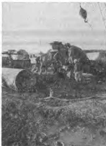
写真-4 トレミーを用い、ミキサ車からくぐりコンクリート打込みの状況
