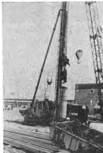
写真-6 NN 式 D-07 型万能掘削機による PC パイル施工
