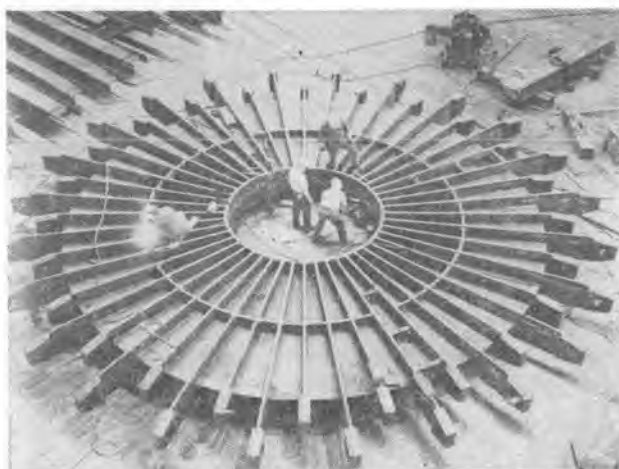
写真-2 テンションリング
