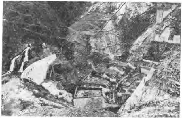
写真-4 水殿ダム工事現場
