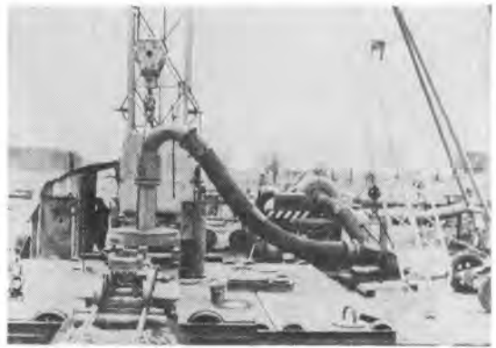
写真1 掘削作業中のザルツギッター・リバースサーキュレーションさく孔機 SC 500 型
