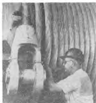
写真-1 ケーブルおよびテンションリングへの結合のためのU字形ソケット
