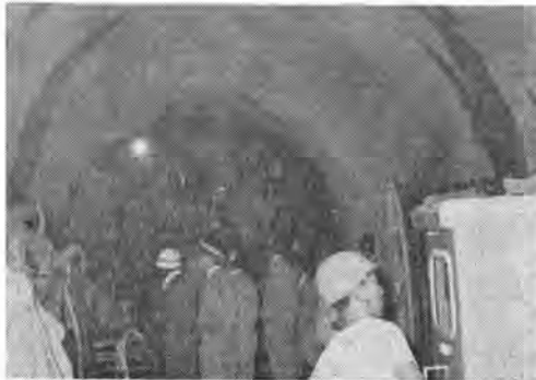
写真-1 坑底で切削作業に活躍するウォルマイヤ式トンネル掘進機を見学する見学会
