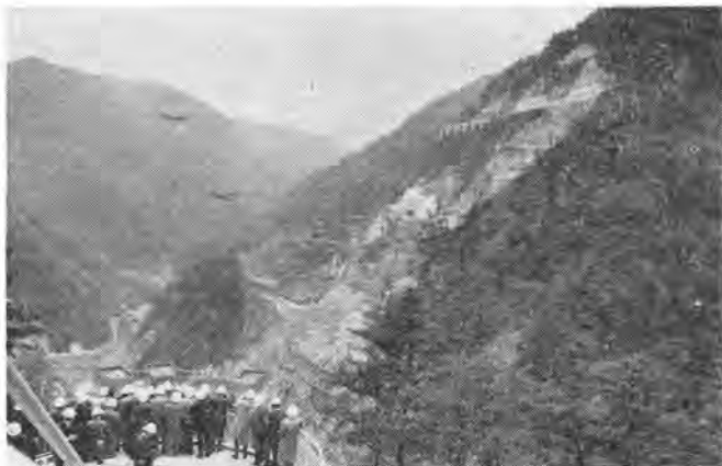
写真-1 奈川渡ダムの遠望
