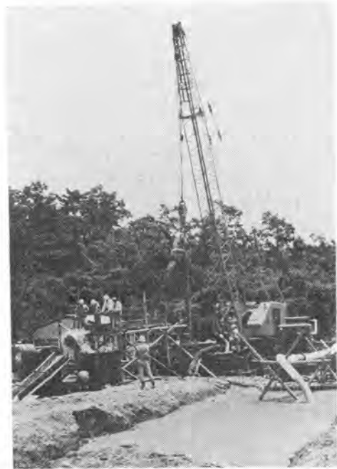
写真-3 L-4 形の掘削試験状況
