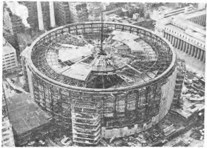
写真-4 建設中のスポーツセンター全景
