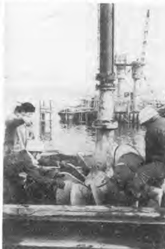
写真-3 せん孔が終わってエンピットの引上げ
