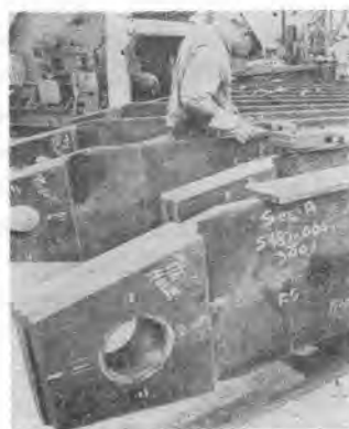
写真-3 テンションリングのケーブルの結合部
