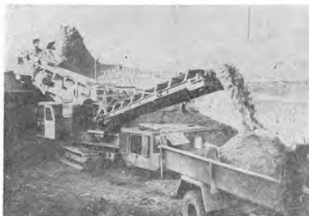
写真-2 作業中のラウハンマ 85
