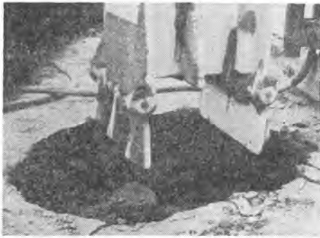
写真-3 ダイレクトパワーコンパクション下端に 装備されている自動反転開閉式押圧装置 にはね上げた状態で打込みを開始する。
