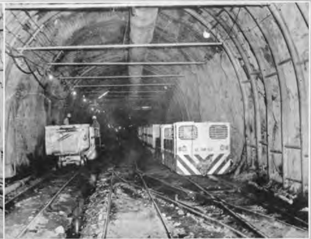
サイオントンネル内作業状況
