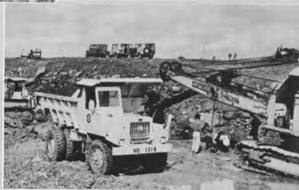
254km 付近両カット部(230,000m 3 )掘削
