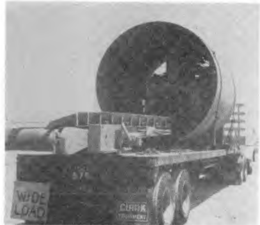
写真-2 シールド掘進機後部
