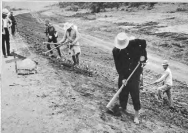
269km 付近盛土個所 のり面整理、締固め後人力にて整形
