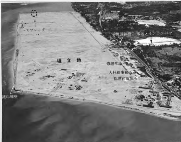
埋立地全景 10月現在約35%埋立進行中
