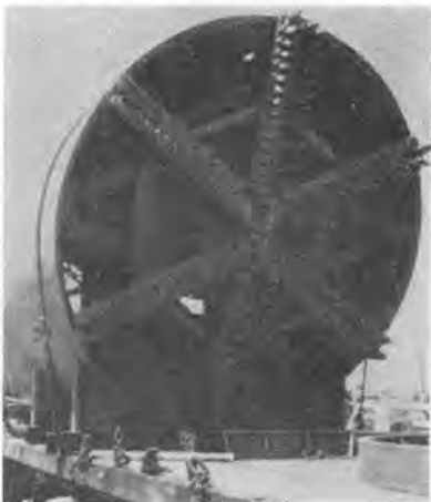
写真-1 カルウェルド製 シールド掘進機 の前部
