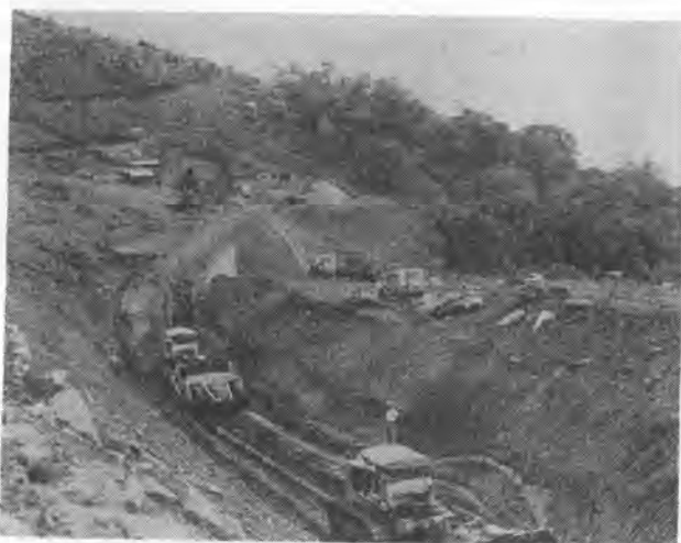
写真-3 両カット部掘削中(249.3km付近)
