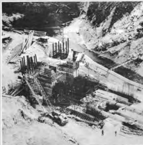
ブズダムの排水用取水口およびカルバート施工中
