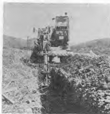
写真-19 TY45 油圧式ショベルの側溝掘りフロント (油谷 Poclair)
