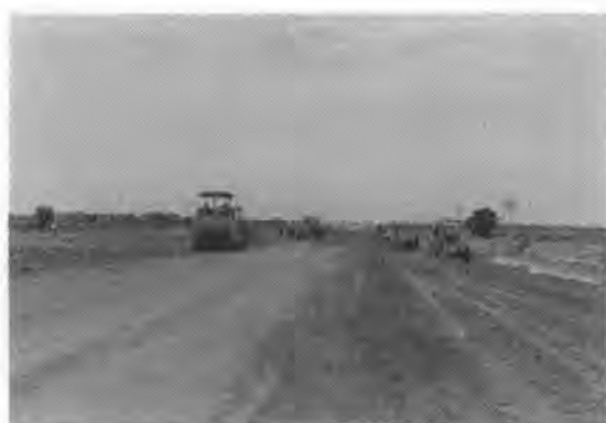
写真-1 STA. 53 付近サブグレイド造成中
