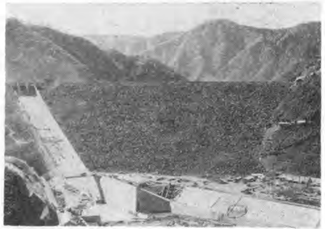
写真-1 盛立完了近い長野ダム（昭和42年11月4日）
