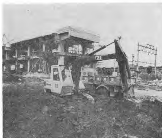
写真-1 H 208 油圧式ショベルの作業状況
