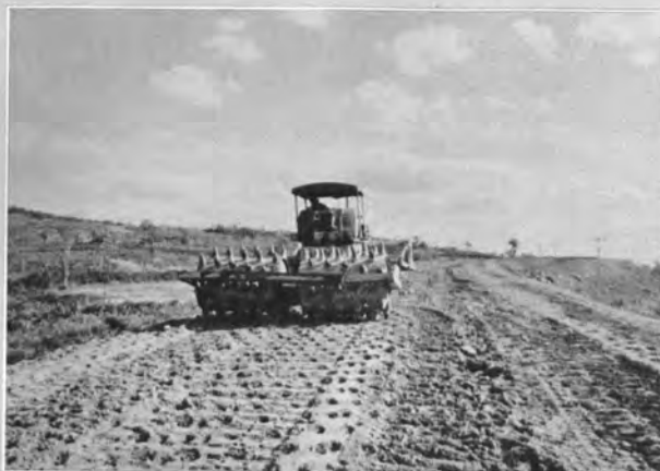
252k500m 付近ハイバンク盛立転圧作業中 (小松D-80A)
