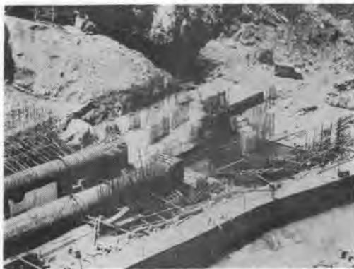
写真-1 ブズダム排水用バルブチャンパおよび取水口
