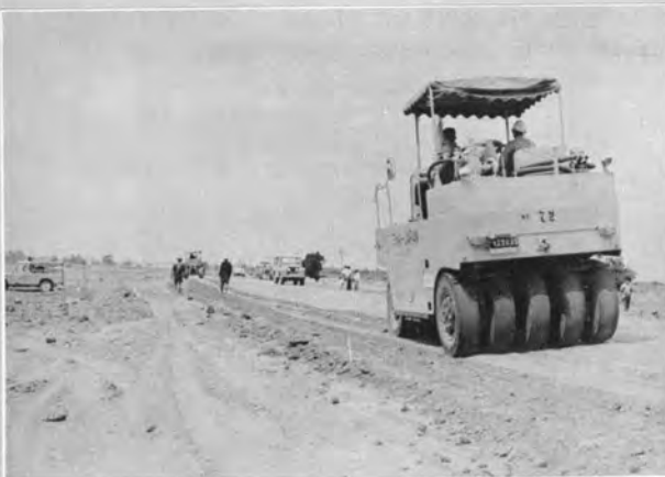
STA76付近SUBGRADE造成中
