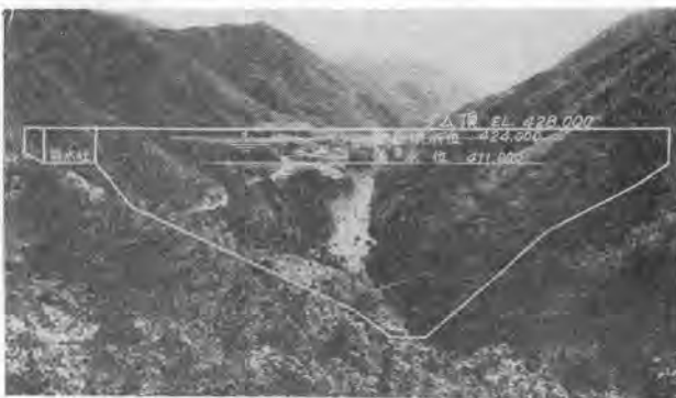
写真-1 ダムサイト
