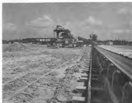
写真-1 スプレッドによる埋立中 手前のベルトは前方のスプレッドへ土を搬送 後のリターンベルト
