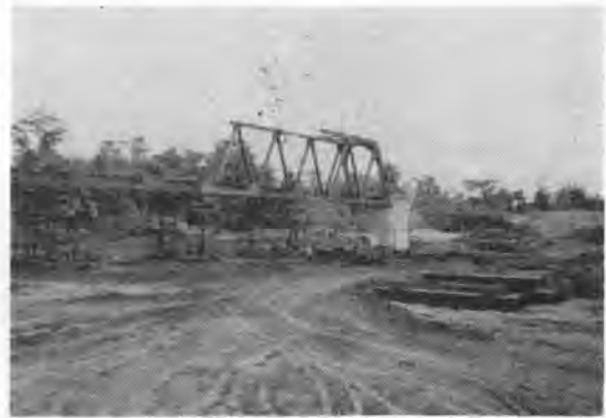
写真-4 第5橋りょう(53m スパン)架設中(278.3 km)
