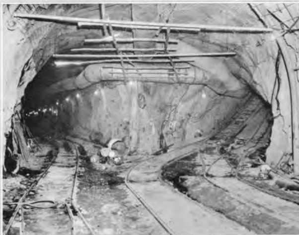
サイオントンネル斜坑と水平坑の交差点付近
