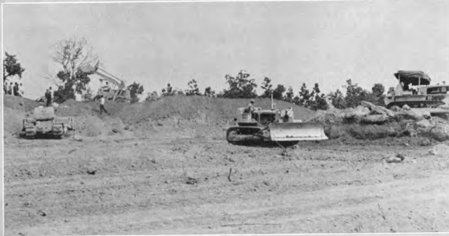
STA102付近切土掘削中
