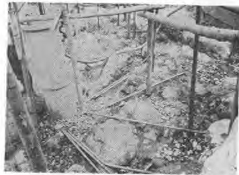
写真-2 湧水処理の状況(昭和41年6月)
