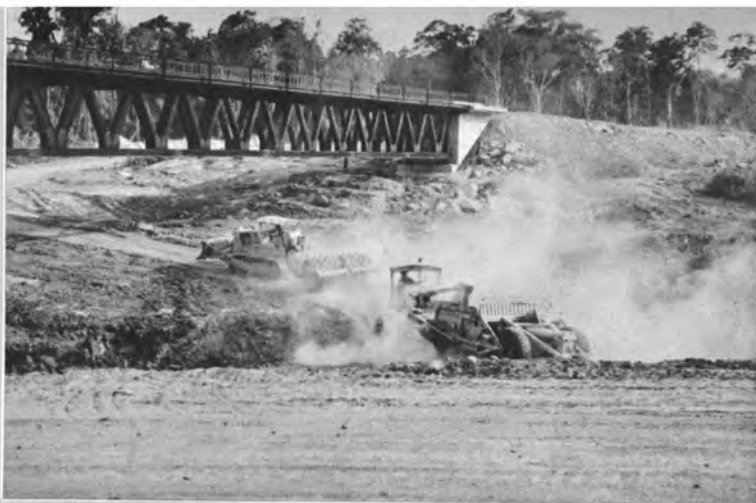
259k600m 第3橋りょう (2スパン、連続トラス104m) 架設完了後の河床整理
