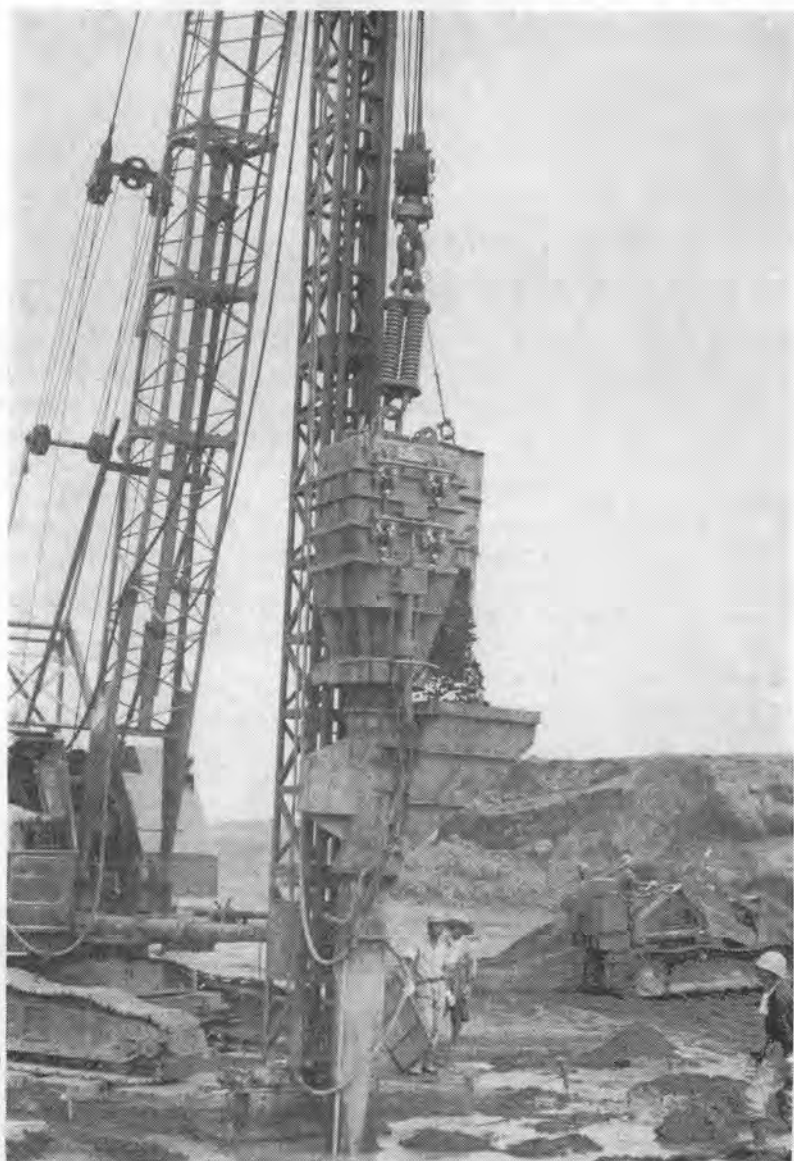
サンドパイル20m施工中
