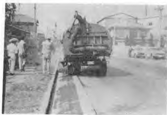
写真-2 富士市内国道139号線における実作業状況
