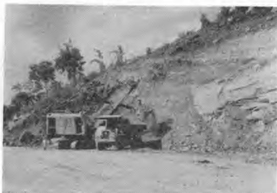
写真-2 第1工区の難所100,000m 3 切取り箇所(248.75km)
