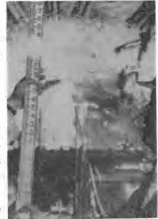
写真-2 ターゲットロッド上にビームを照射し、こう配の測量
