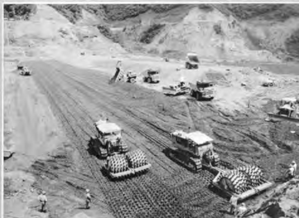
土質しゃ水壁の盛立て全景 (42.8) シープスフートローラによる締固め作業
