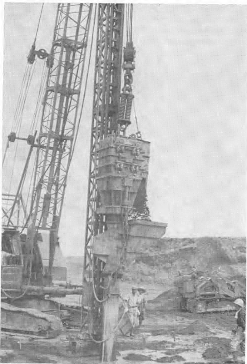
サンドパイル20m施工中
