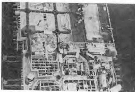
写真-5 建設中のプラットフォーム
