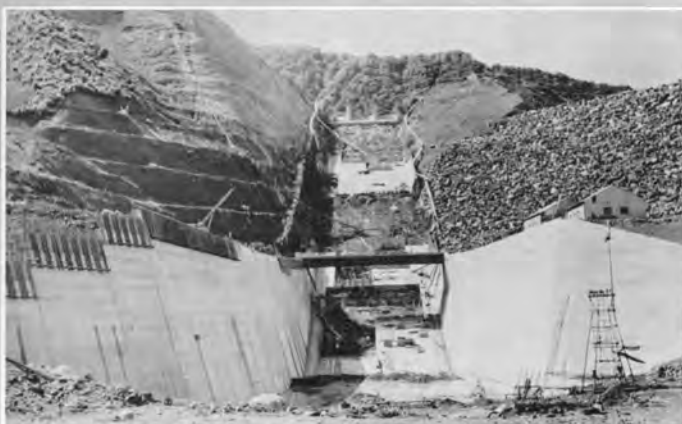
洪水吐コンクリート打設(42.6)
