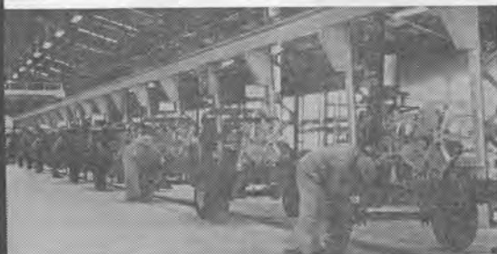
●200米コンベアラインの組立工場
