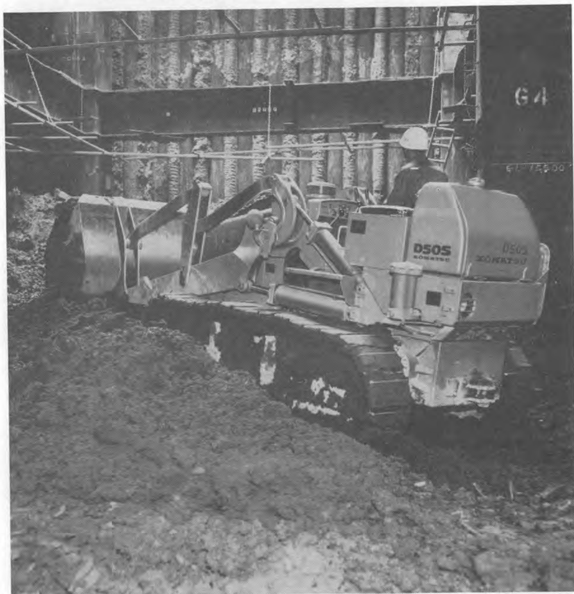
〈地下工事で活躍中のD50S〉
