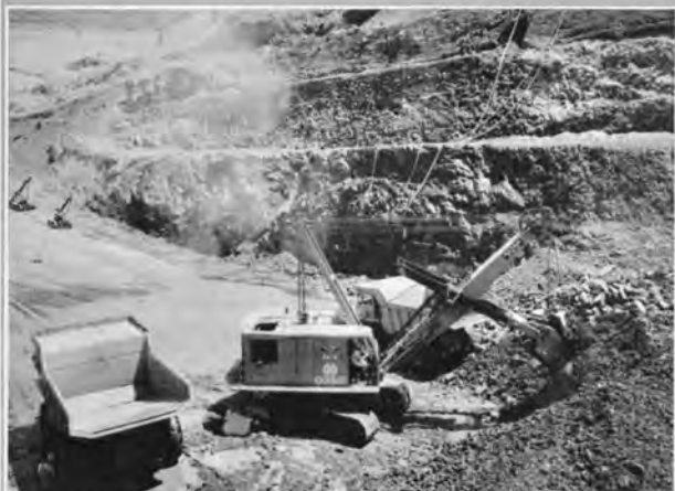
洪水吐下部掘削状況 (41.6)
