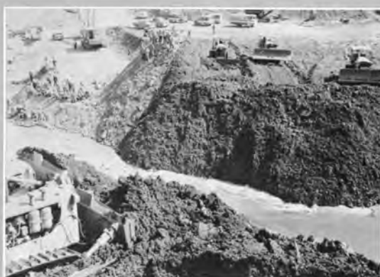
上流第1次仮締切り (41.4)
