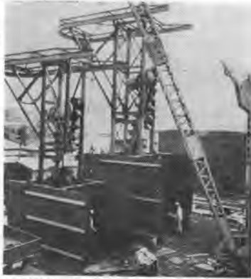
写真-3 トレンチシールド工法
