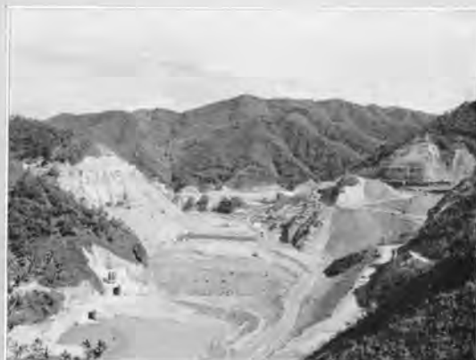
上流側よりダムサイトを望む(41.9) 1、2号仮排水路も完成し、左岸取水口前面の掘削、および右岸洪水吐掘削が進んでいる。 ダム盛立てE L.480 1,903,000m 3
