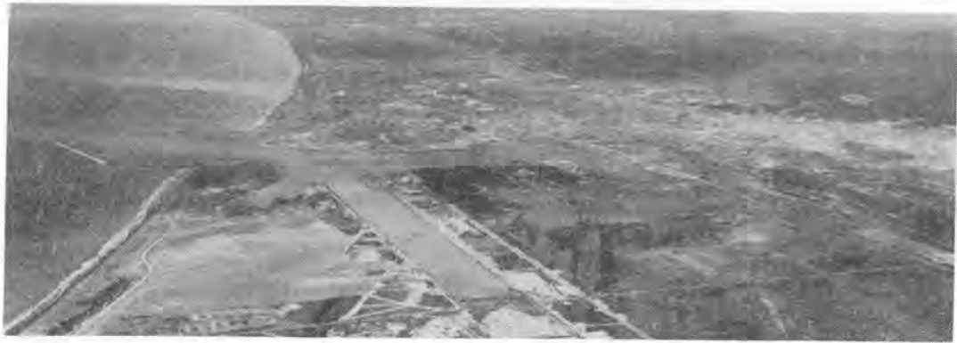
写真-1 苦小牧港の建設工事全景
