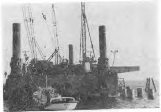
写真-3 プレスティンクドルフィンφ1,500鋼管くい打込み中のデロングバージ
