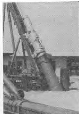
写真-2 工場内 30°斜くい打ちテスト中の MB-70
