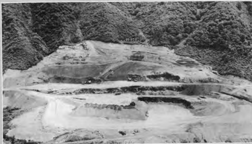
永荒土質材料採取場全景(42.6) 54Bショベル3台、D-8ブルドーザ3~4台が配置された。
