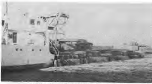
写真-3 水路掘削作業(その2)
