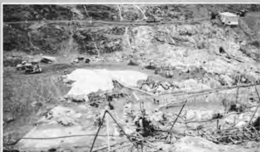
ダム河床ボーリンググラウト工事(41.6)
