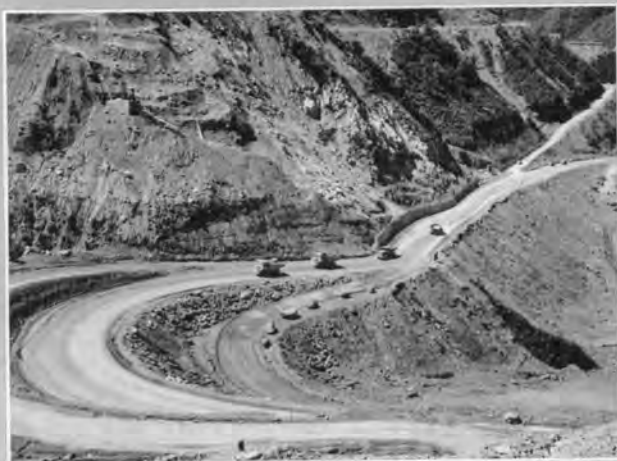
ダム盛立材料運搬道路(42.7)
