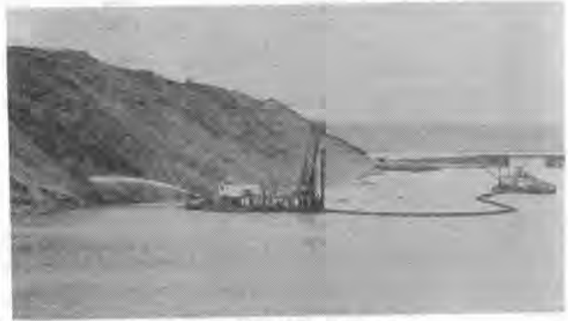
写真-1 放水路掘削工事の全景
