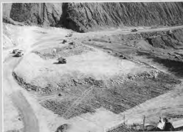
上流側ロックフィル盛立て(41.9)
