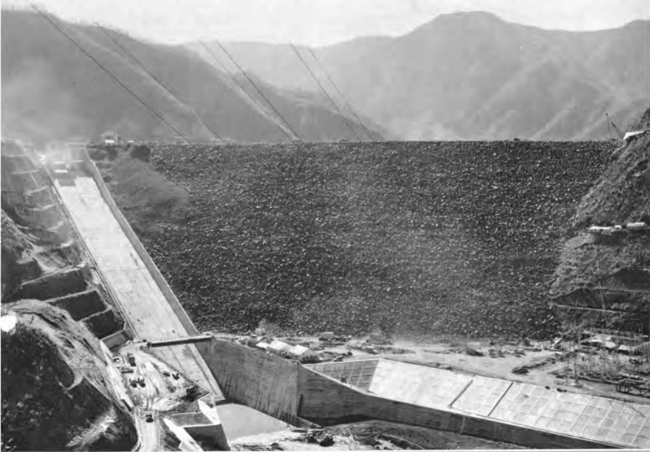
ダム盛立て完了(42.11) 右岸の洪水吐もコンクリート打設を完了している。
