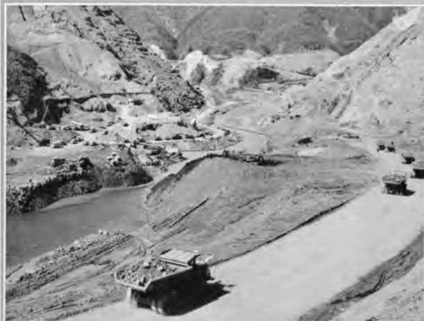
上流第1次仮締切り (41.4)
