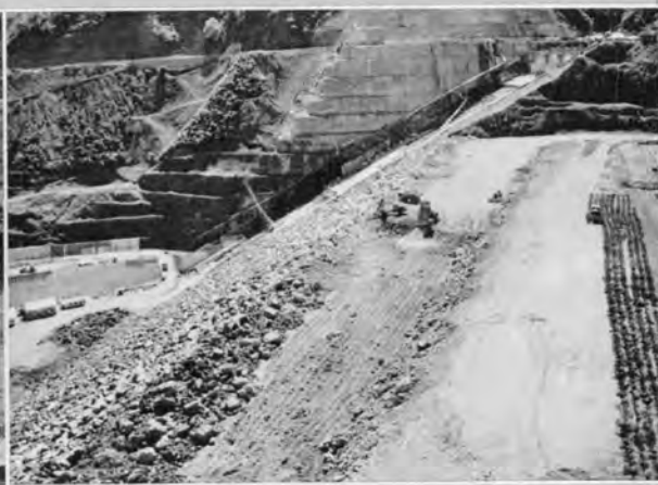
ダム下流側のり面の仕上げ作業状況(42.7)
