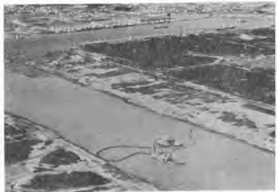
写真-2 水路掘削作業 (その1)
