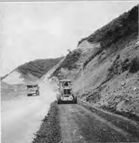
ダム盛立て材料運搬道路のモータグレーダによる維持管理(有効幅員14m以上延長2.5km)
