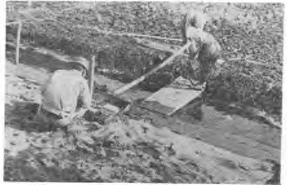
写真-2 横方向傾斜計による測定
