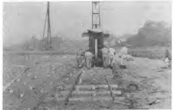
写真-1 ペーパーパドレーン打設 後方に見えるのがサンドパイル打設用モンケン
