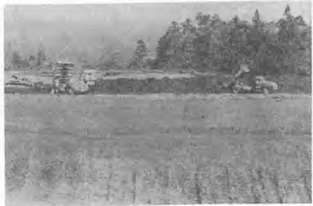
写真-2 D-6 湿地ブルドーザによる2次搬土
