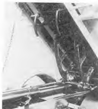
写真-3 (b) カム式ホイスト機構(昭和 7 年当時)
