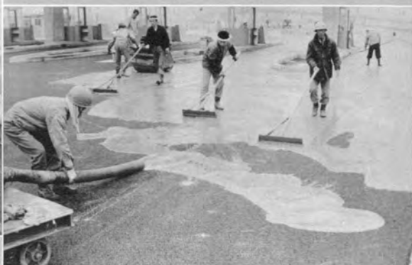
↑調布インタチェンジは高架部分のため、ブース前後のコンクリート舗装の代わりにサルビヤシムを施工した
