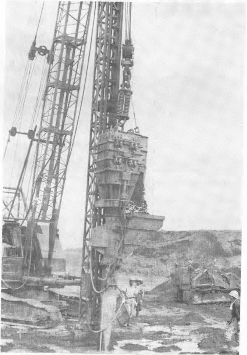
サンドパイル20m施工中
