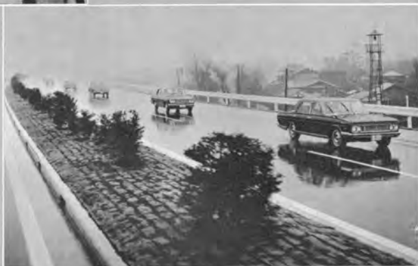
開通パレード風景 ↓ (府中市付近)
