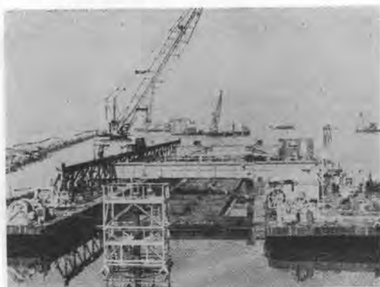
写真-4 双胴バージによるセクションの沈設
