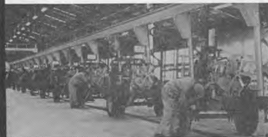
●200米コンベアラインの組立工場
