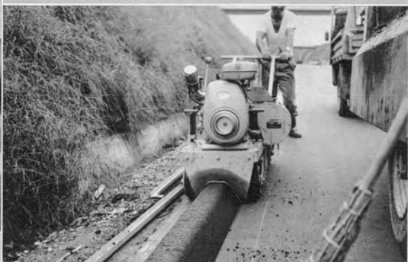
↑路肩に作られるアスファルトコンクリート縁石はアスファルトカーバにより容易にきれいに仕上げられる
