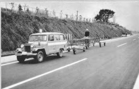
↑舗装の終了した路面は全線プロフィルメータで平坦性を検査する
