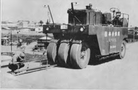
↑ベースコース施工後ベンケルマンビームでた わみ強度を測定する。このときの限界は複輪 荷重8 t、タイヤ接地圧は7 kg/cm 2 で沈下量が 3mm以下でなければならない
