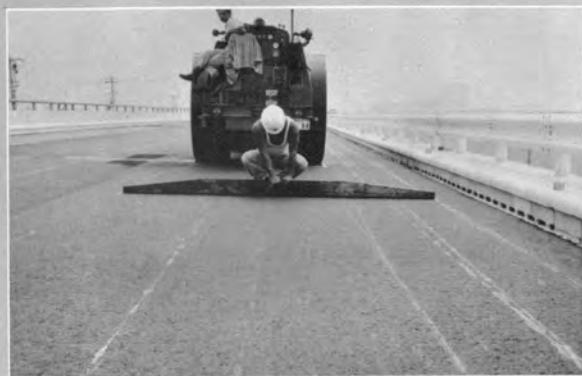
↑舗装の仕上面には3m定規で最凹部3mm以内の平坦性が要求される
