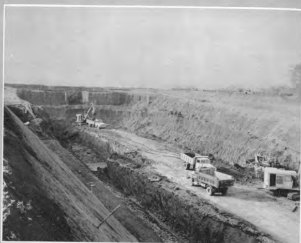
↑石川の切土区間の道路掘削 土質は関東ロームで含水比を下げるためにこ のような掘削方法がなされた
