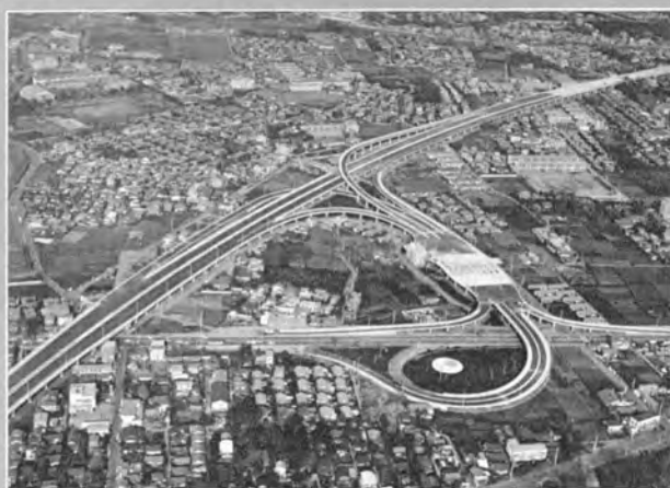
↑ 起点の調布インタチェンジ 全部高架構造よりなり、下の横に走る道路が国道20号。左下が八王子方向
