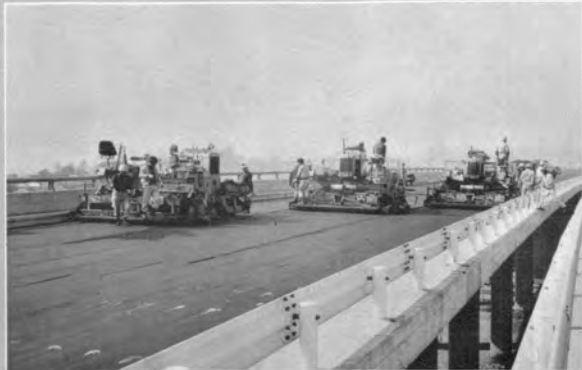
↑工事の最盛期にはフィニッシャを3台並進させた。使用フィニッシャはセグラビッド
