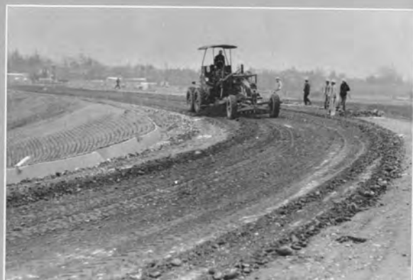
↑国立・府中インタチェンジのランプの路床準備工 舗装工事のために仕上げられた上部路床の一 部をかき起し再転圧を実施する
