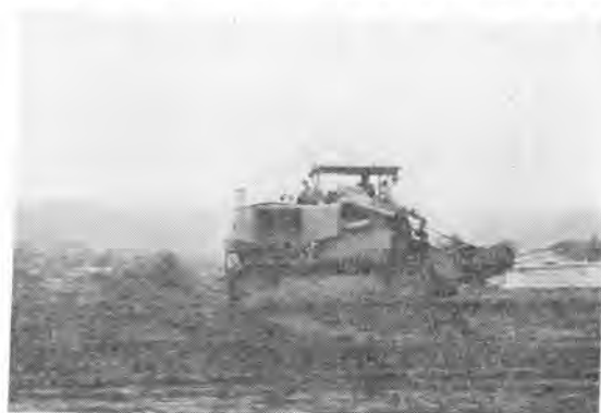
写真-4 6.4m 3 のスクレープドーザ
