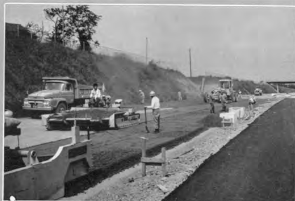
↓サブベース(下層路盤)の上に砕石ベース(上 層路盤)を敷均し中 使用機械はアンマン形304-S アグリゲートス プレッダ
