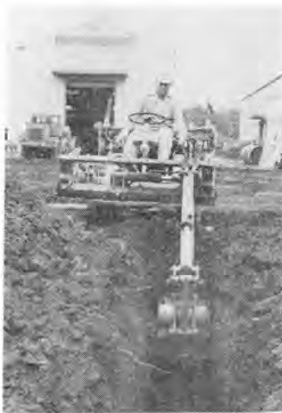
写真-2 みぞ掘り作業
