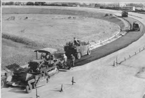
↓国立・府中インタチェンジのランプで砕石ベ ースを敷均し転圧中 使用機械はベースペーバの試作機
