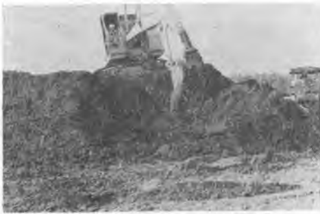
写真-1 ショベルによる第1段掘削
