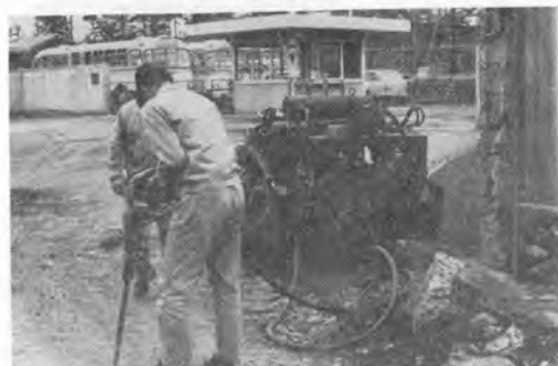
写真-5 エアガン作業
