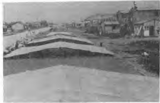
写真-8 養生用屋根
