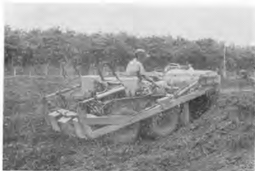
写真-1 掘削、積込み、運搬作業
