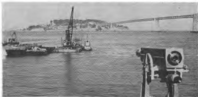
写真-1 レーザと浚渫作業
