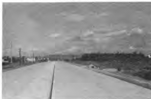
写真-9 竣工した春日井バイパス
