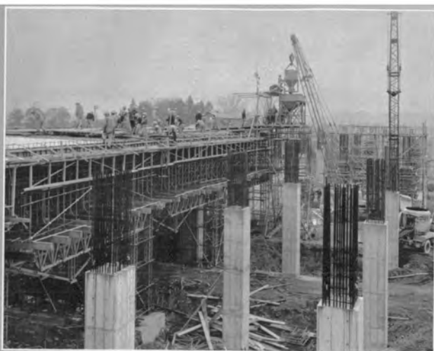
↑万願寺高架の床版コンクリート打設作業 高架橋の片側の幅員11.90m
