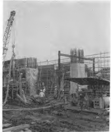
写真-12 日立 S 200 形リバース機サーキュレーションドリル
