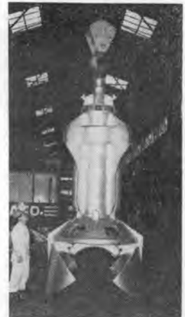
写真-4 50 TH 用口径 2.0 m 用グラブバケット
