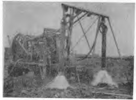
写真-7 オランダ I.F.C. 社の水ジェットさく孔サンドドレーン打込機複ペール形
