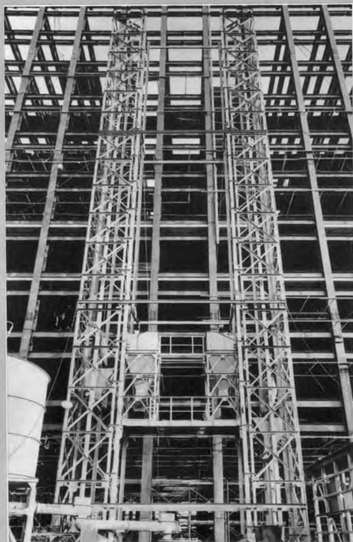
↑高速コンクリートエレベータと新考案のスライドステージ ( 0.6\text{m}^2 , 60\text{m}/\text{min} )
