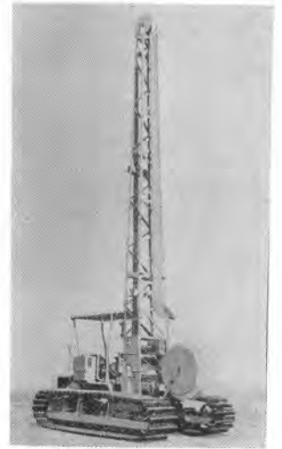
写真-5 New Jec 式ペーパードレインマシン (8m 用)
