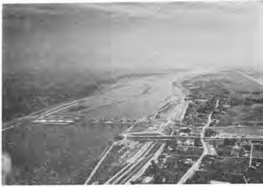
写真-2 利根河口堰建設状況
