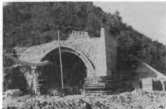
写真-3 山陽新幹線帆坂トンネル
