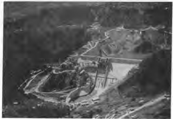
写真-1 完成間近い下久保ダム
