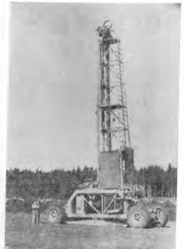
写真-2 スウェーデン国立土質研究所で考案された深さ20mまで打てるペーパードレーン打込機
