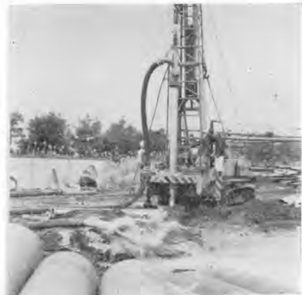
写真-13 カトウ 20HR-RAE 形アースドリル
