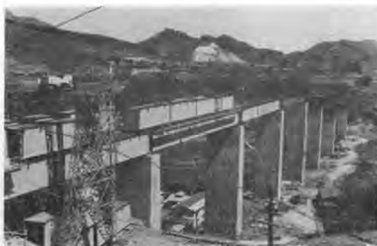
写真—2 中央本線相模湖～甲府間新桂川橋りょう
