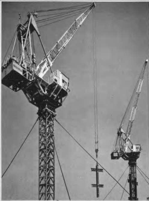
↑鉄骨建方用タワークレーン（KTK-200W形） （35m/min, 192t・m）
