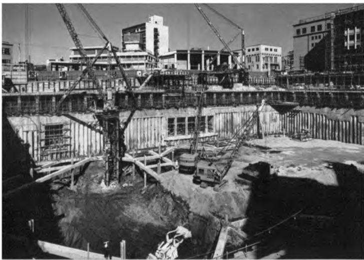
←自立擁壁併用切梁工法により 効率化をはかった機械化掘削
