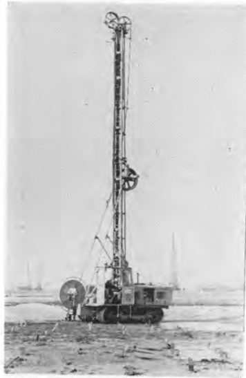
写真-4 加藤ペーパードレインマシン TD-12A による作業状況
