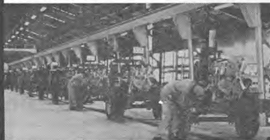
●200米コンベアラインの組立工場
