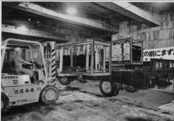
↑フォークリフトによる カーテンウォール資材の荷役作業
