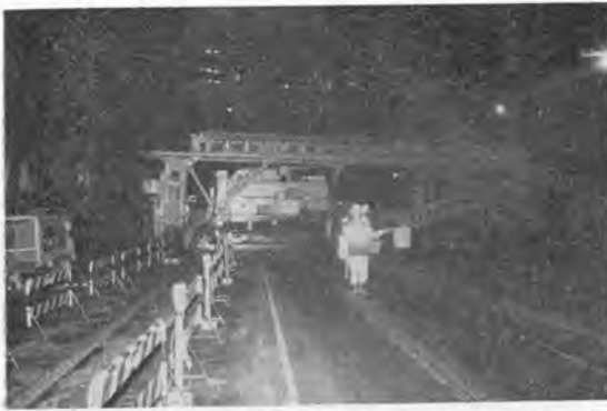
オーガの移動はこの姿勢で行なう（トロリーの高さ 5.05m）
