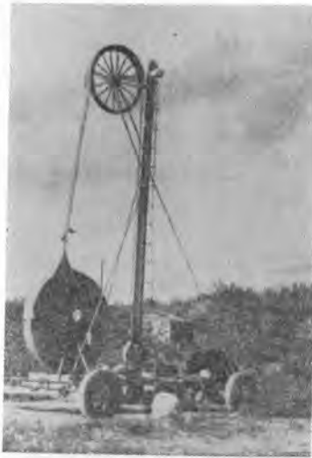
写真-1 スウェーデンで最初に作られたペーパードレーン打込機
