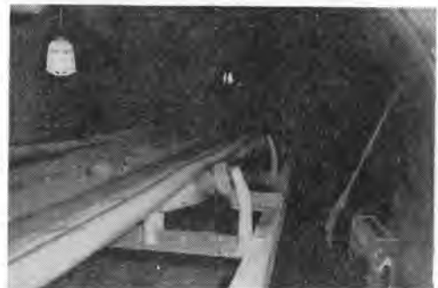
写真-1 横坑坑口から推進管内部コンベヤ設備を見る
