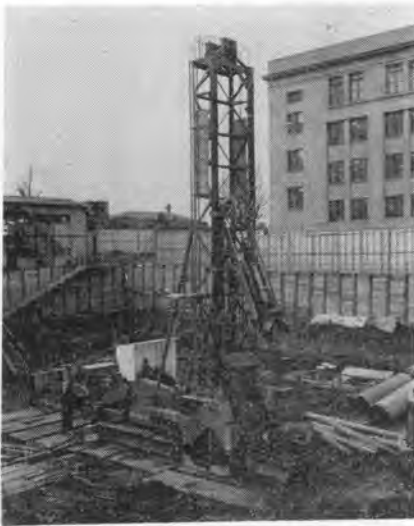
写真-2 三菱ベントボーリングマシン MT-1 形
