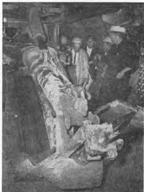
写真-1 バックホウ式シールド掘進機
