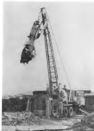
写真-1 三菱ベントボーリングマシン BT-2S 形
