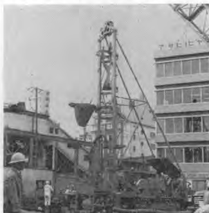
写真-16 リバース工法施工中の 50 TH 形アースドリル
