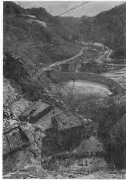
写真-5 青蓮寺ダムの建設状況
