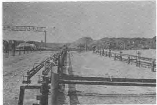
写真-13 電気浸透固結法施工 (その2)
