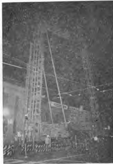
写真-2 オーガのタワー起し作業
