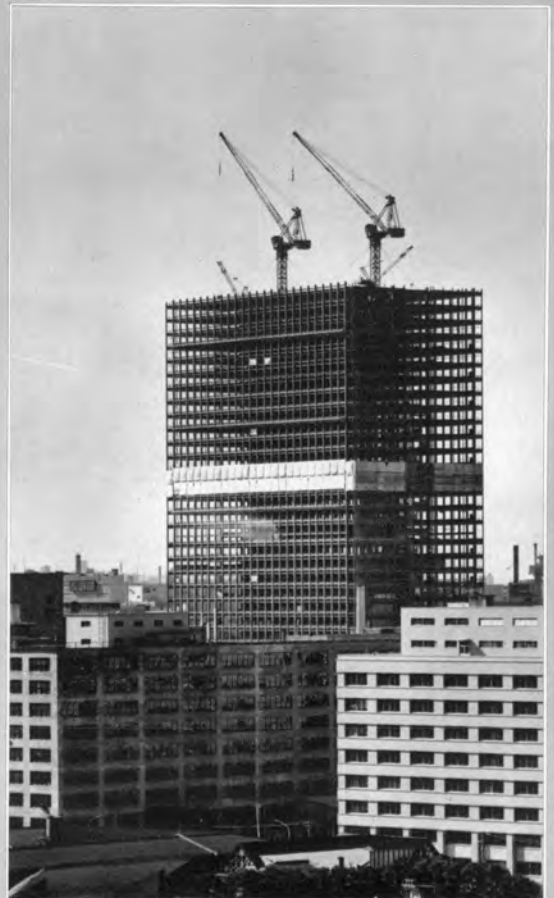
↑鉄骨建方32階130mに達する タワークレーン下部にジブクレーン（E60 K形）が見られる（40m/min, 60t・m）。
