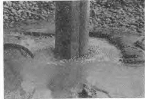
写真-9 バイプロフロッツ貫入終了骨材投入開始に移る前の状況
