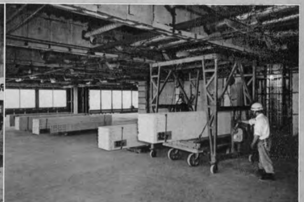
↑特殊荷降し機による 台車からの荷降し作業
