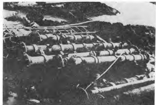
写真-3 パイプロッドに取付けたカッター
