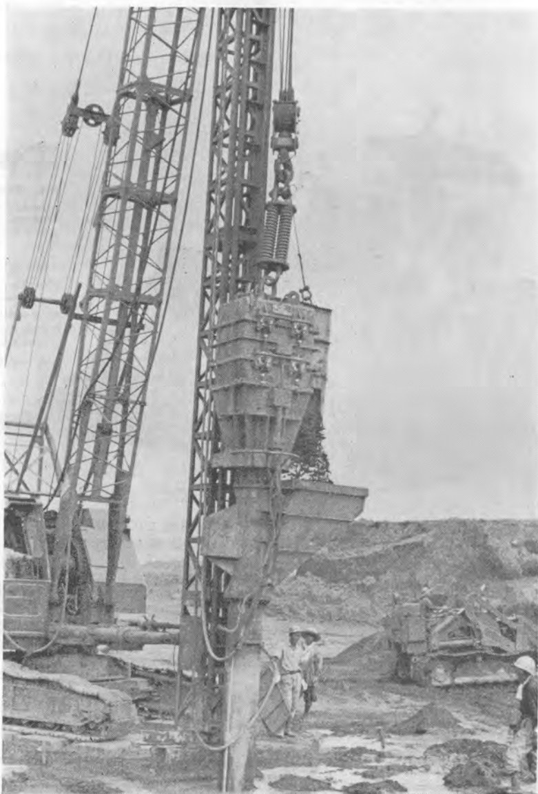
サンドパイル20m施工中
