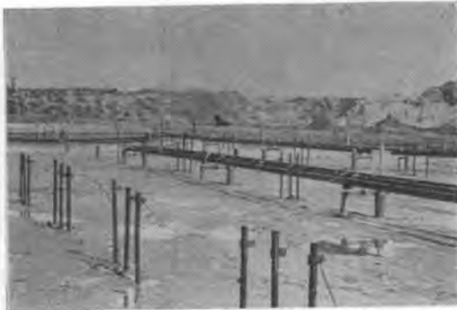
写真-12 電気浸透固結法施工 (その1)
