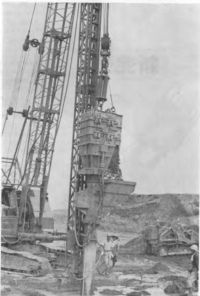
サンドパイル20m施工中
