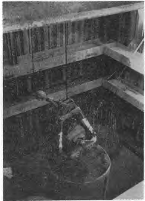
写真-3 でき上がったケーソンぐいの頭部 特殊バケットにより砂を取出す
