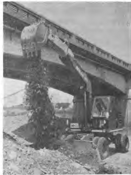
写真-2 NIKKO-O & K MH 3 形全油圧式パワーショベル
