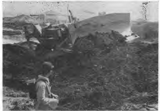
写真-1 テスト中のラジオコントロールブルドーザ
