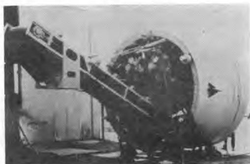
写真-4 カルウェルド社シールドに使用されてい る星形油圧モータ
