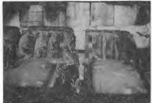
写真-1 ハンブルグ地下鉄シールドのフェースジャッキ
