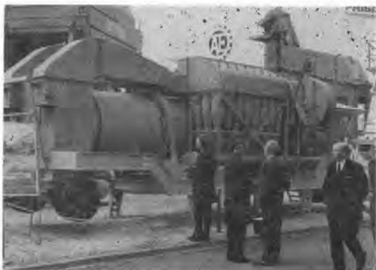
写真-3 コンクリート練り機
