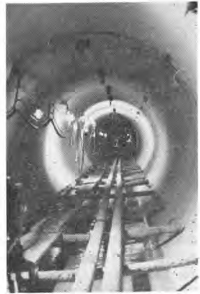
写真-5 ヒューム管押込み完成
