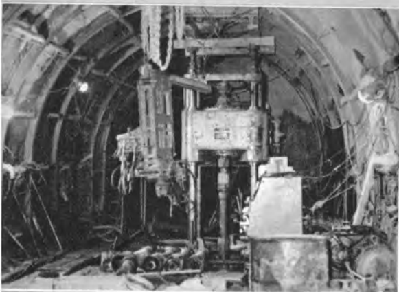
鉦研試錐工業機(株)のレーズボーラ
