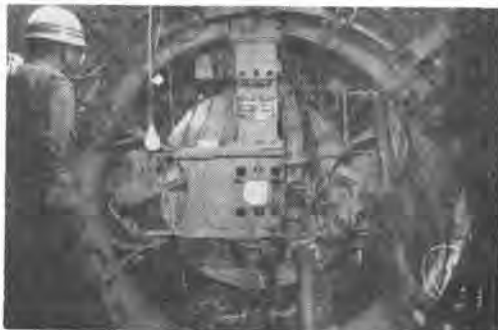
写真-1 循環式シールド背面
