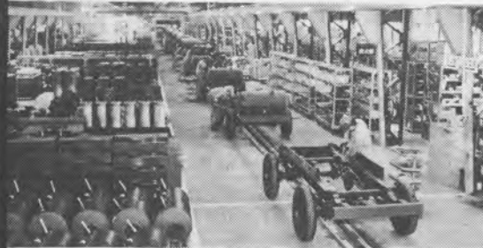
●200米コンベアラインの組立工場
