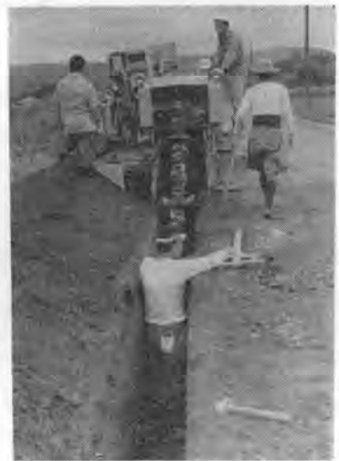
写真-3 郊外における直埋ケーブル埋設溝の掘削(デービス)
