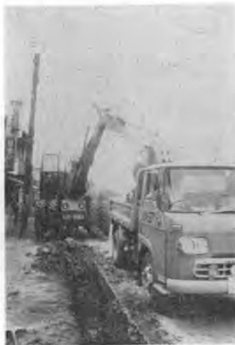
写真-2 市街地における掘削
