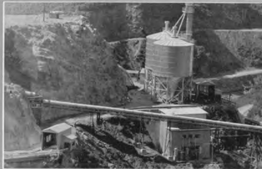
↑完成したセメントサイロ(40年8月, 1,500t×2基, 手前左25tトラックスケール, 右側は60t/hrセメント空気輸送設備)
