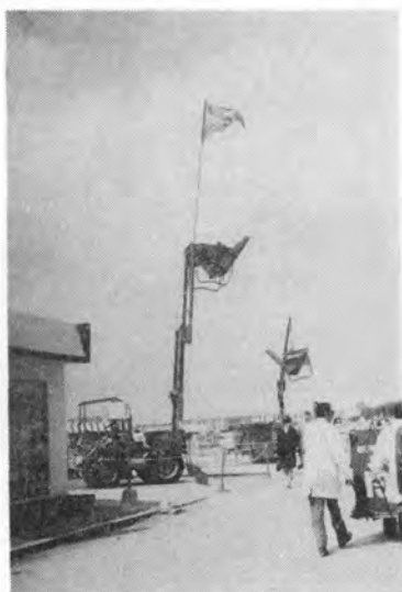
写真-16 リフトと運搬バケットの結合 (パリ・エキスポマート)
