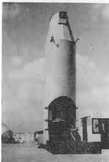
写真-24 ミキシングプラント (パリ・エキスポマート)
