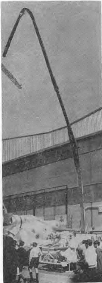
写真-5 コンクリートポンプ車 (ミラノ見本市)
