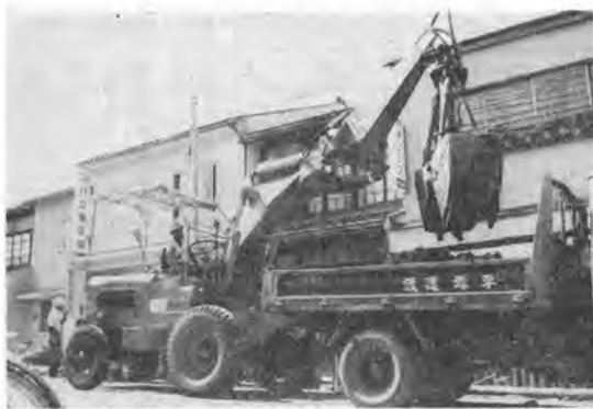
写真-4 土質が軟弱な場合の掘削
