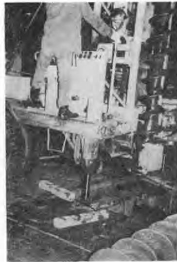
写真-8 アースオーガによるくいの建込み
