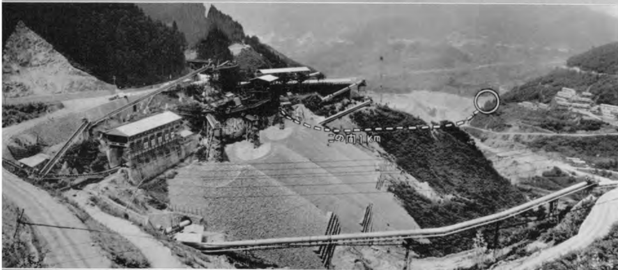
↑稼働中の骨材二次プラント(41年11月, 濁水(骨材洗浄水)は約1kmの水管橋で左岸のシックナープラント, 沈砂池で処理した。
