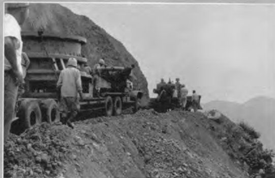
↑42-65ジャイレトリクラッシャ下部胴体約30tの現地運搬風景(40年6月)
