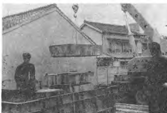
写真-6 組立てマンホール
