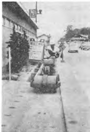
写真-7 インパクトローラによる埋設溝の締固め
