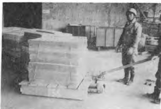
写真-3 ハンドリフトとその作業状況
