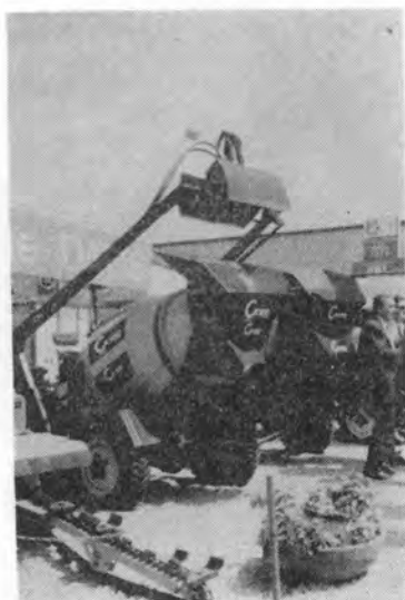
写真-15 セルフローディングの小形トラックミキサ (ミラノ見本市)
