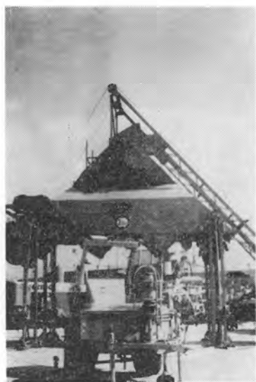
写真-25 ミキシングプラント (パリ・エキスポマート)
