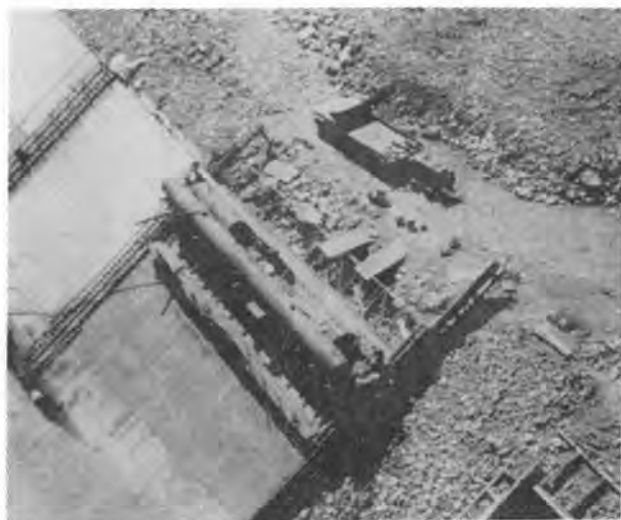
写真-3 自動型わくの作業状態
