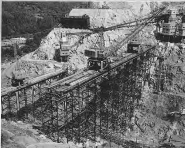
↑本体掘削および工事用機械設備の据付け始まる (40年4月)
