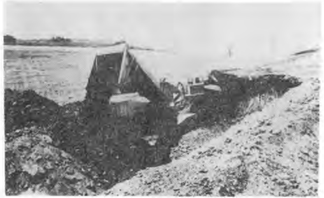
写真-2 掘削中の日車-MX 700
