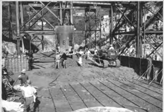
↑コンクリートの打込み(トレススルの下側はブルドーザで敷きならす)
