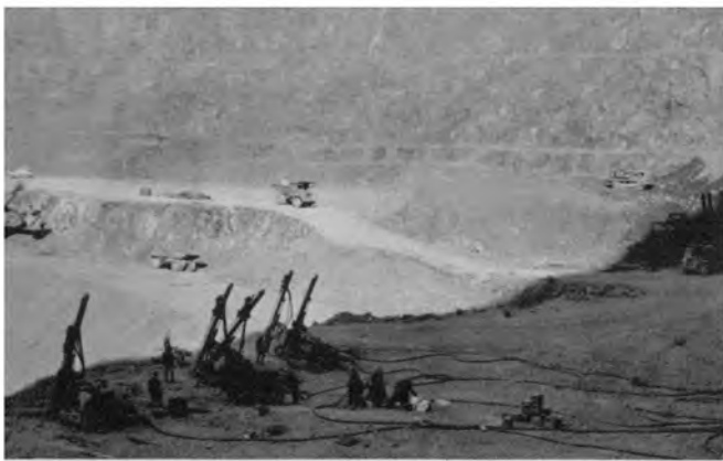
↑最盛期の原石採取状況(2m 3 級電気ショベル4台, 13.5tダンブトラック15台, 他にワゴンドリル, ブルドーザ, 採取量約340万t)
