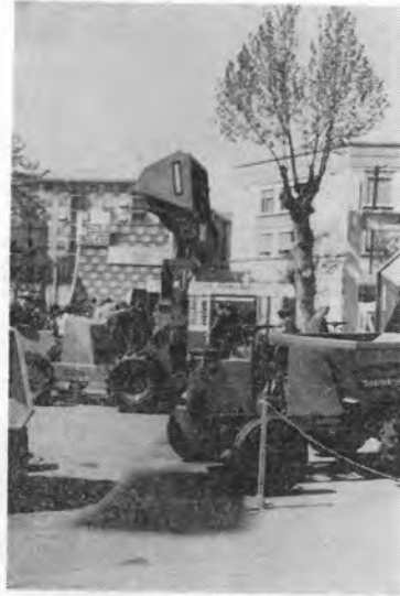
写真-11 リフトを取入れた動力猫車(ミラノ見本市)
