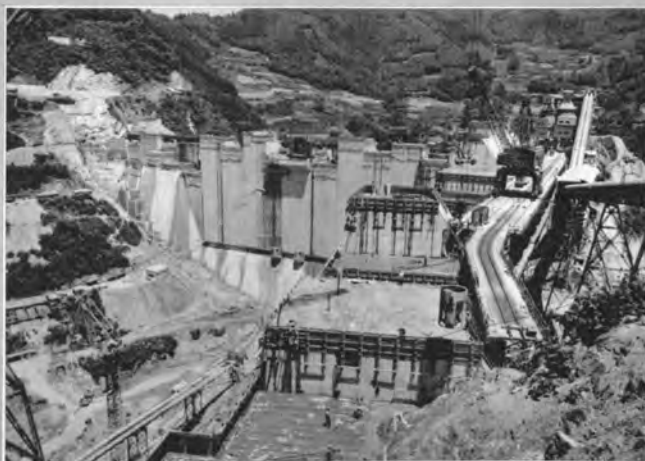
↑移設完了後のトレススル、ジブクレーン、コンクリートプラント（41年8月）
