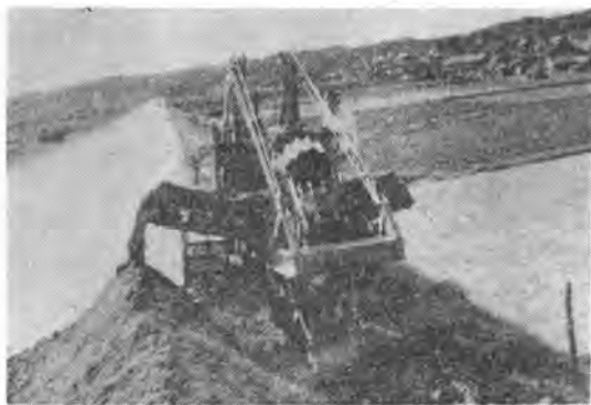
写真-5 トレンチャによる掘削
