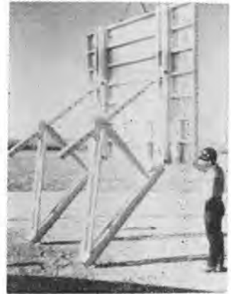
写真-2 多目的型わくの支柱 45°の位置
