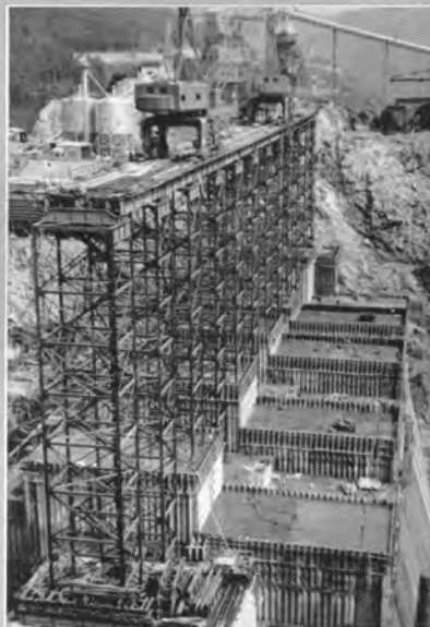
↑移設完了後のトレススル、ジブクレーン、コンクリートプラント（41年8月）
