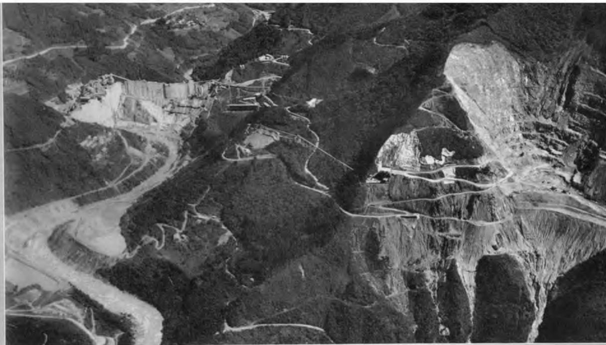
↑下久保ダム全景（42年7月） 右側：原石山（ダム上流約1.5km） 左下端：右岸沈砂池
