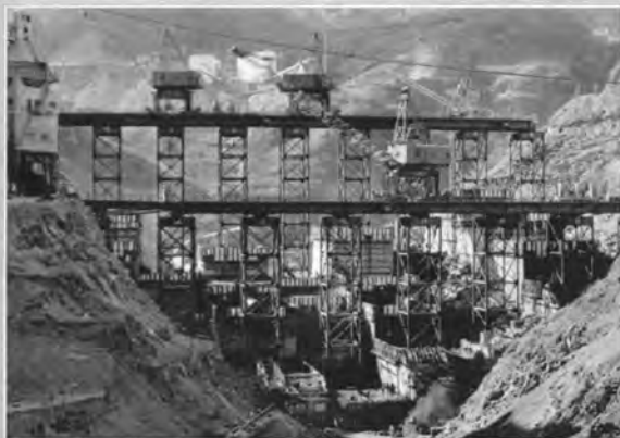
↑コンクリート打設本格化する（41年1月、約10万 m^3 、下流側より望む）
