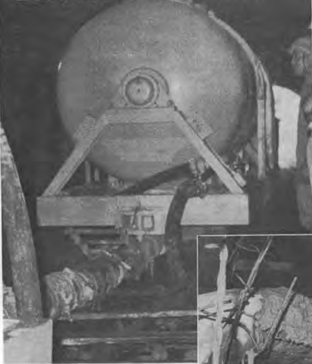
信越本線複線化工事に於て本機による連続吐出状況。
