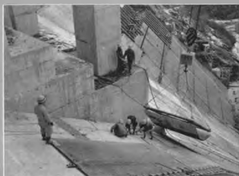
↑遮水壁アスファルトマット敷設工事（厚さ50mm）
