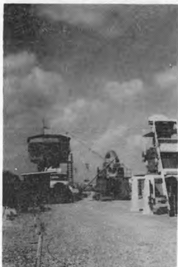
写真-23 ミキシングプラント (パリ・エキスポマート)
