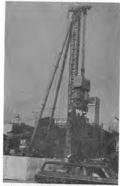
写真-2 ハンマフレームを利用して作業中のサイレントマスタ SM-S
