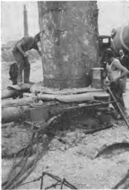
写真-3 Wien 高速道路基礎工事 (Inzerdorf 付近)
