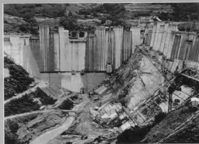
↑右下遮水壁工事も急ピッチで進む（42年7月）
