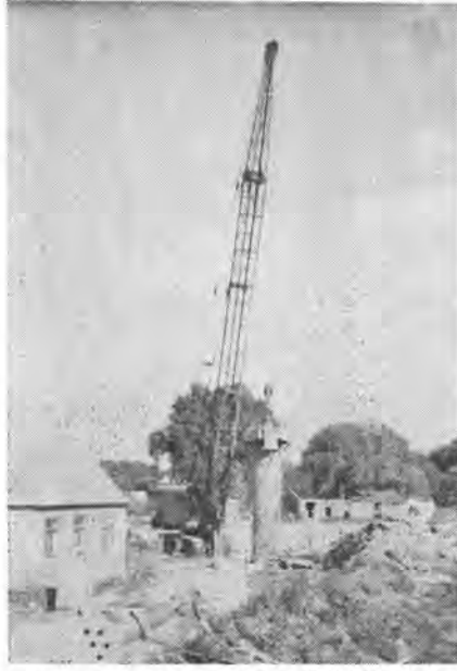
写真-4 Wien 第4 Donau 橋高水敷の基礎
