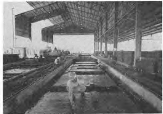
写真-9 製造ライン上の作業(仕上げ)
