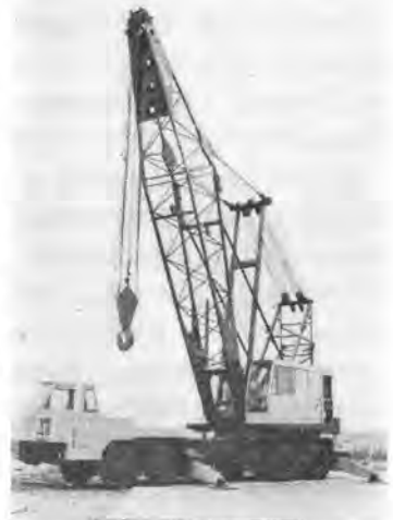
写真-2 70tづり大形トラッククレーン MC-775 形
