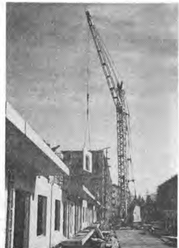
写真-19 コンクリート版建方専用クレーン
