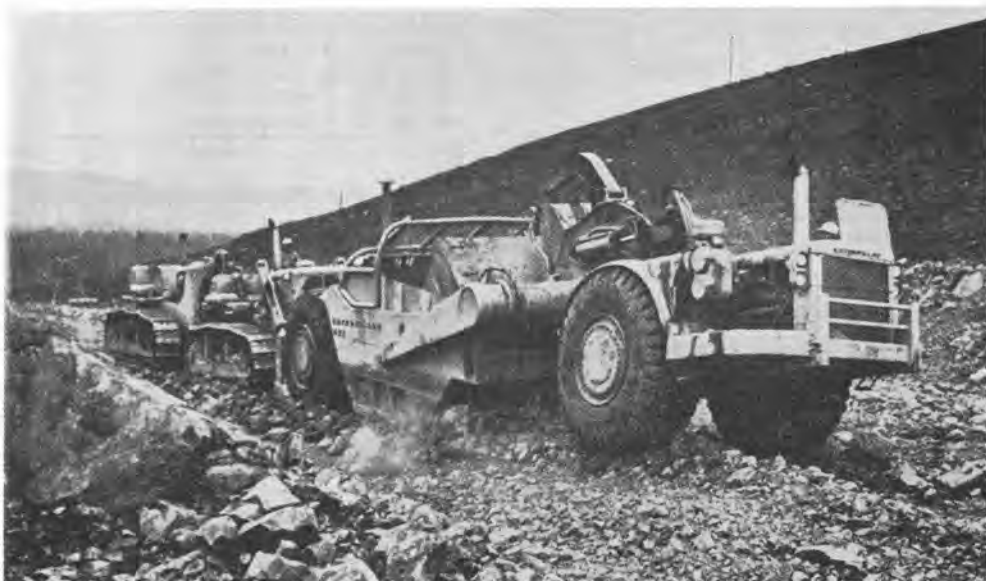
Cat 657 タンデムスクレーパの積込み
