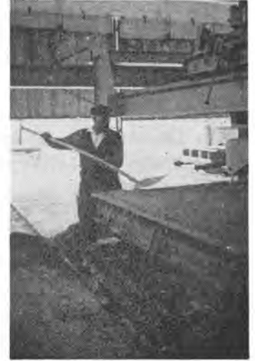
写真—15 移動ベッド方式でのコンクリート打設機（外国例）
