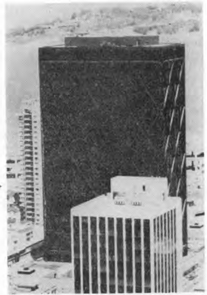
アルコアビル (1967年) → サンフランシスコ 設計: スキッドモア, オウイングス & メリル 面積 54,774 m 2 , 25階, 高さ 100 m, 基準階 1,756 m 2 (29 m × 59 m), エレベータ 13 台 (150~240 m/min)
