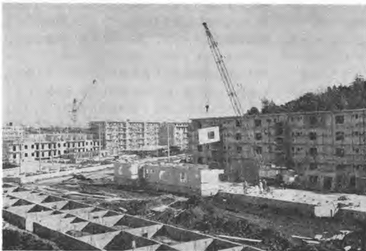
写真-18 プレハブ建築現場のトラッククレーン
