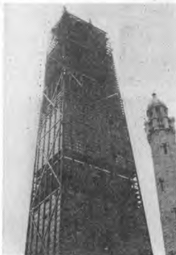
↑ 工事中のジョン・ハンコックビル (1969年完成予定) シカゴ 面積 260,130 m 2 , 100階, 高さ 337 m
