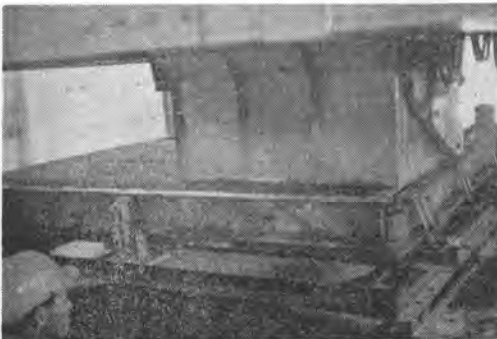
写真—16 移動ベッド方式でのコンクリート打設機（外国例）
