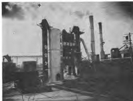
写真-1 日工アスファルトプラント NAP-1200 AZVW
