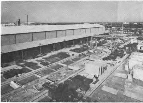
写真-6 製造ライン上の門形クレーン(屋外)
