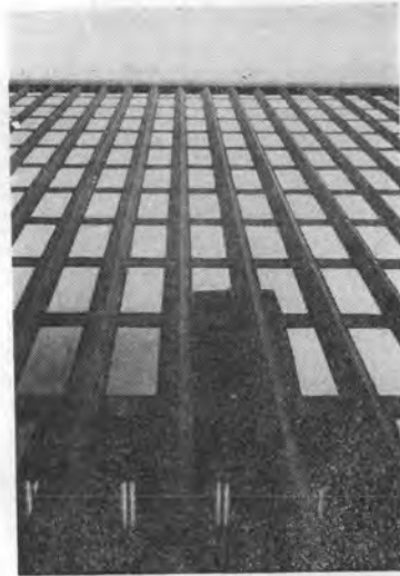
← IBM (1965年) モントリオール 設計: I.M. ペイ プレキャストコンクリートのベアリング ウォール, 窓アルミ
