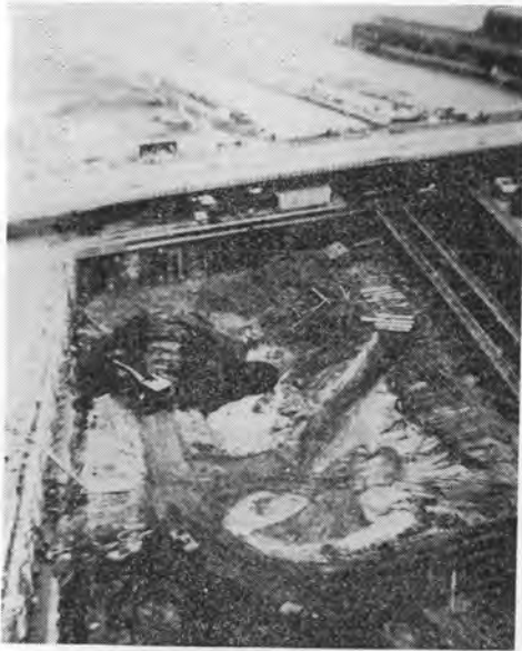
← 工事中のニューヨーク WTC ビル 設計：ミノル・ヤマサキ、 エメリー・ロス 110階 掘った土を高速道路の向 こう側のイースト河の埋 立に使っている。
