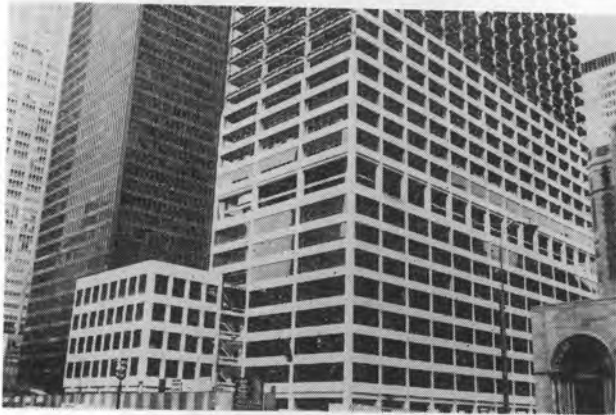
↑ 工事中の 345 パーク・アベニュービル 設計：エメリー・ロス 44階
