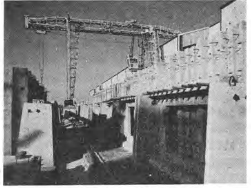
写真—12 ストックヤードされた版とクレーン
