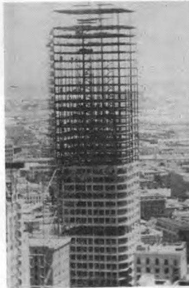
アルコアビル (1967年) → サンフランシスコ 設計: スキッドモア, オウイングス & メリル 面積 54,774 m 2 , 25階, 高さ 100 m, 基準階 1,756 m 2 (29 m × 59 m), エレベータ 13 台 (150~240 m/min)
