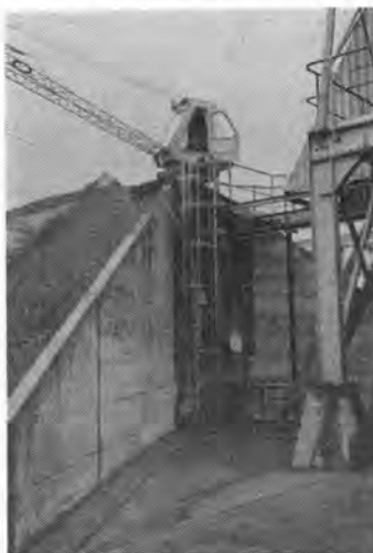
写真-2 コンクリートプラント (外国の例)
