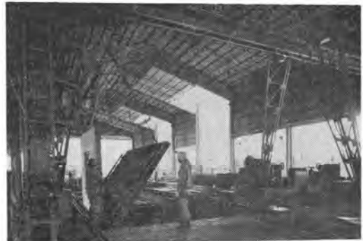
写真-10 製造ライン上の作業(脱型, つり上げ)
