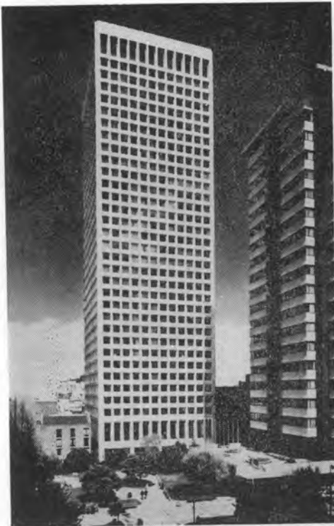
↑ ハートフォードビル (1967年) サンフランシスコ 設計: スキッドモア, オウイングス & メリル 面積 51,000 m 2 , 34階, 高さ 151 m, 基準階 1,453.5 m 2 (38 m × 38 m), エレベータ 13 台 (300 m/min)
