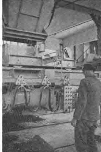
写真—14 移動ベッド方式でのコンクリート打設機（外国例）
