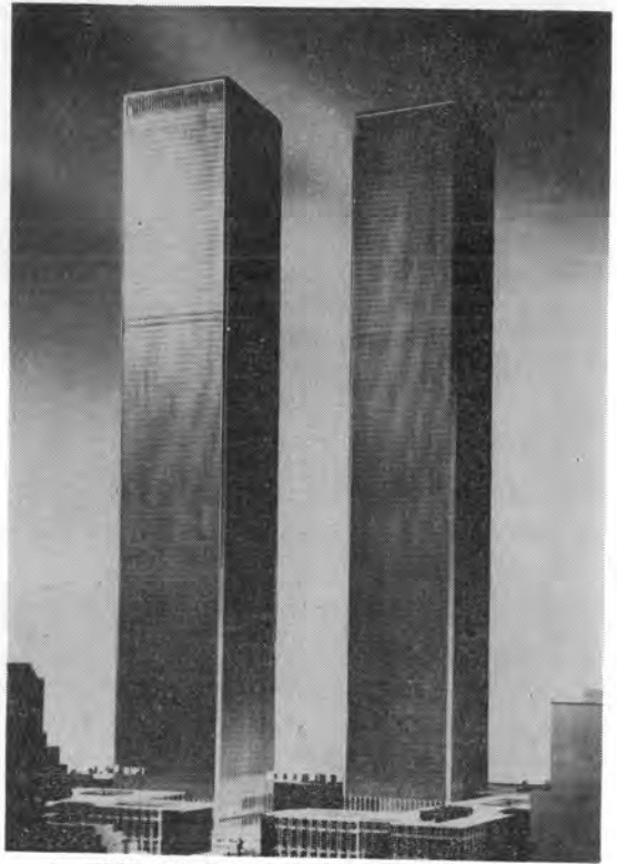
↑ WTC ビル (ニューヨーク) 設計: ミノル・ヤマサキ, エメリー・ロス & サンズ 地上 110 階 3'-3" 間隔の外周柱によるベアリングウォール方式の採用 で, 鋼材使用量も建設費も軽減された。
