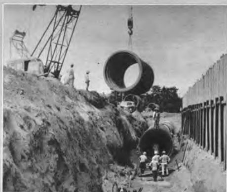
↑工事中の高松サイホン
