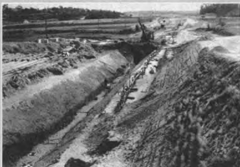
↑開水路の掘削
