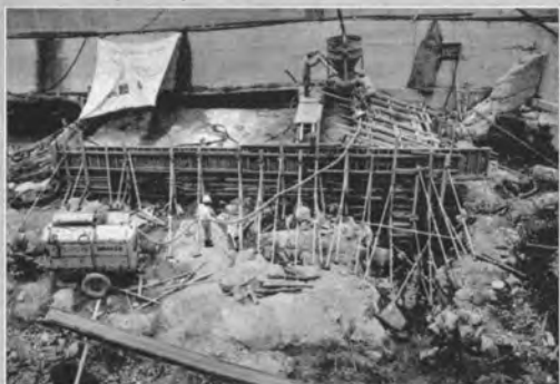
↑取水庭の真空処理（大入頭首工）
