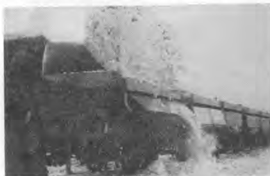
写真-4 搬出除雪を行なっている空気袋式貨車雪卸し装置
