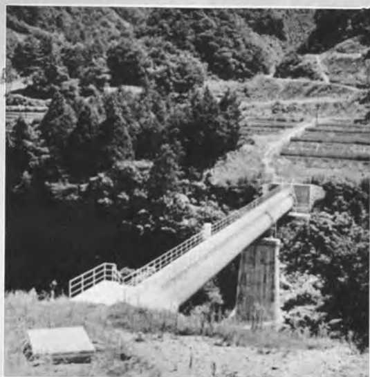
↑豊川サイホン鋼管橋（西部幹線水路）
