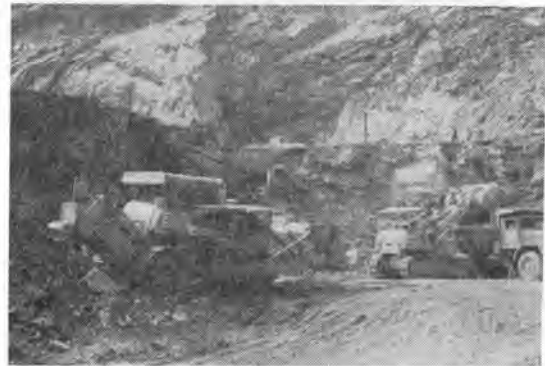
写真-2 切羽ベンチカット
