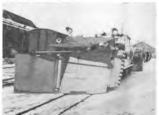
写真-1 前後に排雪翼を備えた DD 15 形複線ラッセル除雪車
