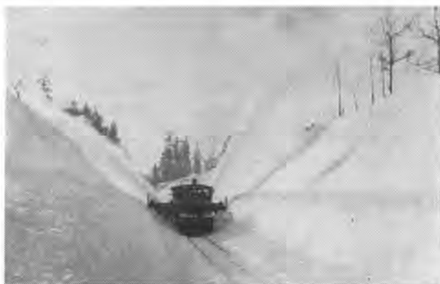
写真-3 切取区間の拡幅除雪を行なっている 拡幅形モータカーロータリ除雪車
