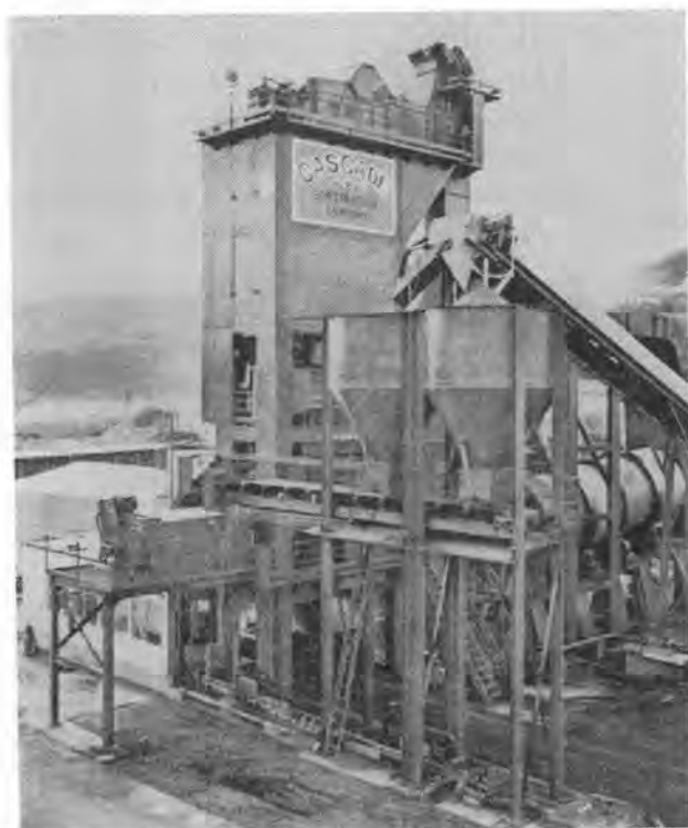
写真-1 Barber-Greene BE-150T Batchpac アスファルトプラント
