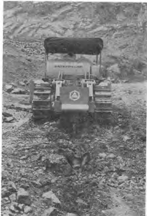
写真-1 リッパ工法
