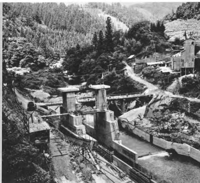
↑完成間近大入頭首工
