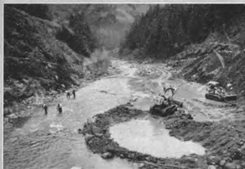
↑基礎掘削（大入頭首工）
