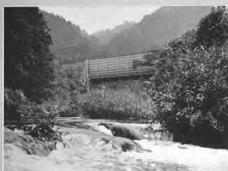
↑大野導水路黄柳水路橋
