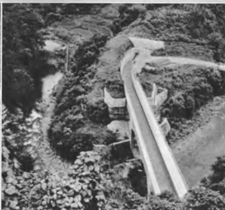
↑ 佐久間導水路千尋沢水路橋
