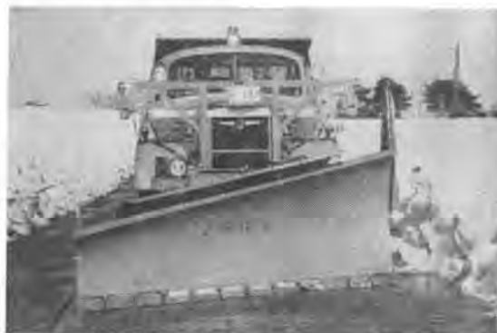
写真-7 バイトルプラウ(圧着式)(日本除雪機製作所)
