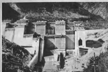
↑建設中の宇連ダム
