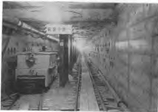
写真-2 ずり搬出(東京における実施例)
