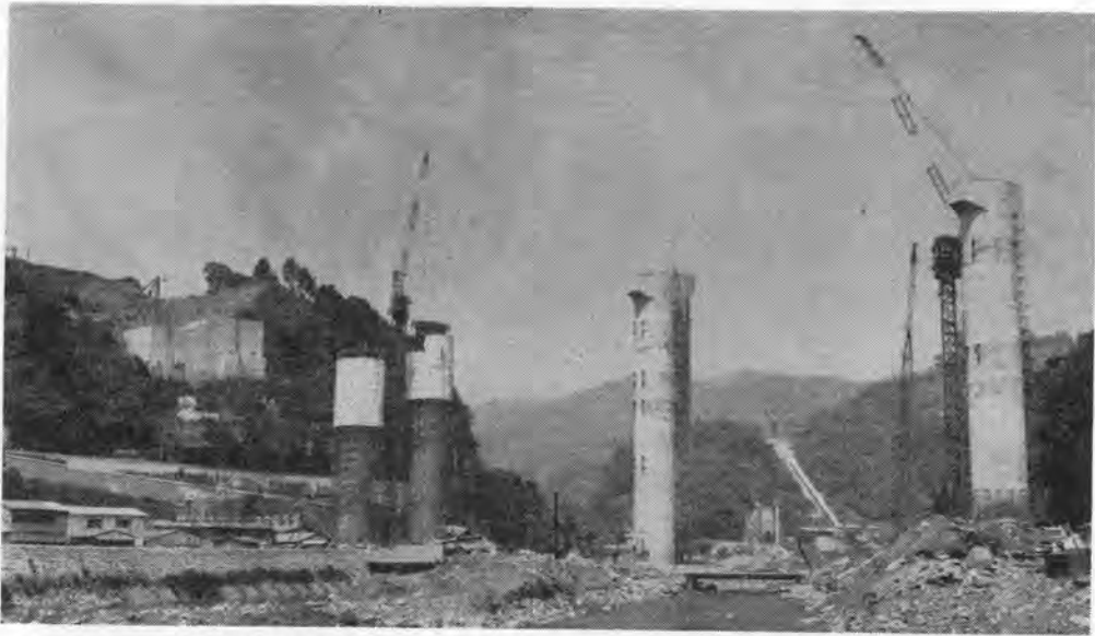
写真-5 クライミングタワークレーンによる 65~58 m 橋脚の施工
