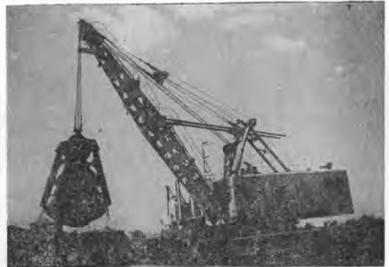
写真-9 グラブ浚渫船“第3関門号”
