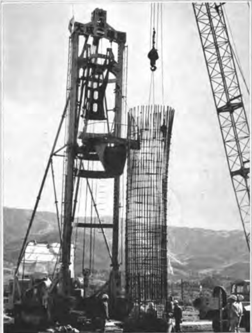
↑ ベントによる橋りょう基礎の現場打鉄筋コンクリートぐいの打設（御殿場工区）
