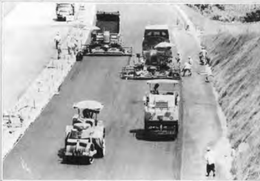
↑ アスファルトフィニッシャーによる基層工およびマカダムローラとタイヤローラによる転圧 (浜松工区)
