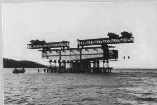
↑ 橋げた架設用トラスに装備された35t巻上機（浜名湖）
