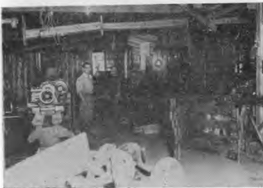
写真-2 修理工場内部（第3期工事、昭和25年）
