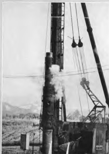
↑ディーゼルパイルハンマによる 鋼管ぐいの打設(豊田磐田工区)
