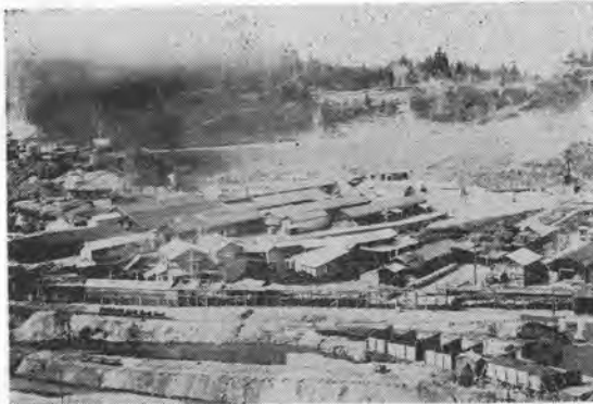
写真-1 坑外設備全景（第1期工事、昭和10年）
