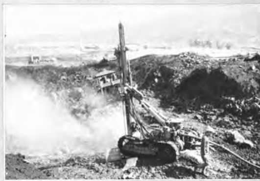
↑ クローラドリルによる硬岩発破準備（御殿場工区）
