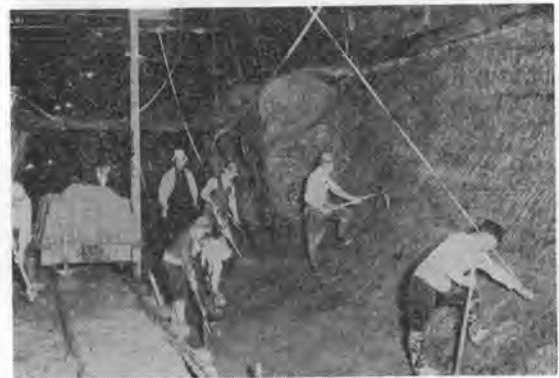
写真-4 土平掘削（第1期工事、昭和9年）
