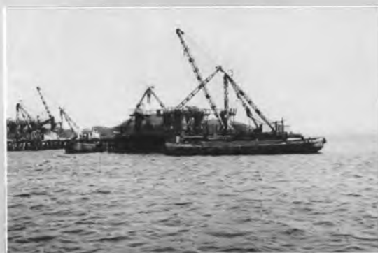
↑ 潜函工法による橋りょう基礎工事（浜名湖）
