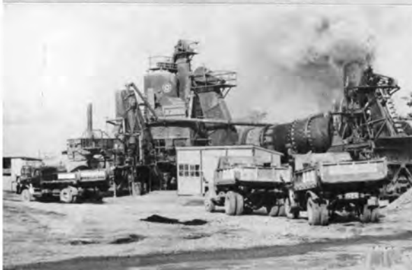
↓ アスファルトプラント全景 (浜松工区)
