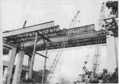
↑トラッククレーンによる鋼けたの架設（荒久橋りょう）
