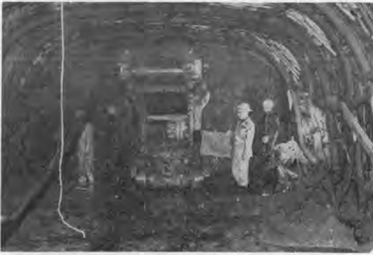
写真-11 導坑掘削 (第4期工事, 昭和43年)
