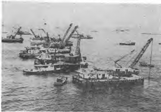
写真-11 神戸港で稼働中のグラブ船団
