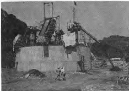
写真-2 沈下掘削中の P 2 ケーソン
