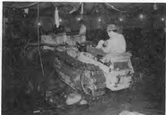
写真-3 ケーソン函内で活躍する電気ブルドーザ TSE-2
