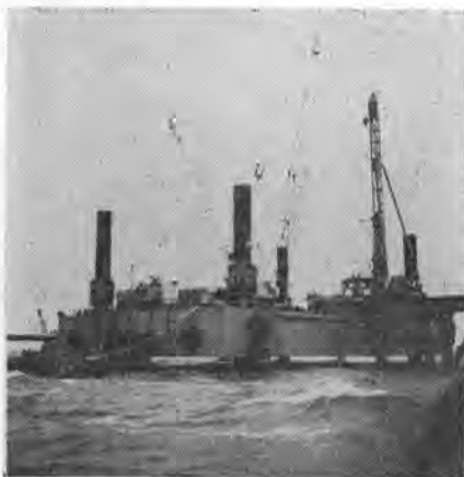
写真-23 海上作業台船デロングバージ
