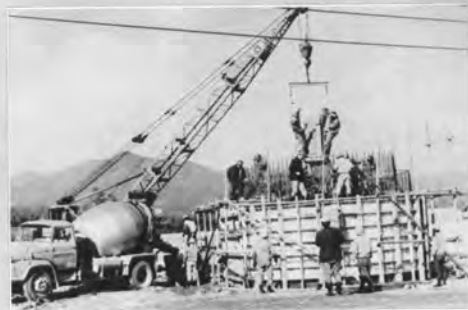
↑ 橋りょう基礎のウェル製作（豊川工区）
