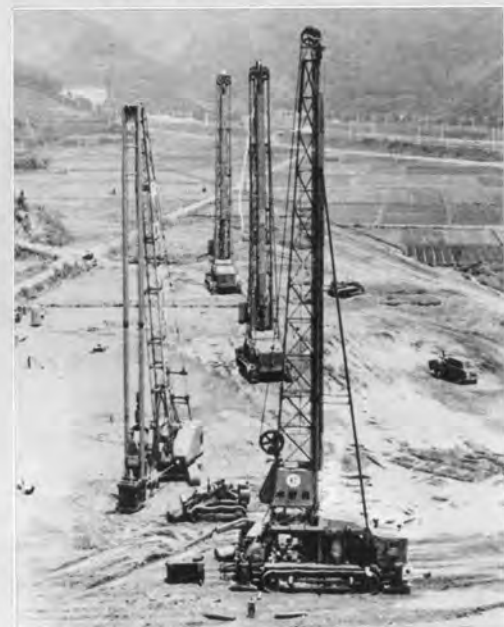
↑パーカッション方式によるサンドパイルの打込みおよびベーパードレーン工法（焼津工区）
