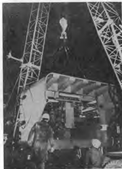
写真-1 シールド機搬入 (名古屋における実施例)
