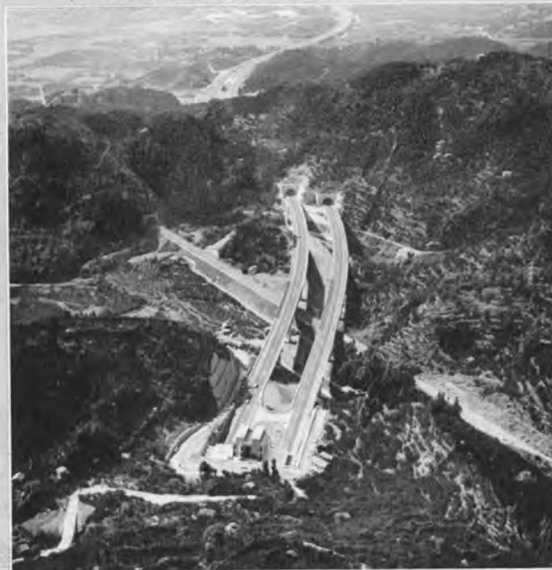
↑清見寺、袖師両トンネル（手前は換気施設）
