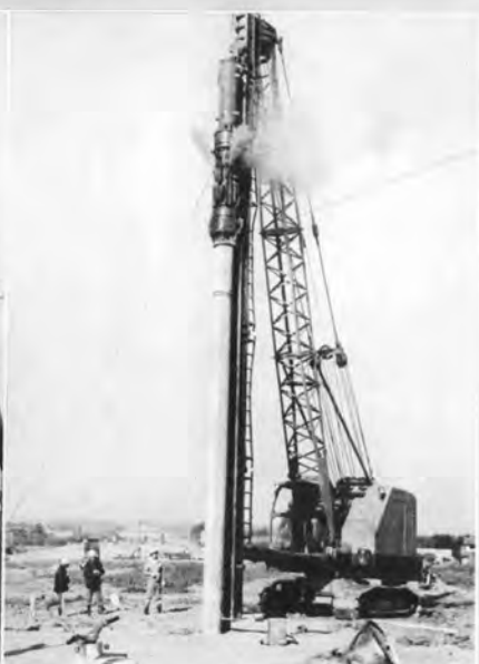
↑ディーゼルパイルハンマによる RCぐいの打設(名古屋工区)
