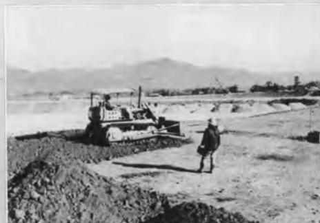
↑ ブルドーザによる敷均し（豊川工区）
