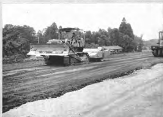
↑ けん引式バイブレーションローラによる転圧（御殿場工区）
