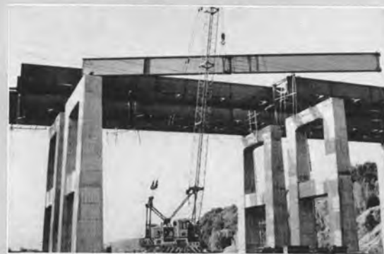
↑トラッククレーンによる PCけた(工場製作)の 架設(小牧工区)
