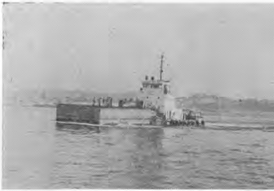
写真-17 ケーソン押航中の“あぶくま丸”
