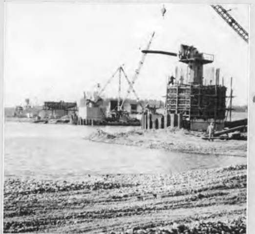
↑ 潜函工法による橋りょう基礎工事 (天竜川)
