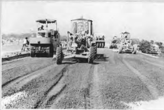
↑ モータグレーダによる路盤の敷均しとタイヤローラによる転圧 (浜松工区)
