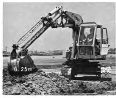
側溝掘に Y-35S
