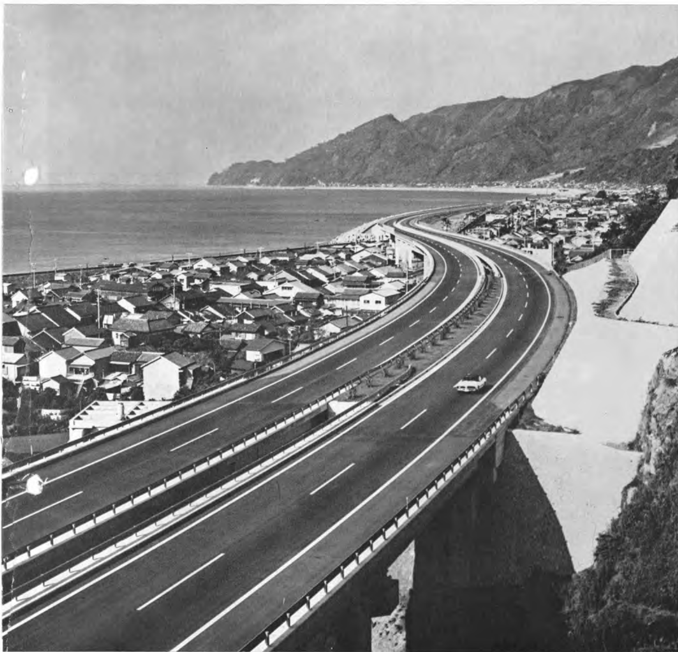
東名高速道路静岡県由比海岸付近
