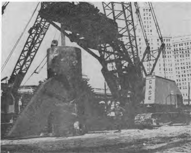
← 特殊バケットと Manitowoc 3900 クレーンにセットされた Hughes CLLDH-150 ロータリテーブル
