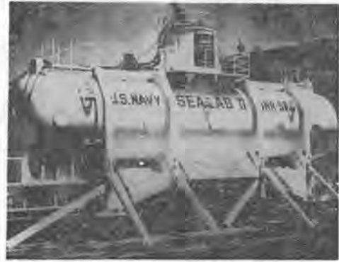
シーラブII (直径 3.66 m, 長さ 17 m) 1965年8月～9月の間に45日間の実験が行なわれた。10人1組で3組のチームが62mの海底でそれぞれ15日間滞在
