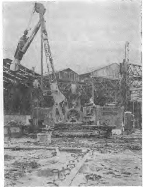
写真-1 20 THC 形アースドリル オールケーシング工法作業
