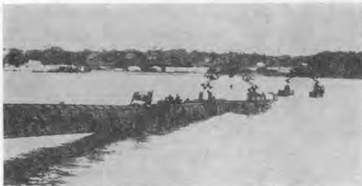
西アフリカ象牙海岸のアビジャンの温度差発電所の海水取入れ用パイプライン
