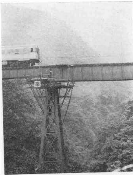
写真-1 作業前の4号橋脚
