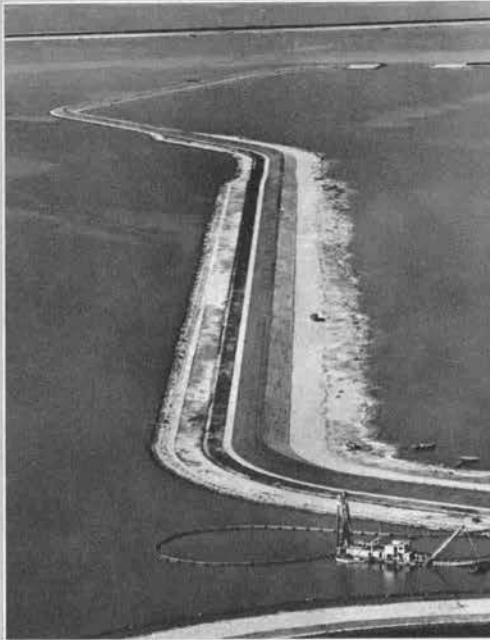
↑ 周辺干拓堤防（竣工38年10月）
