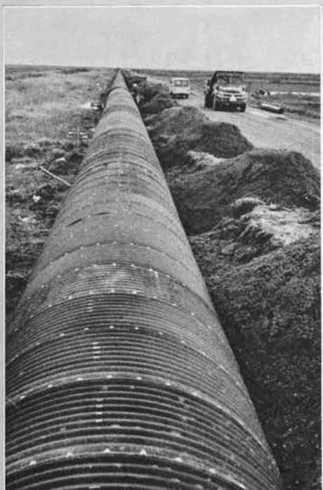
↑コルゲートパイプによる用水路
