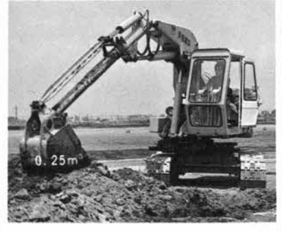
側溝掘に Y-35S
