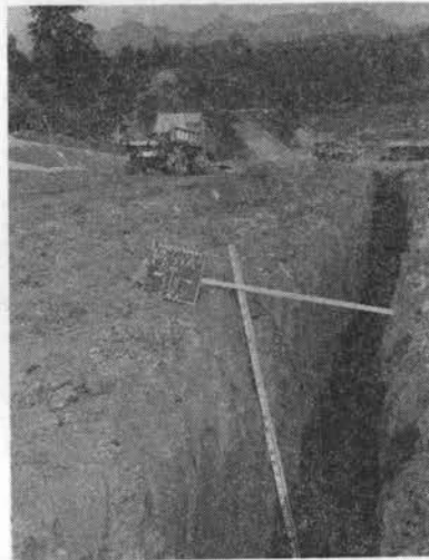
写真-6 スクレードドーザ SR-264 による掘削状況
