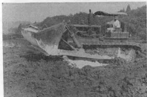
写真-11 バケットドーザによる2次搬土
