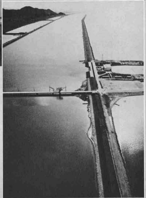
↑ 北部排水機場 （竣工38年8月、橋りょうは新生大橋）
