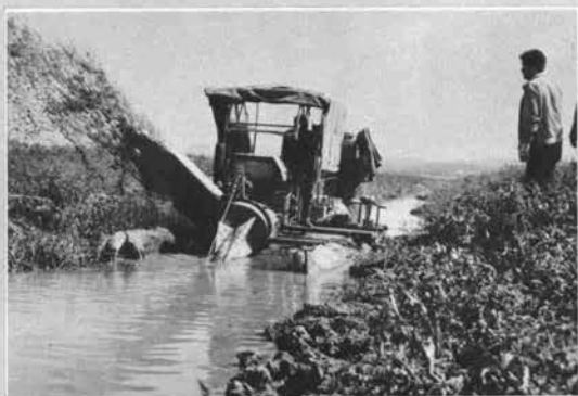
↑ヨークデッチャによる支線排水路の 掘削状況
