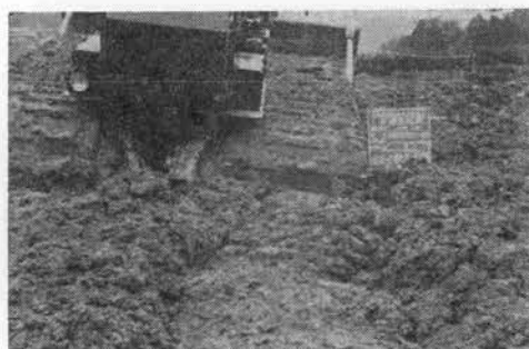
写真-1 灰土の盛土面にめり込んだ超湿地ブル
