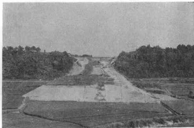
写真-2 試験盛土全景
