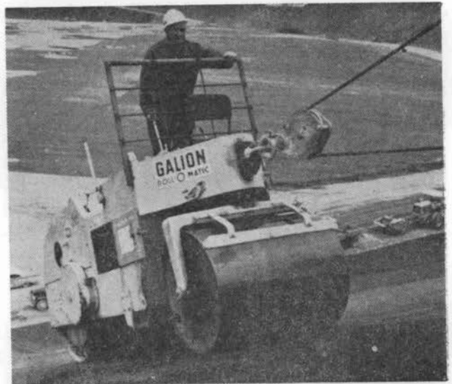
転圧中の10tタンデムローラ
