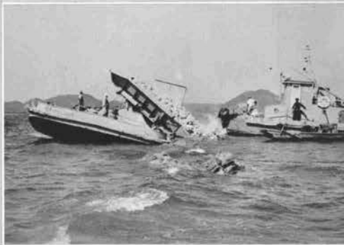
↑ 45m 3 積ダンプ船による堤防のり尻基礎捨石
