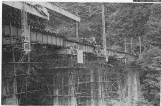
写真-3 5連目けた据付完了(山形側より)
