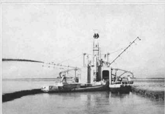
↑干陸後の小形ポンプ船による 支線排水路荒掘り状況
