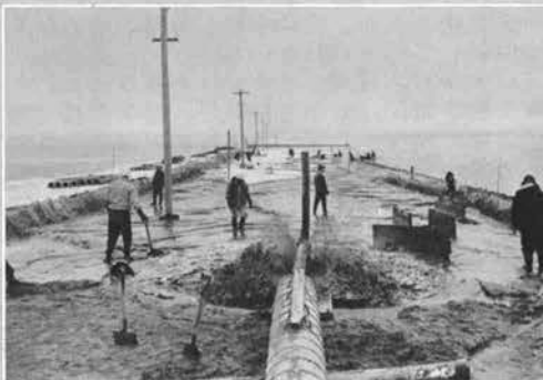
↑ 浚渫船による堤防盛土状況
