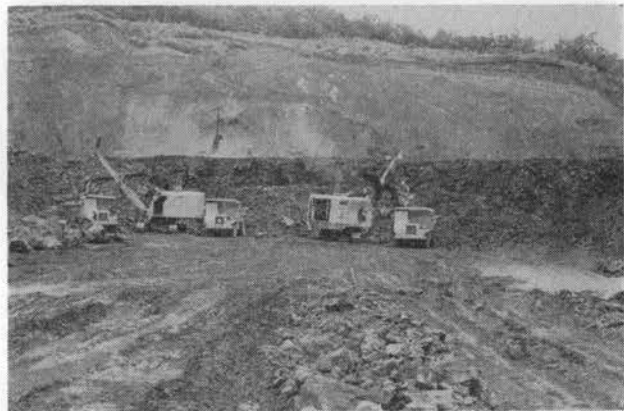
写真-2 粘土掘削積込み(Rブロック)
