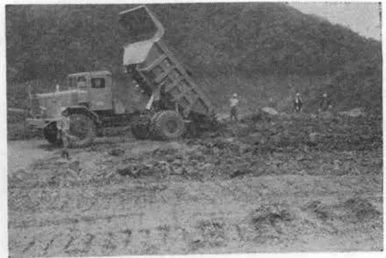
写真-4 15t ダンプによる運搬
