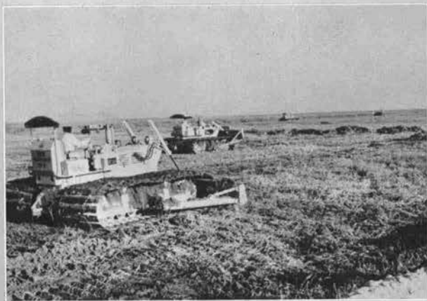
↑超湿地ブルドーザによる整地作業
