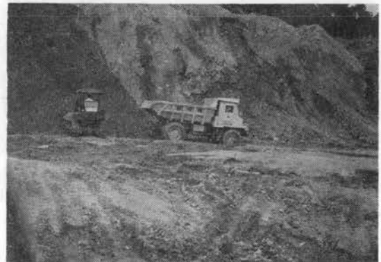
写真-3 Lブロックの積込み
