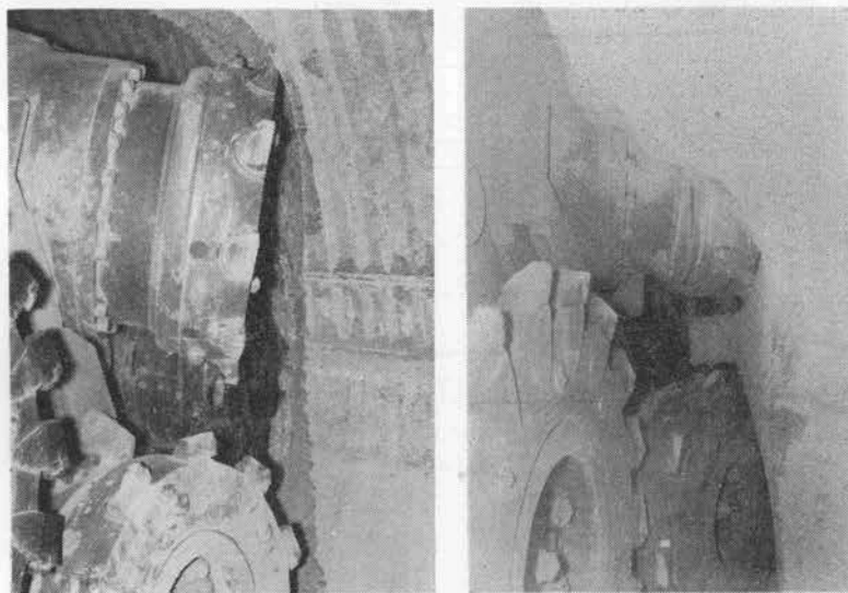
写真-1 曲進区間のサイドカッティング
