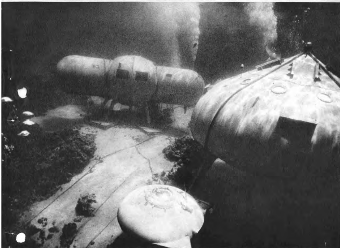
↑ フランスのJ.Y. クストーのプレコンチナン(大陸棚開発計画)によって紅海の深さ10mの海底で行なわれたプレコンチナンIIの海底の家(左)と潜水円盤(手前)および潜水円盤のガレージ(右)
