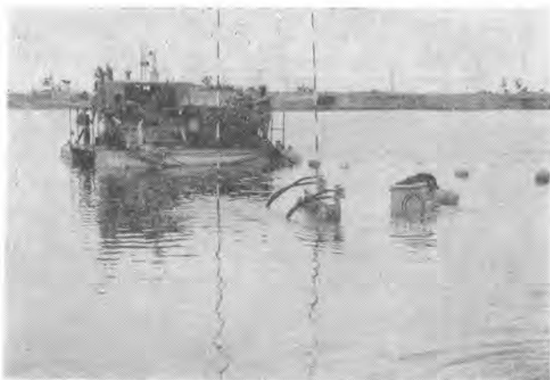
写真二 浮上しているパワーユニットと潜水している水中ブルドーザ
