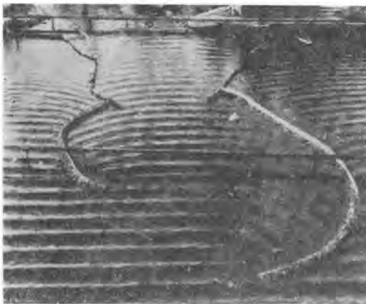
写真-1 Ijmuiden 港改良工事の計画に先立って行なわれた模型実験の状況
