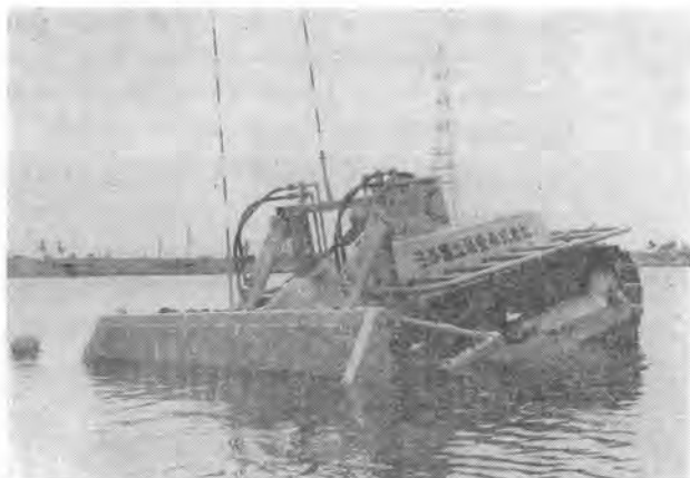
写真一 鹿島港での公開試験における試作1号機
