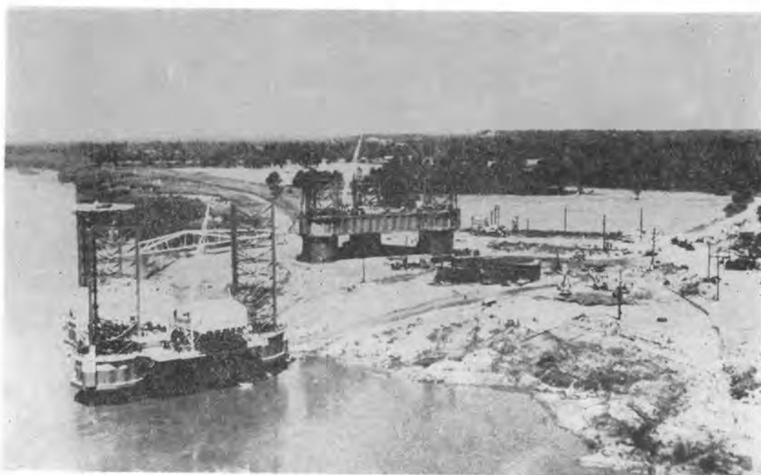
写真-4 アメリカにおけるルトーノー形の建造場所（左下の1基はすでに進水を完了している）
