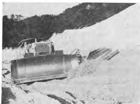
写真-1 サイドスローパを装着してのり切り作業をするCAT D8Hブルドーザ
