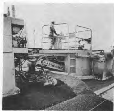
写真-3 トリミングした路盤材料の除去
