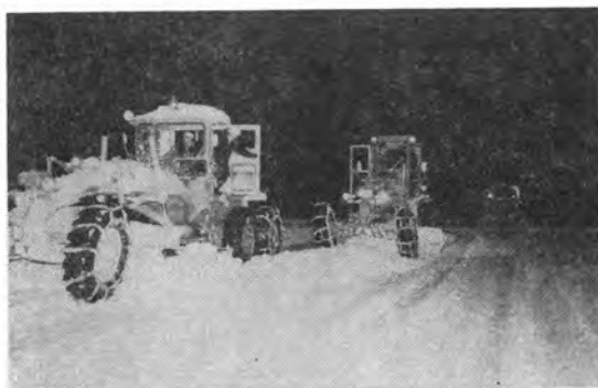
国道7号線酒田工事事務所管 内における夜間除雪グレーダ 2台、除雪トラックと並列で 風上から風下に新雪を流す全 幅除雪作業
