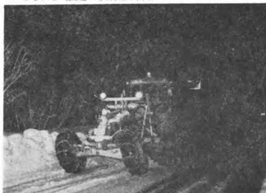
良好な路面維持には夜も作業が続けられる (国道17号線小千谷付近)
