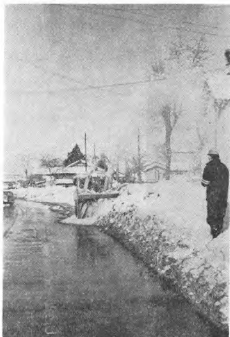
中形ロータリ除雪車による拡幅作業 (国道8号線長岡市郊外)
