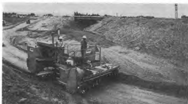
写真-1 RAHCO Model 512 によるランプ路盤のトリミング
