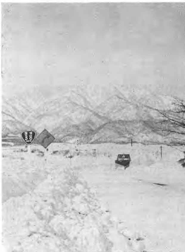
国道 38 号線滝川～帯広間における 10t ダンプ V プラウによる除雪作業
