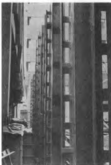
写真-1 くい建込み
