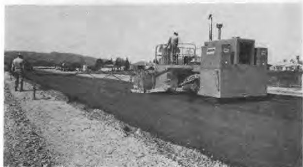
写真-2 本線路盤の仕上げ
