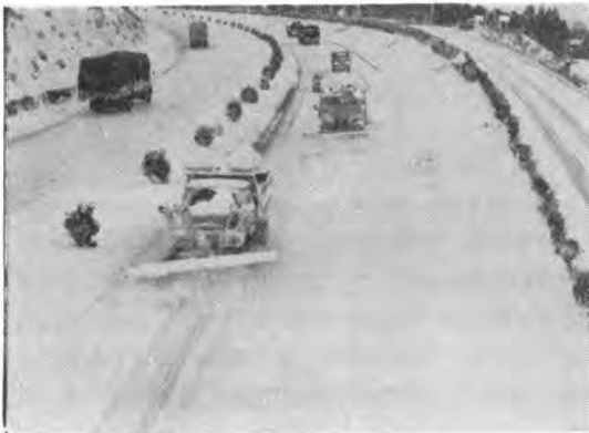
梯団編成による2車線幅除雪作業 （名神高速道路関ヶ原付近）
