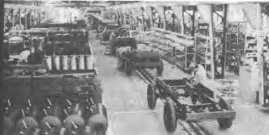
●200米コンベアラインの組立工場
