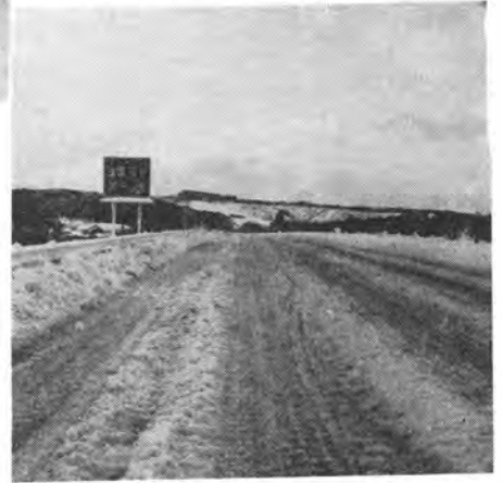
「速度落せスリップ」の電光標示板 （道路維持事務所内で制御する）
