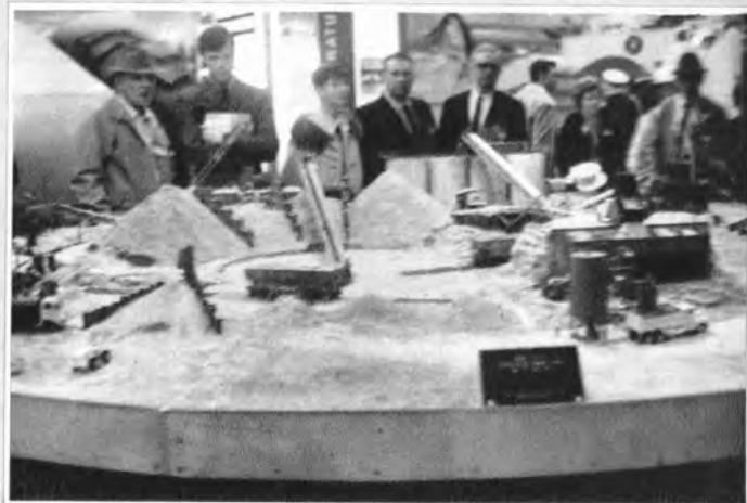
↑ 道路建設現場の模型
