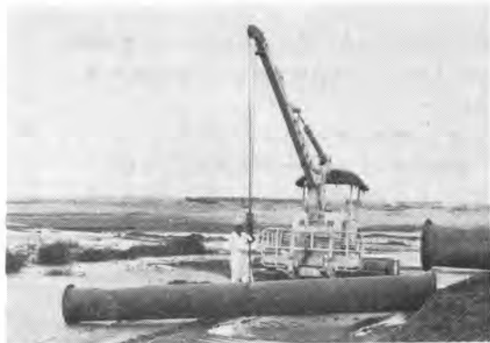
写真-2 作業状況
