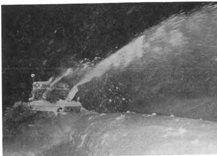
国道7号線青森工事事務所管内における ロータリ除雪車（シュミットカッタ）で の拡幅作業
