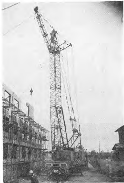
写真-5 建築用水平引込形タワークレーン
