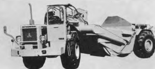
→ 三菱TMS 8形ツインモータスクレーバ 17.2t 130PS×2 昭和44年製
