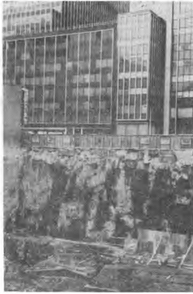
写真-13 堅硬な地盤をけずって建設するビル（ニューヨーク市）
