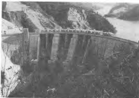
写真-1 下流から見た高山ダムと貯水池 (昭和44年3月6日)
