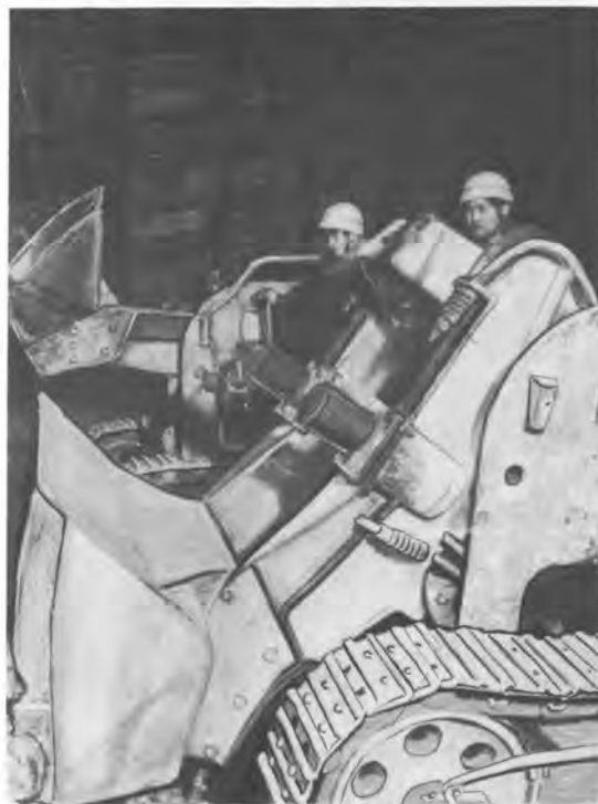
鉄建建設機新幹線帆坂作業所殿納入
