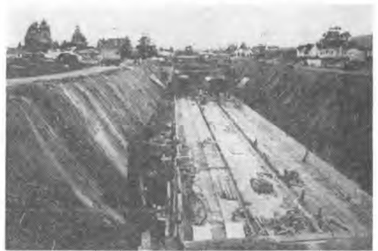
写真-5 地下鉄工事現場（バークレー市）
