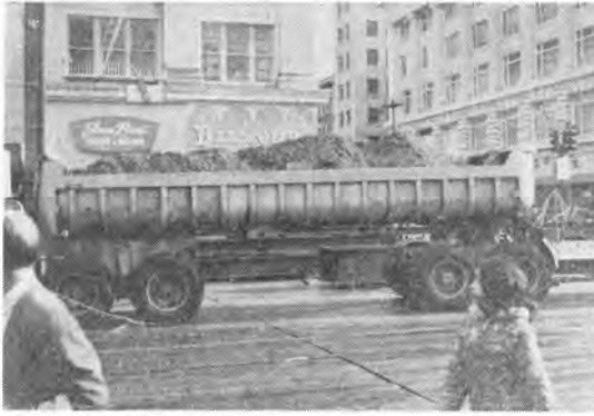
写真-7 ダンプトレーラによる地下鉄工事の掘削土運搬 (サンフランシスコ市)
