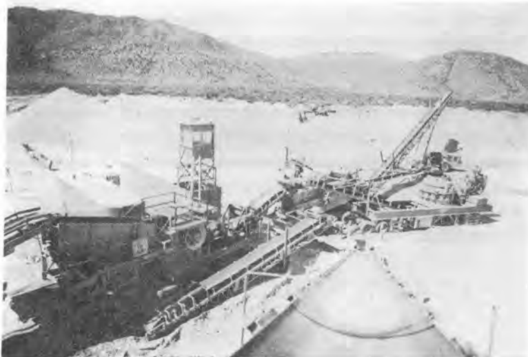
写真—1 1,050 t/hr 骨材プラントの全景
