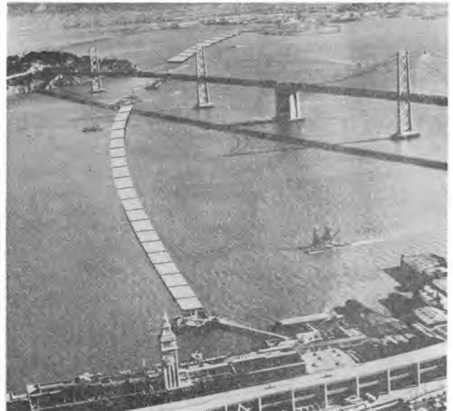
写真-6 工事中の地下鉄サンフランシスコ湾沈埋式海底トンネル部分
