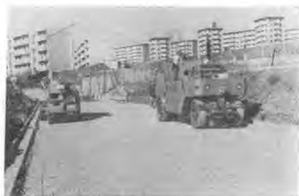
写真-4 路盤工の施工
