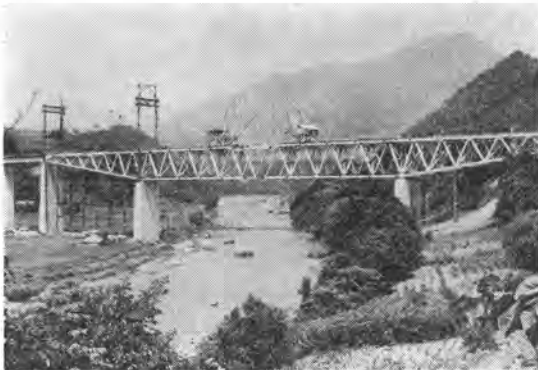
写真-3 3径間連続トラスの架設状況
