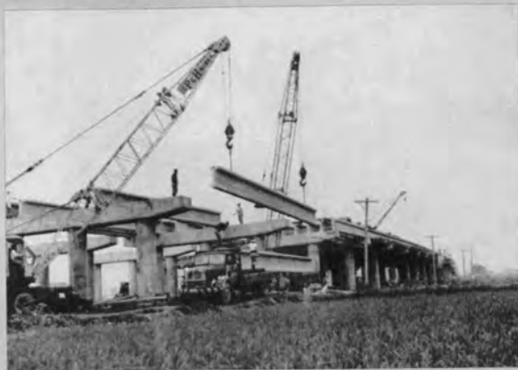
トラッククレーン2台による プレテンションドけたの架設
