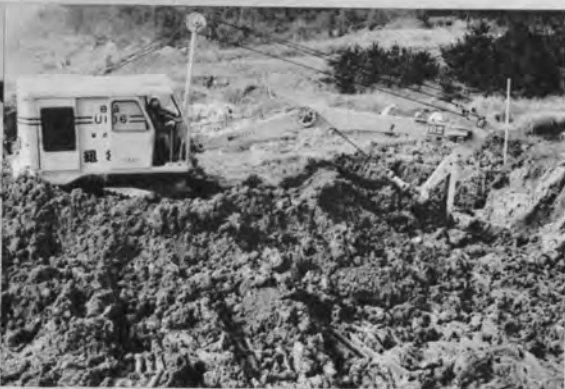
日立U106ドラグショベルによる置換掘削(名古屋)
