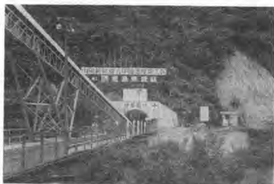
写真一2 山陽新幹線新大阪~岡山間六甲トンネル工事状況
