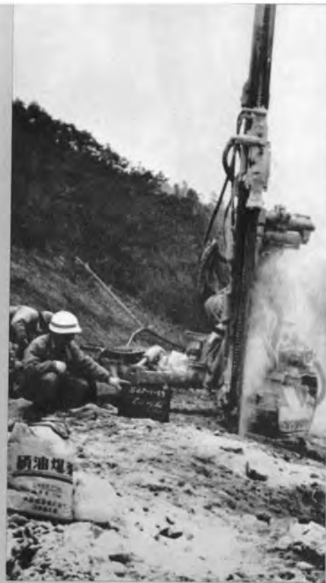
クローラドリルによる硬岩掘削(本宿)
