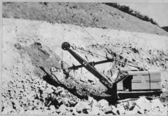
日立U102パワーショベルによる軟岩掘削(岡崎)
