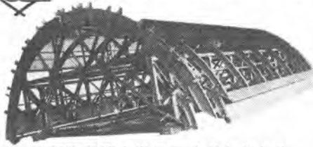
山陽新幹線上半スライドセントル
