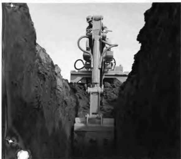
溝掘り配管工事に
