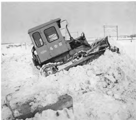
道路の除雪作業に
