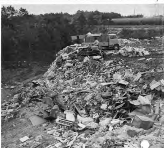
ゴミ処理場での作業に
