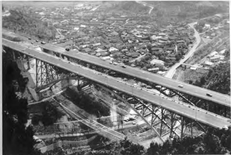
皆瀬川橋 橋面高 約80cm
