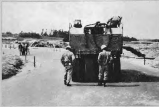
セメント安定処理サブベースの ブルーローリング
