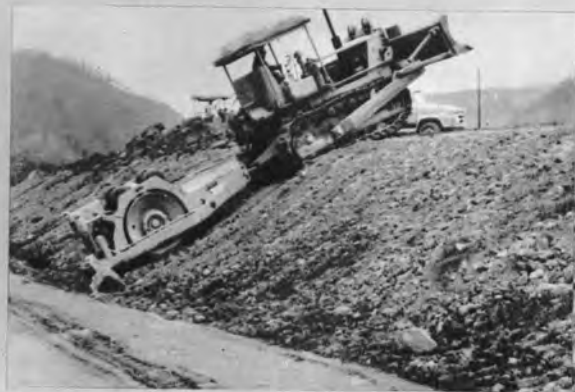
石川島播磨シメーザ振動ローラによるのり面転圧(本宿)
