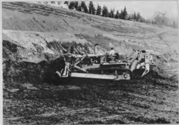
油圧リッパによる掘削
