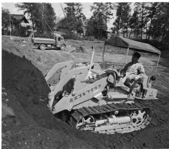
ゴルフ場の建設・維持・管理に
