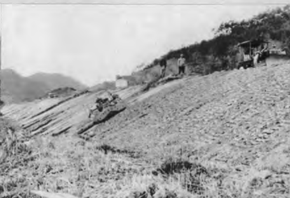
ダイハツ振動ローラを使ったのり面転圧(本宿)
