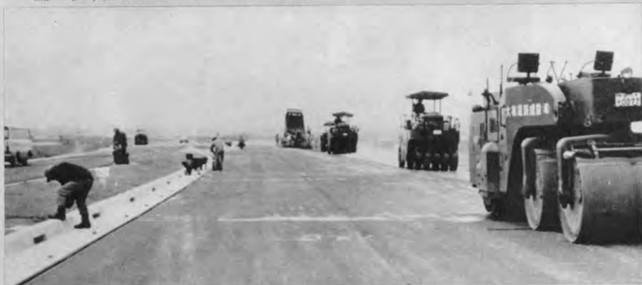
前方フィニッシャのあとをマカダムローラ、タイヤローラ、タンデムローラが追いかける。
