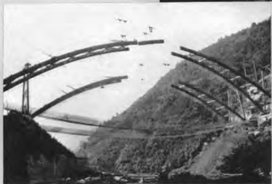
アーチ部の架設
