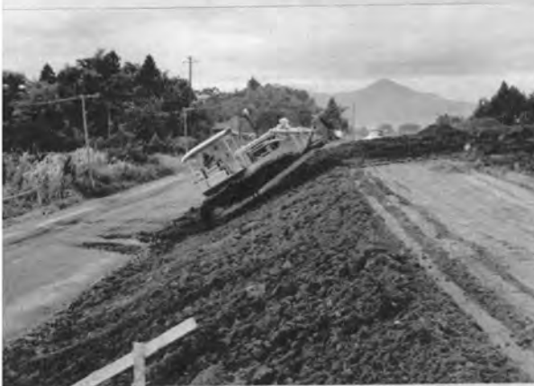
ブルドーザでのり面転圧
