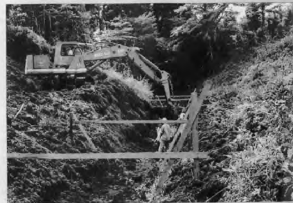
横断管路の基礎掘削
