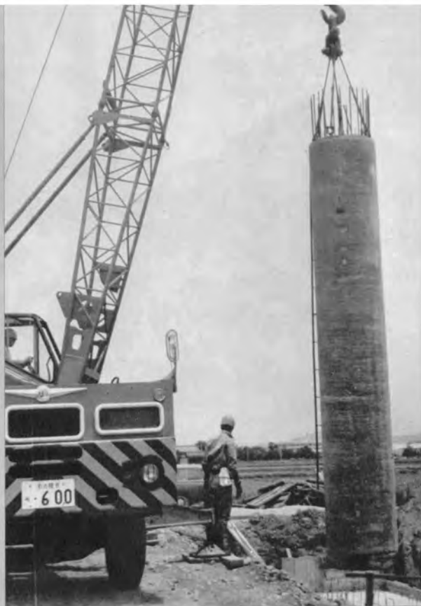
コンクリート中空円筒橋脚の建込み
