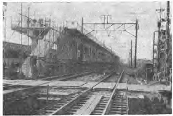
写真-1 総武線本八幡～下総中山間山西高架橋工事
