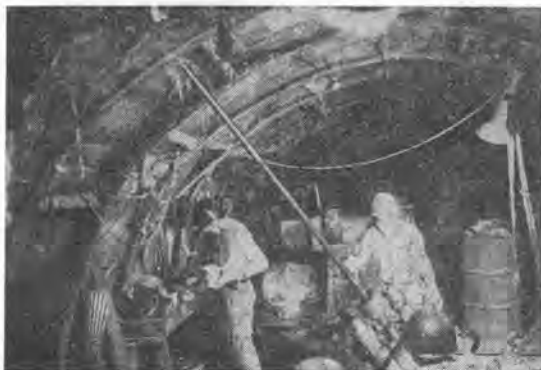
写真-3 薬液注入作業(LW→MI→エリロック・日東SSの順序で注入を行なった)
