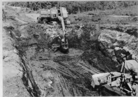
ドラグショベルによる切土施工
