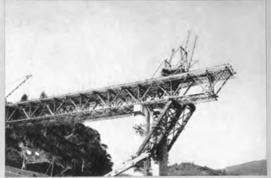
連続トラスの架設
