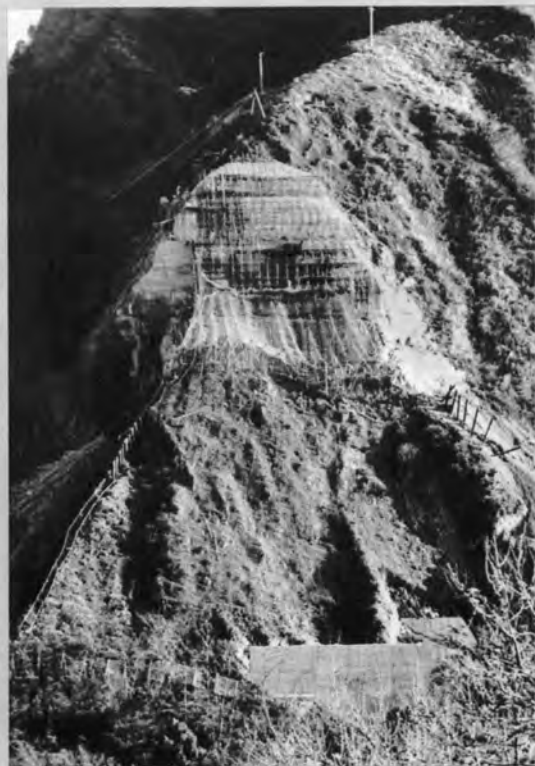
大切土工(神奈川・静岡県境付近)
