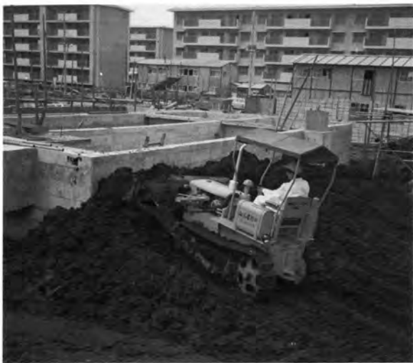
建築現場の整地作業に
