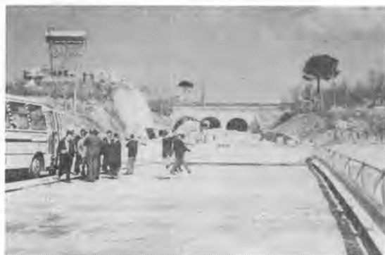
写真-8 橋りょうのスラブと埋戻しトンネル
