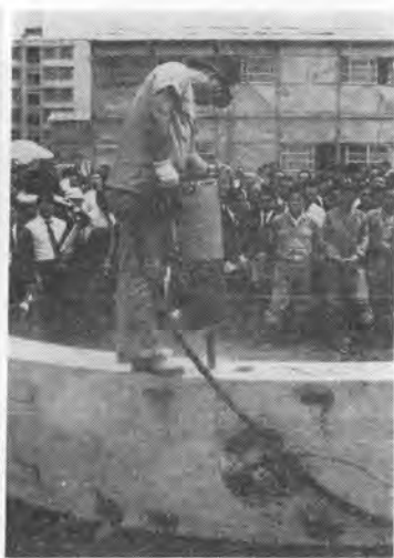
写真-6 公開実験中のコンクリートブレーカ
