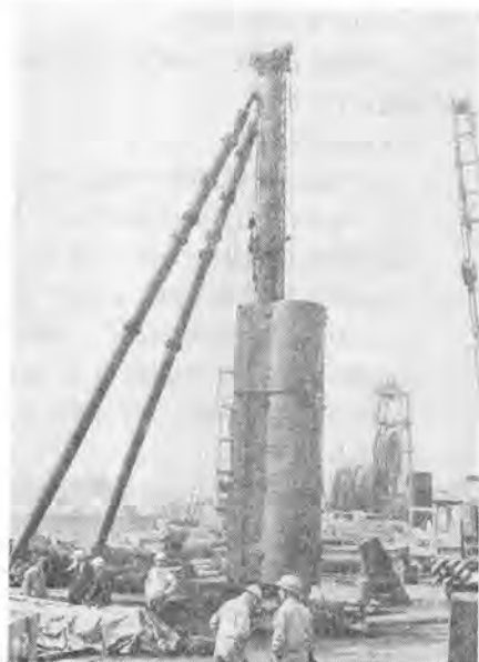
写真-1 消音効果試験時の6m防音カバー取付状況
