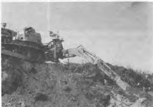
写真-3 ならい装置付のり面転圧機
