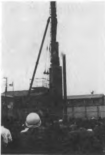
写真-5 公開実験中のディーゼルパイルハンマ(右は消音カバーを開いたところ)
