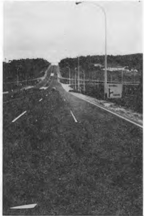
写真-6 サラザール橋取付道路
