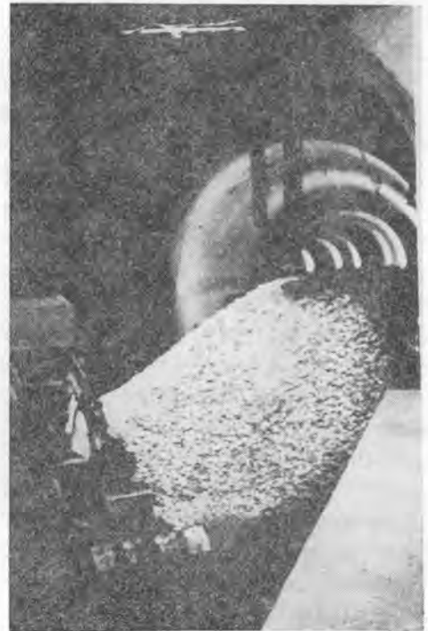
写真-2 地表からトレミー管で送られる道床バラス(パリ地下鉄)
