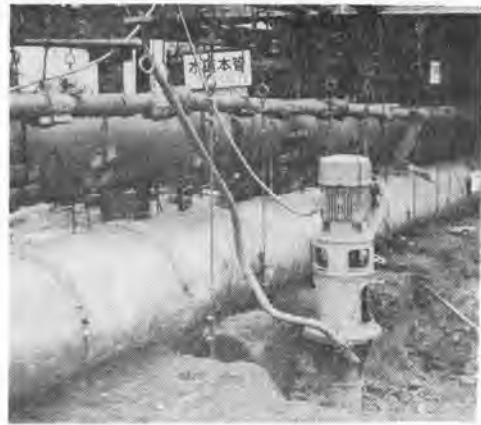
写真-3 地下埋設部の状況およびディープウェル工
