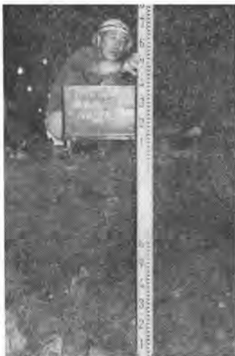
← 写真-4 頸城1工区1,470m付近 盤ぶくれ区間盤下げ
