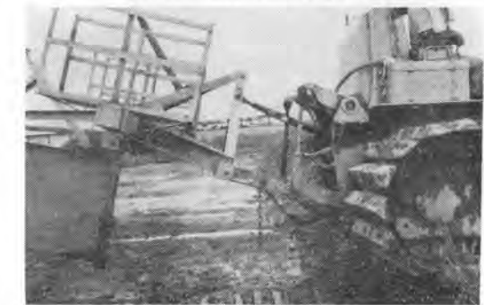
写真-4 止水板埋設機(その2)
