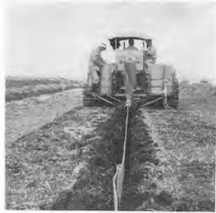
写真-3 止水板埋設機(その1)
