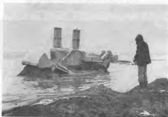
写真-1 無線操作中の水陸両用ブルドーザ
