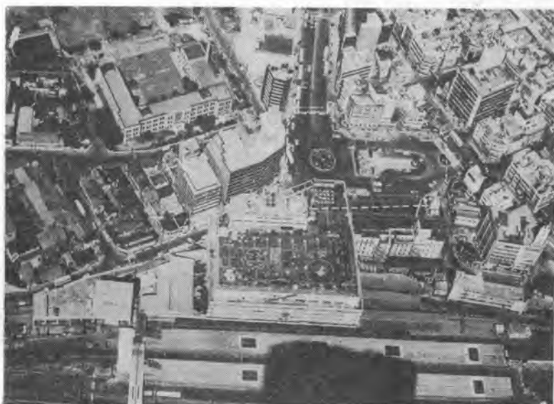
写真-1 池袋西口広場（点線部が地下駐車場）
