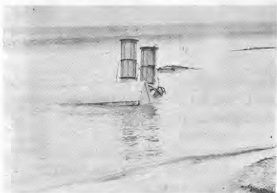
写真-2 水深 3m で作業中の水陸両用ブルドーザ
