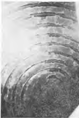
写真-3 木ノ浦トンネルでの RTM 正辟壁面
