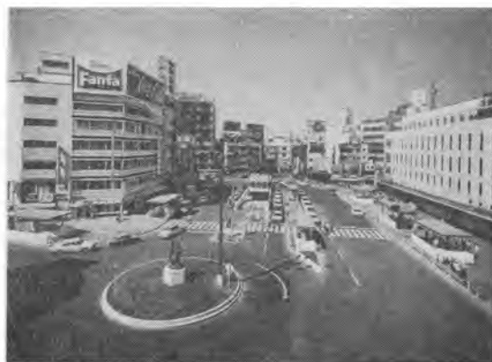
写真-2 池袋駅西口地下駐車場出入口
