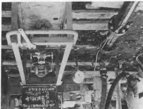
写真-3 左側 4" オリフィス、右側差圧および圧力発信器
