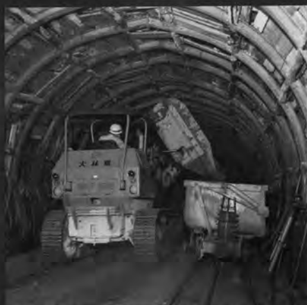
955k サイドダンプバケット（隧道内の積込み）
