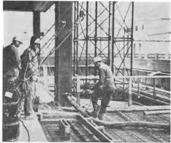
写真—2 ゴムホースをあやつっての コンクリートの打設
