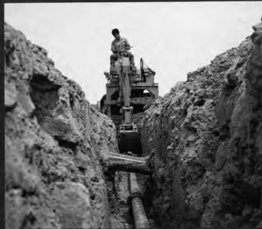
B53 バックホー（溝掘り）
