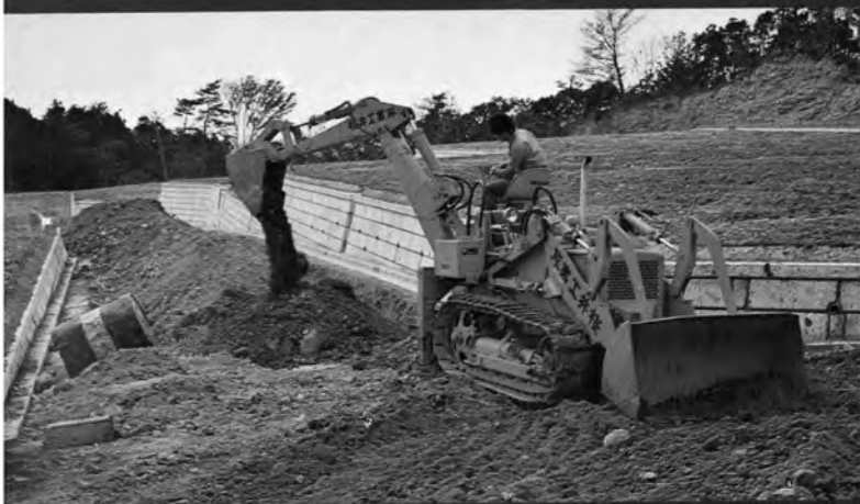
B53 バックホー（配管工事）
