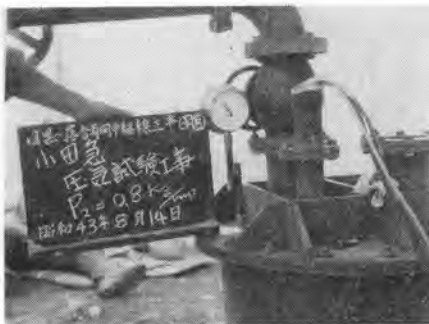
写真-2 ケーシング上端の状態
