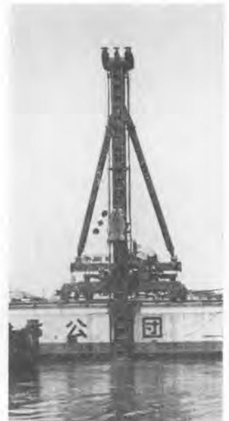
写真-5 スクリード走行路くい打ち機
