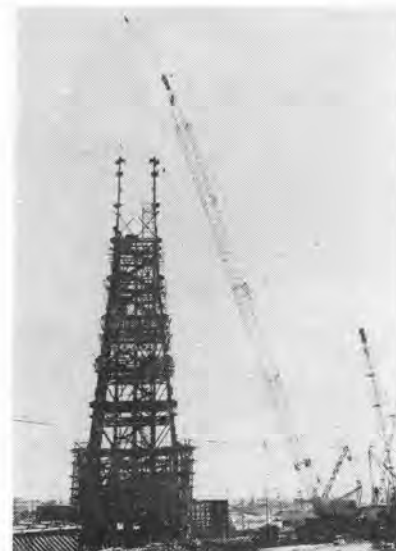
写真-22 P & H 9125 トラッククレーン
