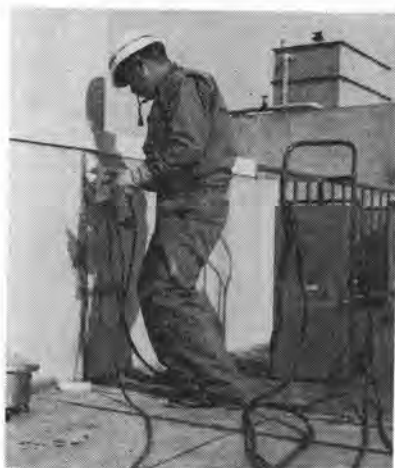
写真-26 ADOX エポキシ注入機作業状況
