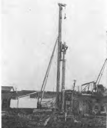
写真-14 壁体パイル圧入機
