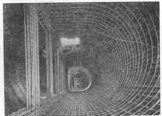
写真-3 No. 5 沈埋函内部鉄筋組み
