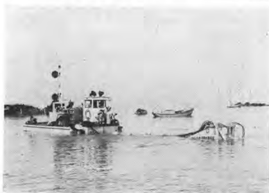
写真-27 水中ブルドーザ1号形海底作業
