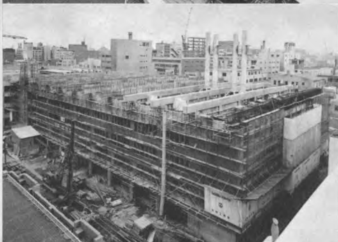
同上 躯体が最上階まで立ち上り、屋上 に高速道路、高架街路のけたが架設さ れている。（44年2月）
