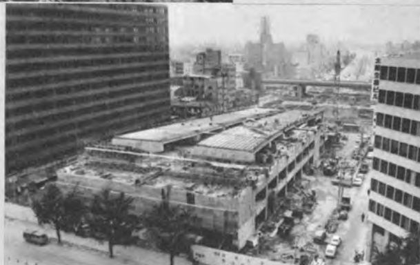
10号館屋上の高架街路 ランプウェイの工事 (44年5月)
