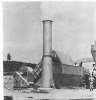
写真-19 ロートクロン (湿式集塵機)
