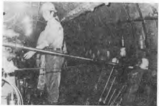
写真-1 ボーリング実施中
