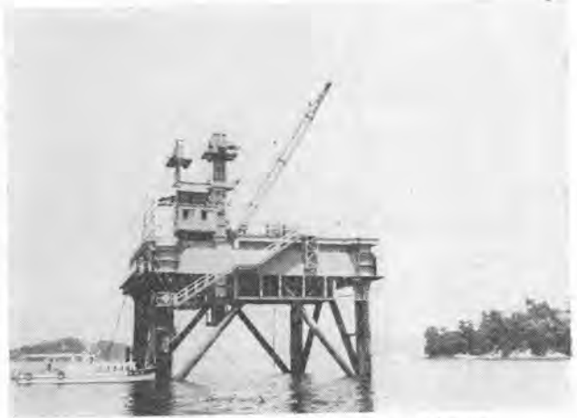
写真-2 海中鉄構足場と組立中のモルタルプラント
