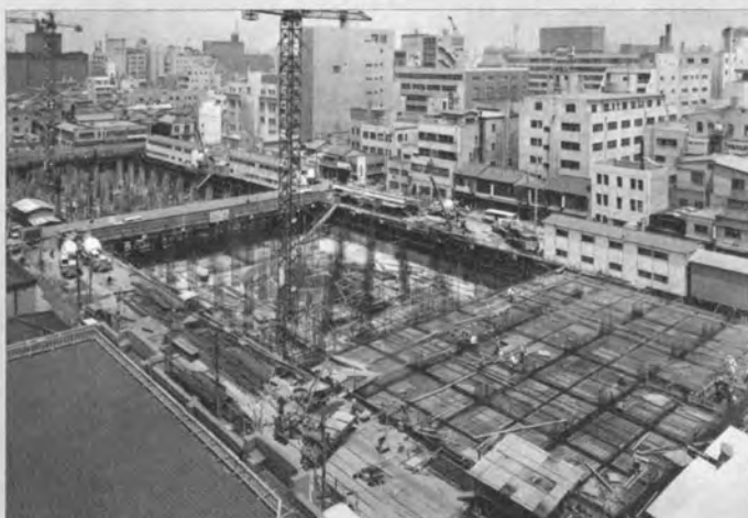
船場センタービル5・6号館地下躯体工事 （43年6月）
