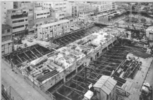
2・3号館の地下躯体工事 敷地が狭いので中央部から先 に進めていく。(43年7月)
