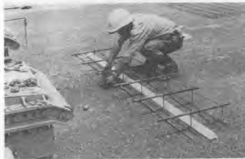
写真-6 収縮目地の2チェアのスリップパー
