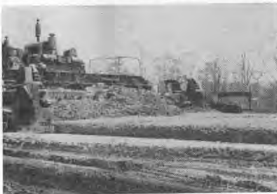
写真-1 アメリカでの普通の2車線用スリップフォームペーパ(ノースカロライナ州)
