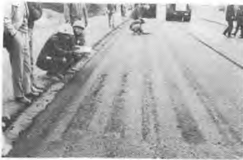
写真-3 (A)-III-1 10% (125°C) 転圧状況
