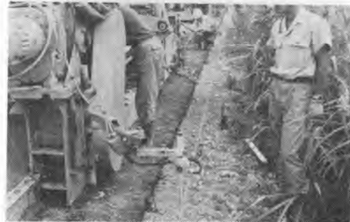
写真-12 スリップフォームペーパーのセンサ
