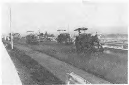
写真-4 ゴム入りサーフェース転圧作業
