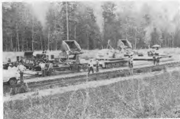
写真-2 1日に2車線で2mile 施工している現場 (ミズリー州)
