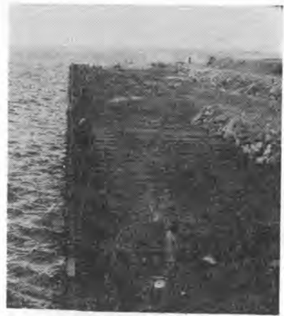
写真-9 矢板式岸壁(打込まれた連続鋼管矢板)→
