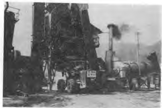
写真-5 グース混合プラントとフィルードライヤ
