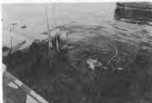
写真-7 潜水作業
