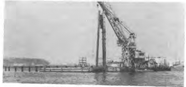
写真-10 直ぐいの建込み
