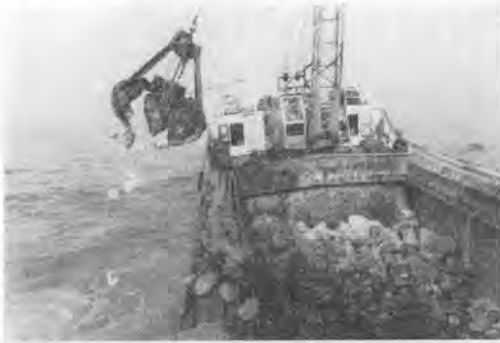
写真-3 ガット船による基礎石の捨込み
