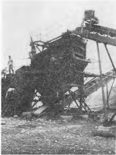
写真-4 山砂利ふるい分け (40mm)
