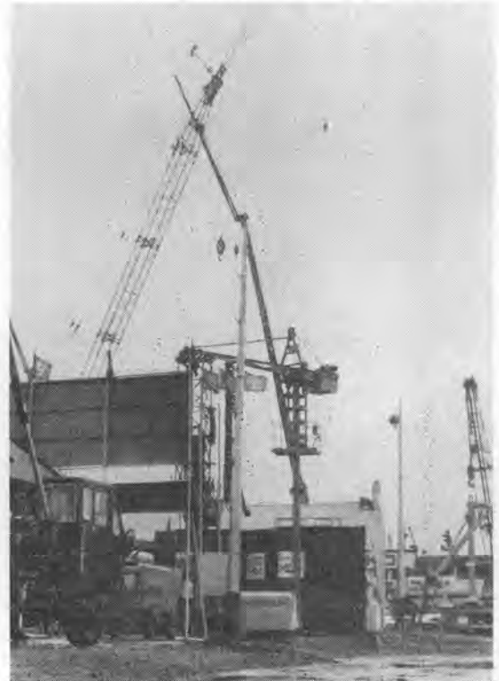
写真-13 簡易クレーン (郡産業)
