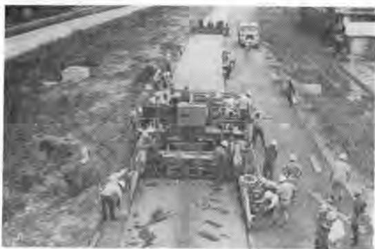
写真-4 新大宮バイパス初めての試験施工
