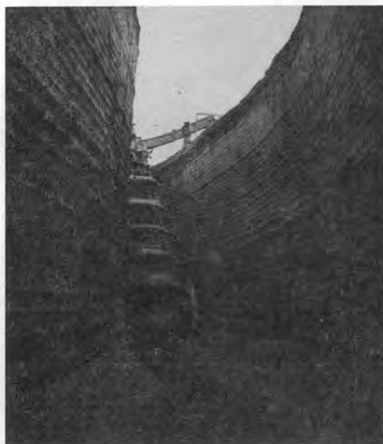
↑ 写真-2 溝掘り機による溝掘り作業
