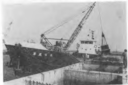
写真-5 据付けられたケーソンと中詰作業
