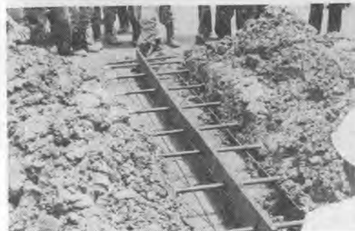
写真-7 膨張目地の施工
