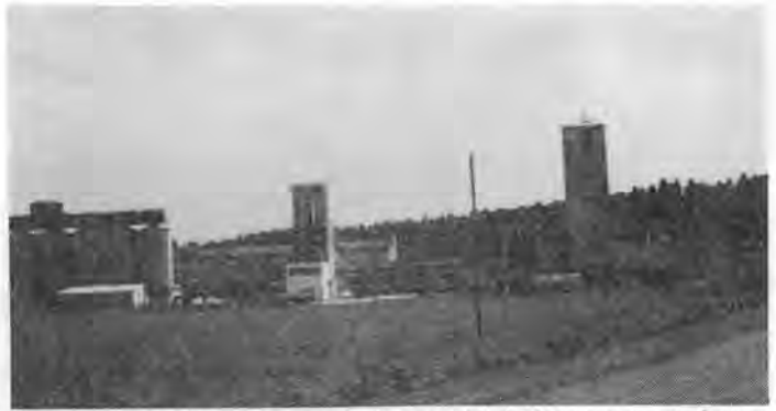
写真-1 スイスの定置式アスファルトプラント（右）左側はコンクリートプラント
