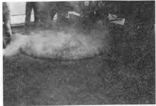
写真-6 グース敷きならし作業直前
