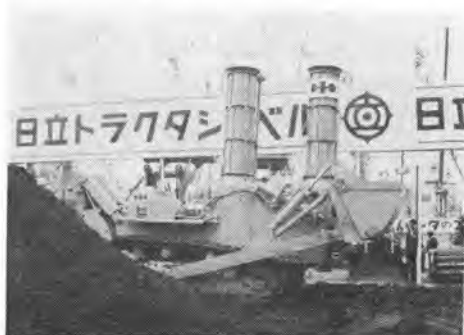
遠隔操作による無人水中ブルドーザ
