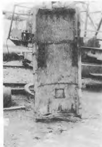
写真—4 パンチングプレート取付状態 （消音器上部）
