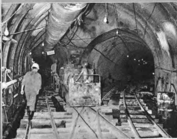
上：T.B.M.掘削後のレール敷設(北海道方調査坑) 右：バッテリーロコモティブ(北海道方調査坑)
