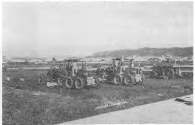
写真-1 拡張部分の用地造成
