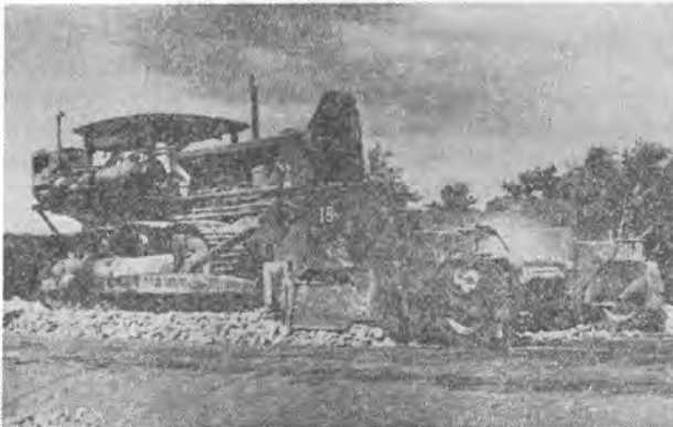
↑ ストーンスプレッダによる突固め作業 スプレッダボックスの後にタンバシュエを取付け、敷きならし、突固めの同時作業を行なう。シュエには十分な効果が上げられるよう油圧をかける。
