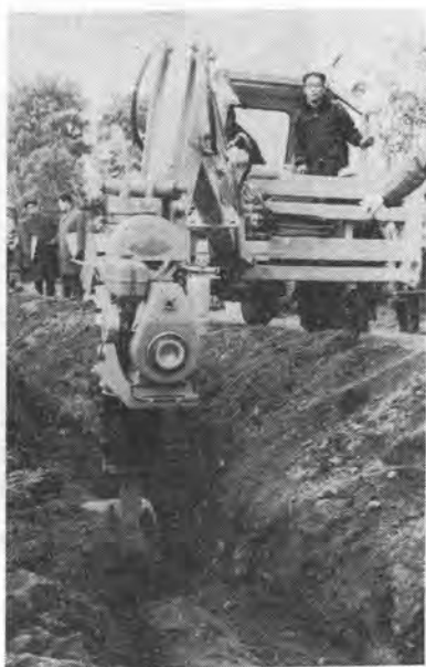
← バイプロタイピング装置をつけたエキスカベータローダ
