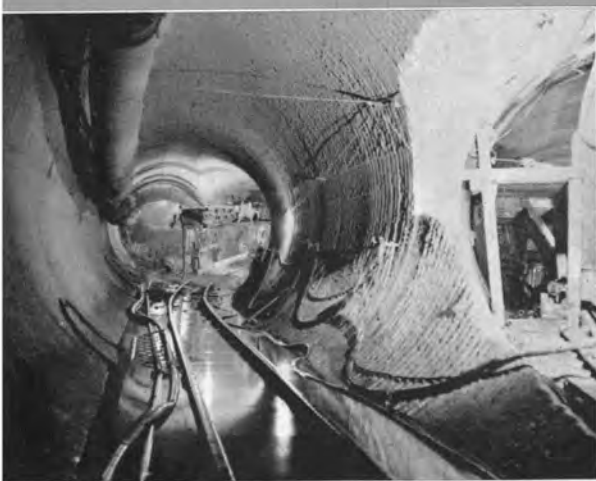
上：T.B.M.掘削後のレール敷設(北海道方調査坑) 右：バッテリーロコモティブ(北海道方調査坑)
