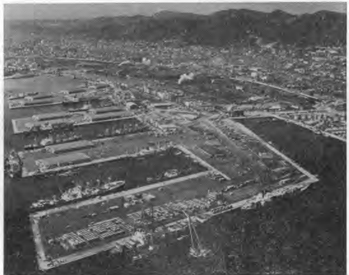
写真—6 摩耶ふ頭全景
