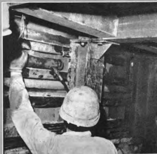
本州方調査斜坑1,223m 付近の破碎帯におけるメッセル工法による導坑掘進 (20t油圧ジャッキを使用)
