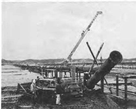
↑ 送泥管荷役作業のクレーン付ブルドーザ
