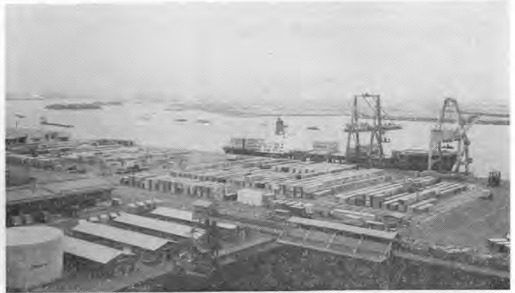
写真-2 東京港品川ふ頭で荷役中のジャパンエース
