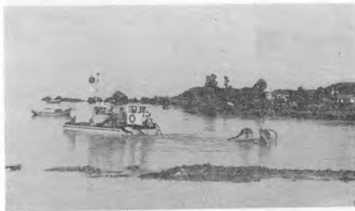
写真-4 有珠湾で稼働中の水中ブルドーザ実用1号機
