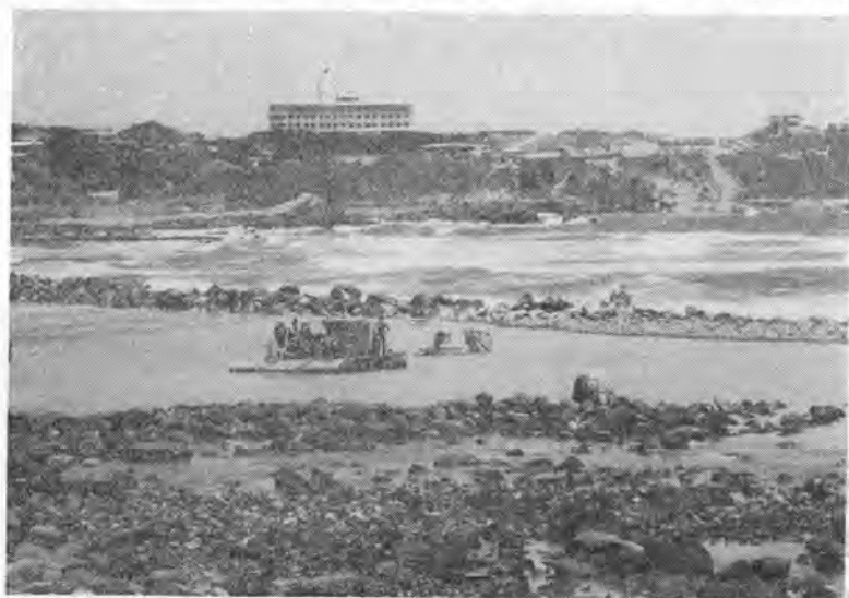
写真-2 銚子市海水浴場造成工事で稼働中の水中ブルドーザ試作機
