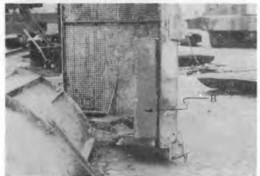
消音器上部下端、B部取付
