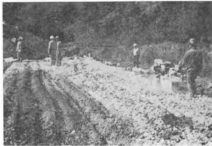
地盤の路上混合安定処理に使用されている耕運機
