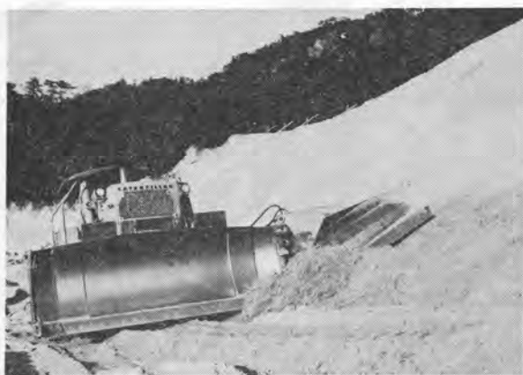
↑ のり面掘削整形中のサイドスローバ付ブルドーザ
