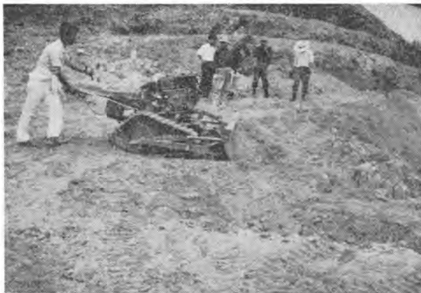
階段工作業中のハンドドーザ
