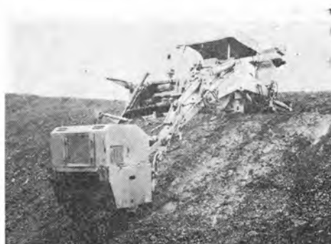
↑ ブルドーザに装着されたのり面締固めローラ
