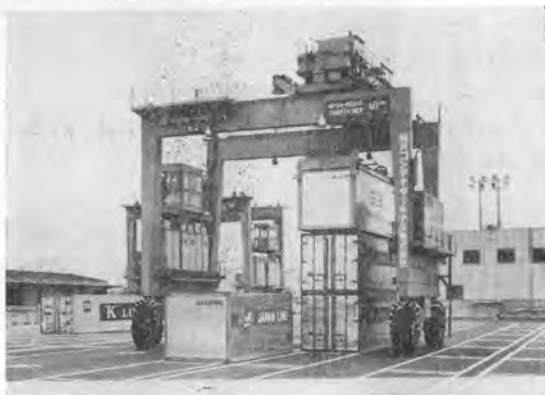
写真-10 ヤードクレーン (神戸港摩耶頭)
