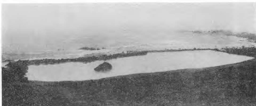
写真-3 完成した銚子市長崎町海水浴場
