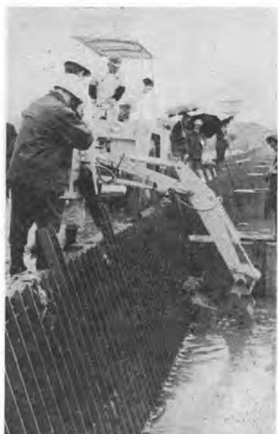
↑ 取水口除塵作業中のエキスカベータローダ
