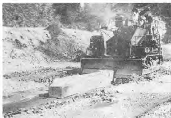
写真—6 アスファルトコアフィニッシャ（前部）
