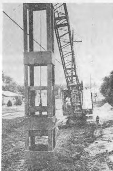
↑ クレーン、ハンマ、リード により形成される締固め機
