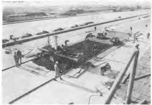
写真-2 滑走路コンクリート打設
