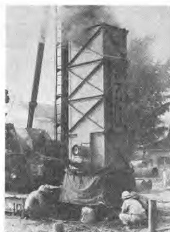
写真-5 フジ MD パイル工法による施工状況
