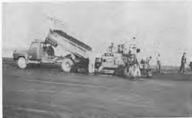
写真-3 滑走路アスファルト打設
