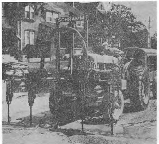
↑ ストーンスプレッダによる突固め作業 スプレッダボックスの後にタンバシュエを取付け、敷きならし、突固めの同時作業を行なう。シュエには十分な効果が上げられるよう油圧をかける。
