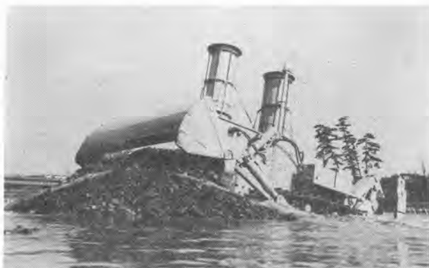
写真-1 多摩川で施工中の水陸両用ブルドーザ
