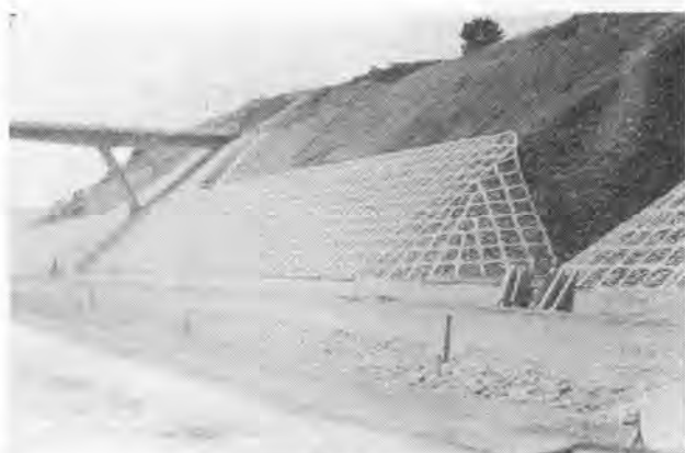
写真-1 のりわく工
