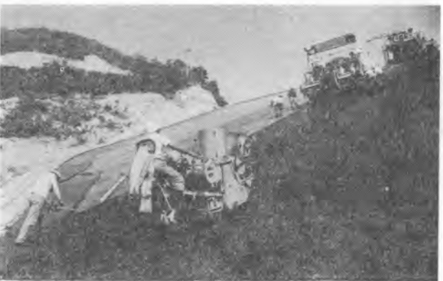
写真-5 二の倉ダム
