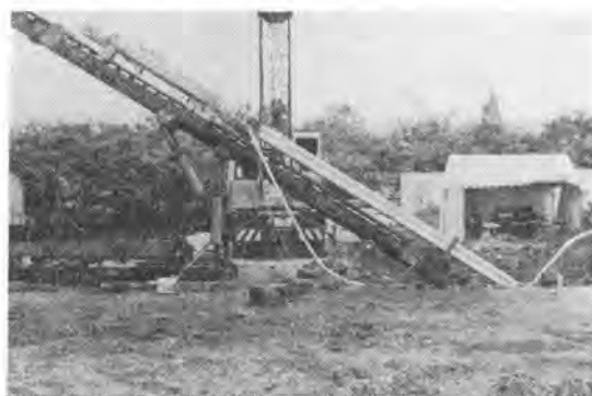
写真-4 斜ぐい打ちテスト
