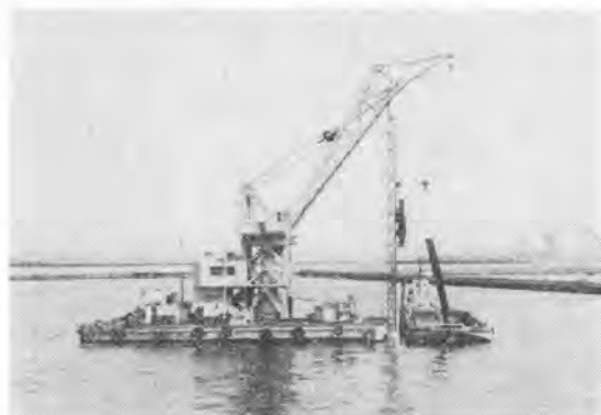
写真-20 旋回式くい打ち船
