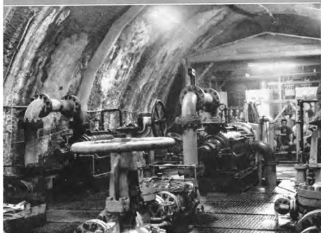
北海道方調査坑坑底の大形排水ポンプ設備
