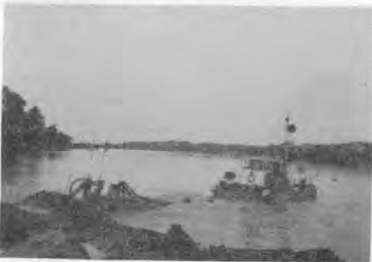
写真-2 水中ブルドーザによる海底掘削工事
