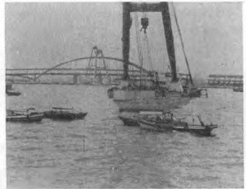
写真-9 神戸港一般外航定期船岸壁ケーソン据付
