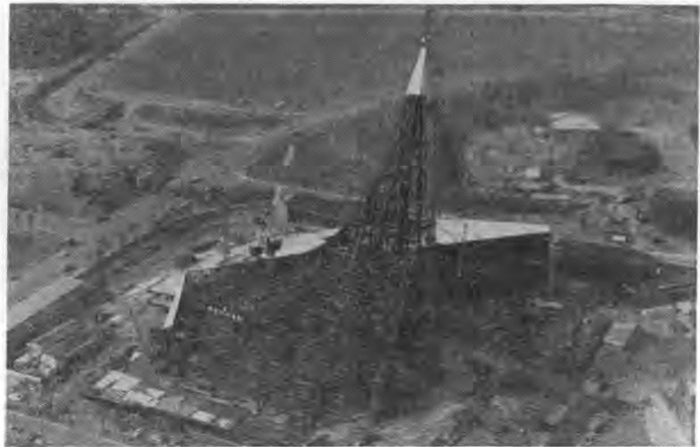
写真-6 外殻鉄骨の建方完了し、外壁パネル取付中のソ連館
