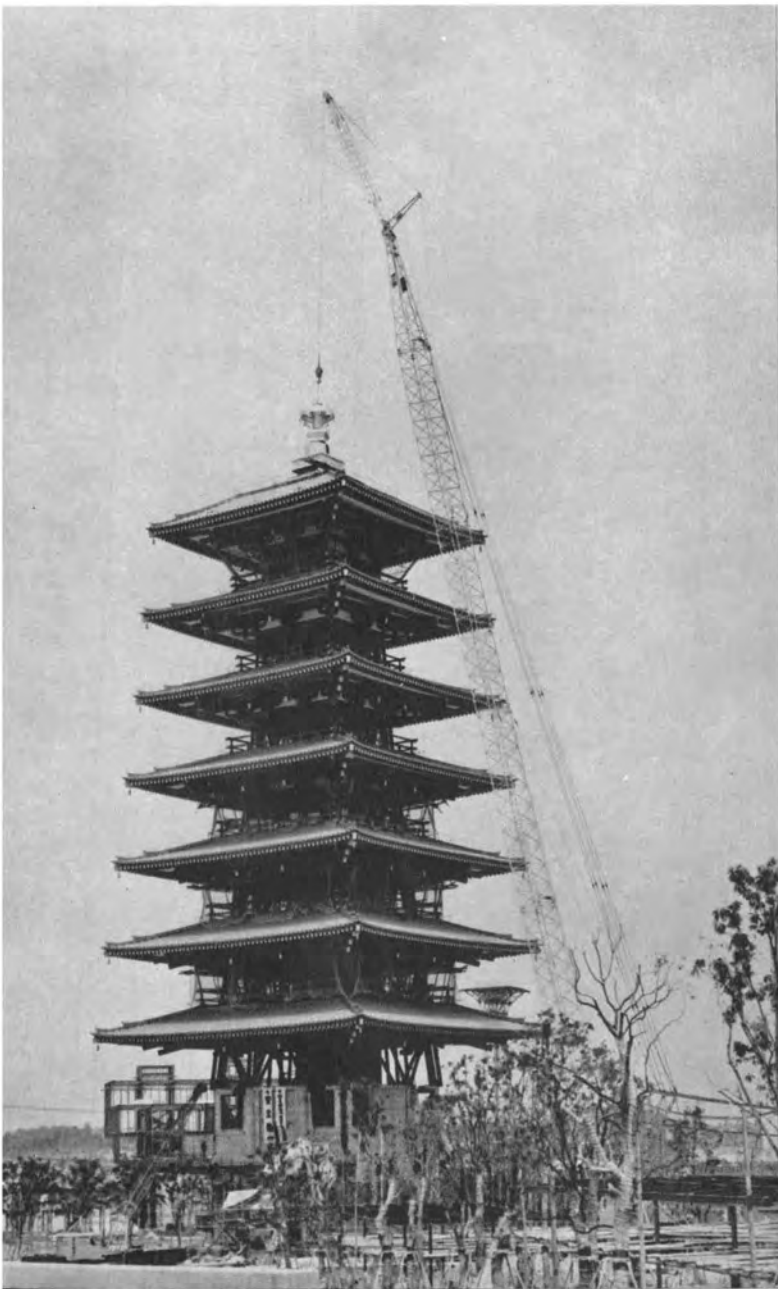
屋根の取付完了 P & H 9125-TCによる相輪建方
