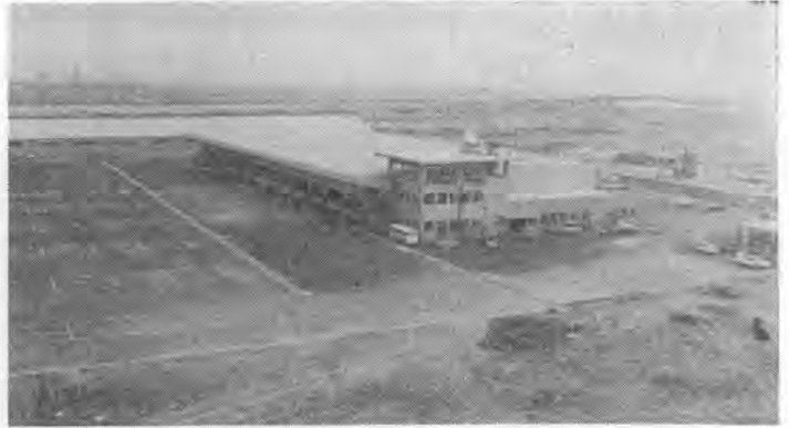
写真-5 管理棟およびフレートステーションはホイストクレーンを取付け得るように入口の下半分の扉を観音開きにしている。
