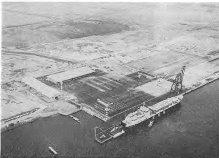
写真-1 大阪港コンテナふ頭第1号岸壁の全景
