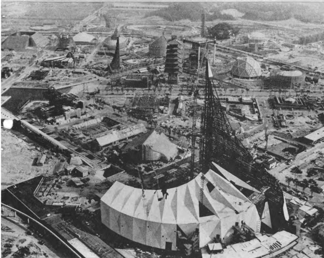
外殻鉄骨の建方完了し 外壁パネル取付中
