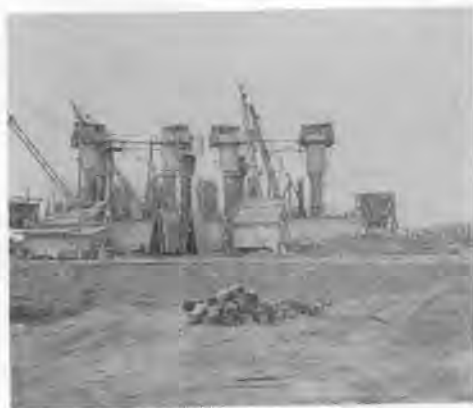
写真-1 ケーソン工事現場(手前低い所が側橋脚部)
