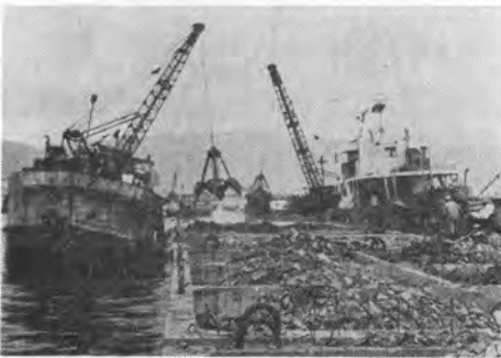
写真-8(B) 神戸港の岸壁工事施工状況(その2)
