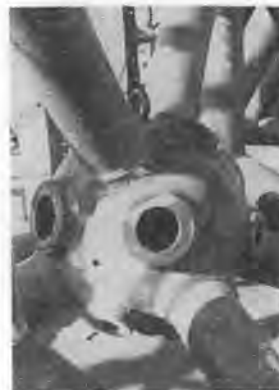
写真-1 柱に組込んだ 球ジョイント
