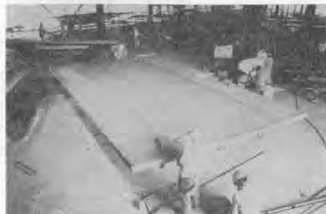
写真-9 下地わくにフォーミングされた鉄板を取付ける
