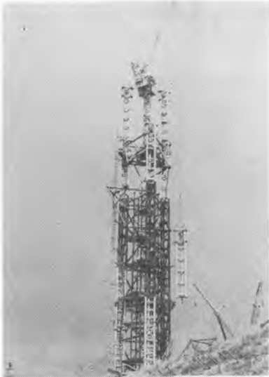
写真-4 建方作業中(地上 75.0 ~92.5m の柱のつり上げ作業, タワークレーンベースは地上 70.0 m に盛替えている。9月 10日)
