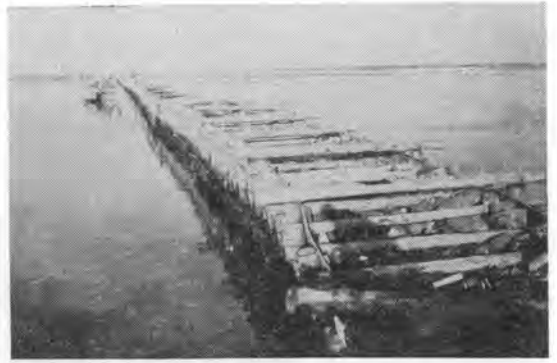
写真-15 埋立地の仮護岸
