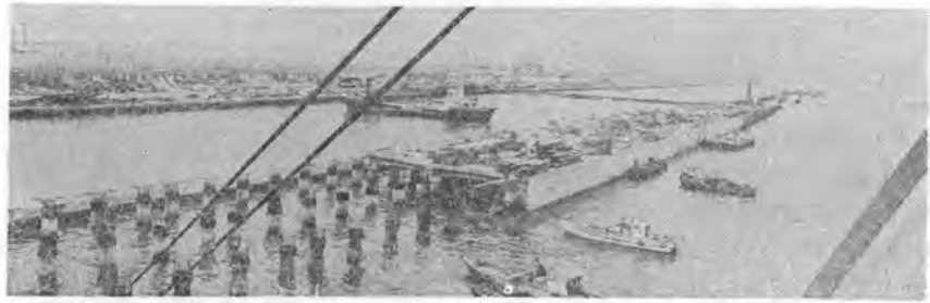
写真-2 大阪港 棧橋工事
