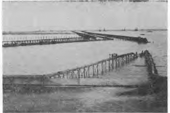
写真-16 排砂管の配置
