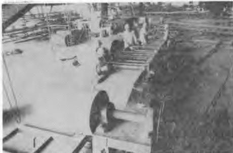
写真-7 外装パネルに使用する鋼板はコイルで搬入し、現場でロールフォーミングを行なう。
