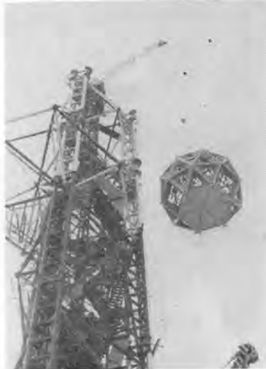
写真-6 つり上げ中の展望室
