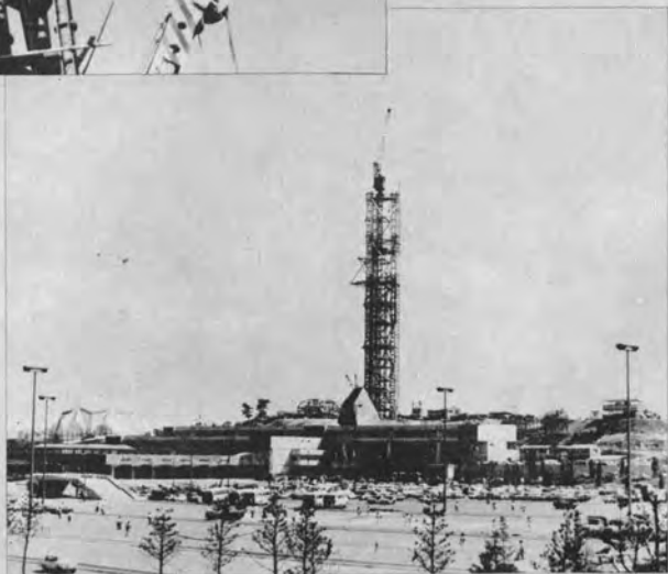
建方中のランドマークタワー (万博千里橋より望む)
