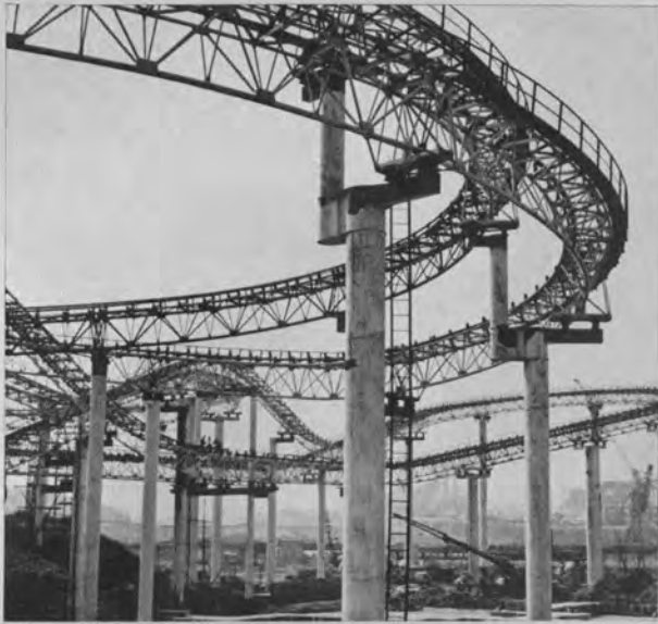
入り乱れたガーダを支える支柱群
