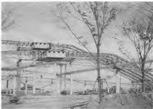
写真-1 巻上げ用ガーダと機械室
