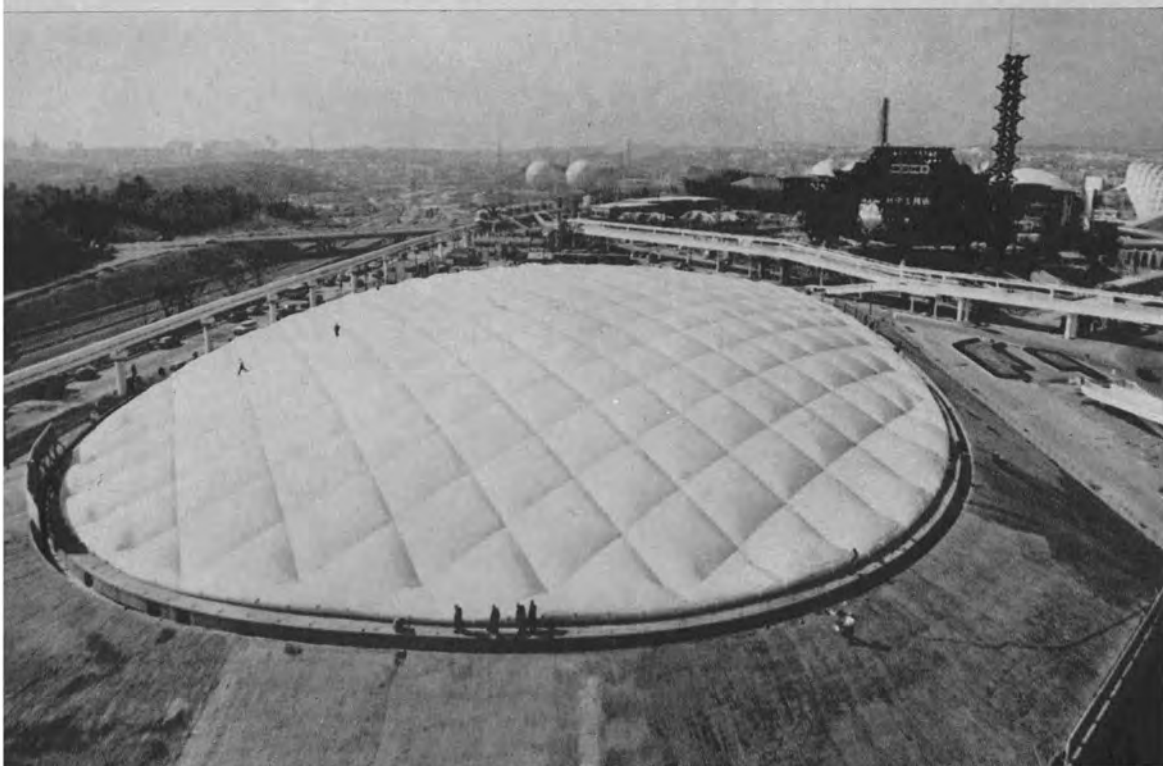
グラスファイバーの巨大な屋根
