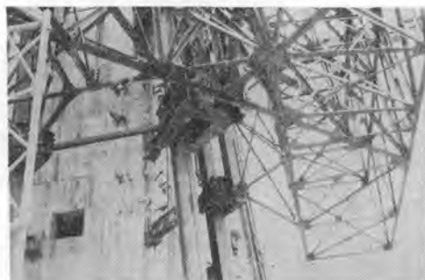
写真-4 スライディング中の台車構台を下方からみる
