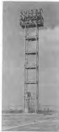
写真-6 ヤード照明塔
