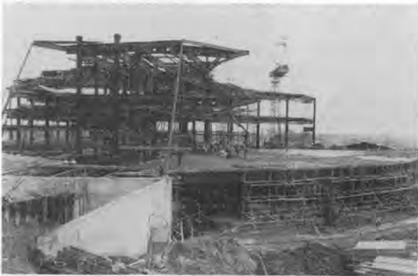
写真-2 内部鉄骨の建方
