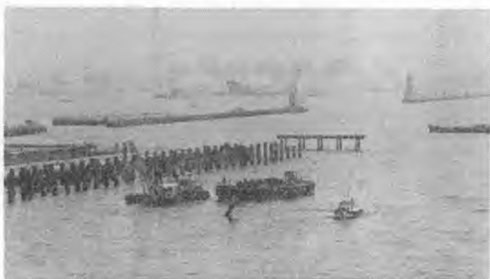
写真-2 グラブ式浚渫船の稼働状況 (横浜港本牧ふ頭)
