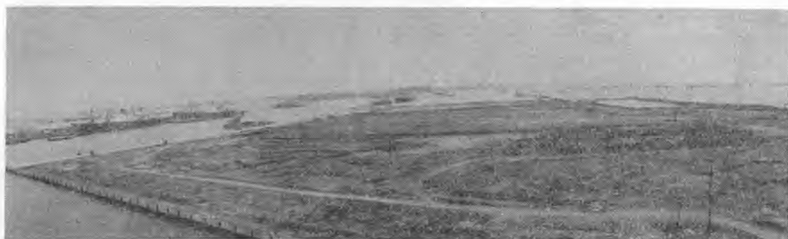
写真-1 横浜港本牧ふ頭A突堤の埋立状況 (昭和44年7月)
