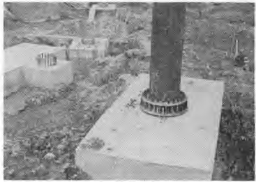
写真-2 井筒形基礎の形状
