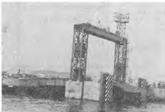
写真-5 ロールオン・ロールオフ式可動橋の全景
