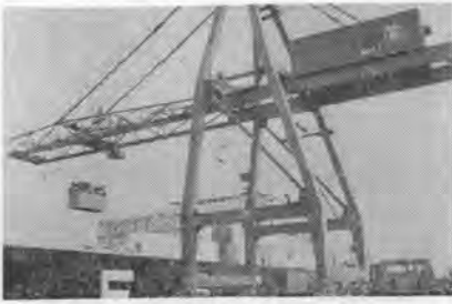
写真-4 コンテナクレーン稼働状況
