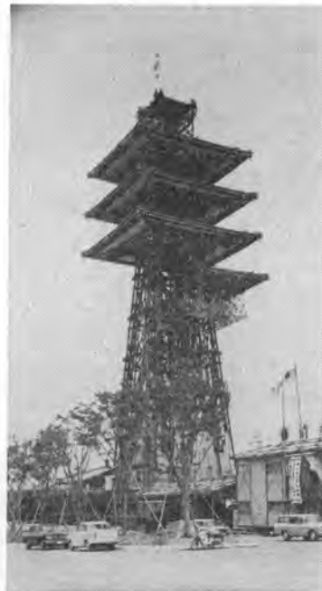
写真-3 4層1号基スライディング中
