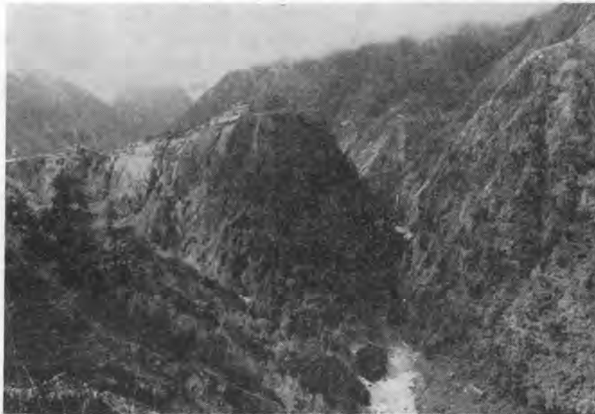
写真-3 貯水池建設予定地付近の地形
