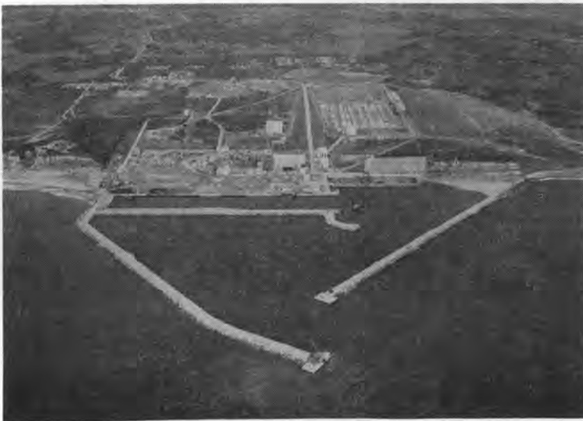
← 写真-1 福島原子力発電所全景
