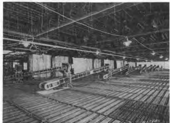
写真-6 高速コンクリートコンベヤ
