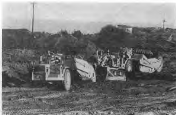
写真-2 構内整地工事掘削状況
