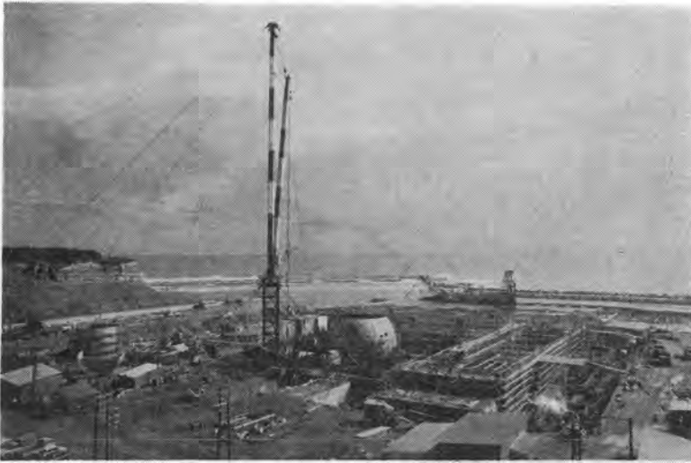
写真-4 原子炉圧力容器の取込み、 据付け中 ↓ (昭和44年5月21日)
