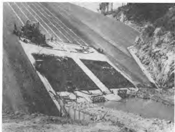
写真-3 遮水アスファルト工事
