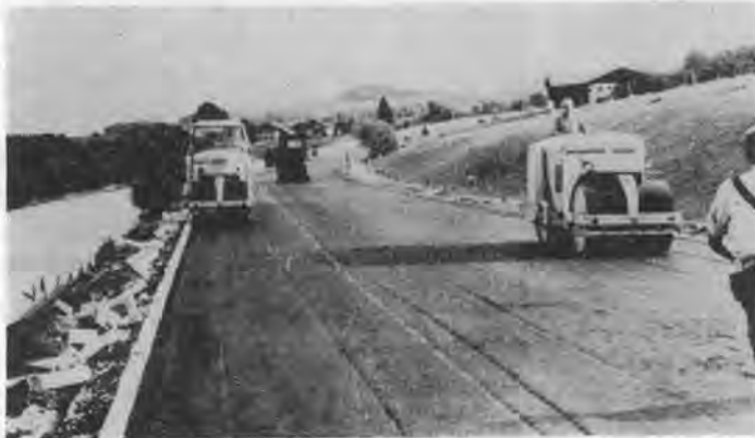
写真—1 振動ローラとタイヤローラによる厚層アスファルトの締固め
