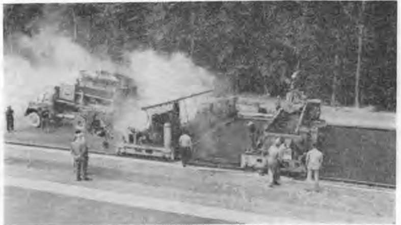
写真-2 グースアスファルトの施工状況
