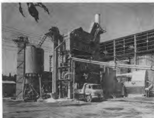
写真-1 150 t/hr アスファルトプラント
