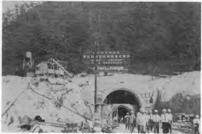
写真-4 山陽新幹線西庄トンネル入口
