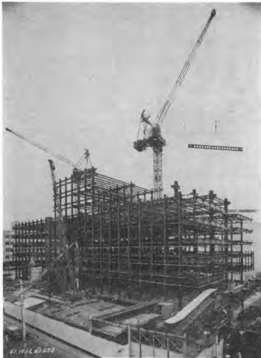
写真-5 タワークレーンによる鉄骨建方状況
