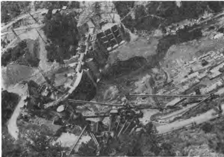
写真-1 現在施工中の下達見ダム
