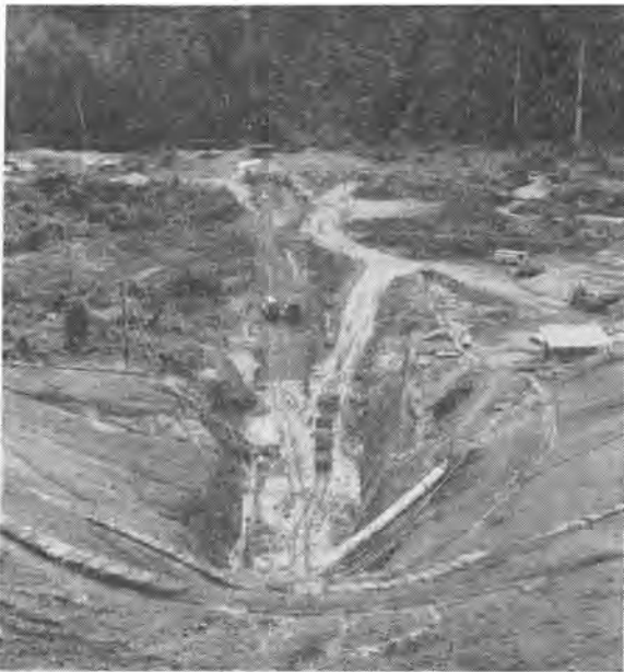
写真-2 トンネル坑口(呑口側)
