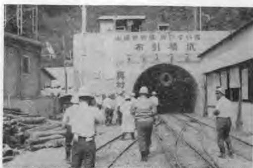
写真-3 山陽新幹線神戸トンネル布引横坑入口付近
