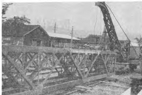
写真-4 上構部分けた, つなぎけたおよび端末けた
