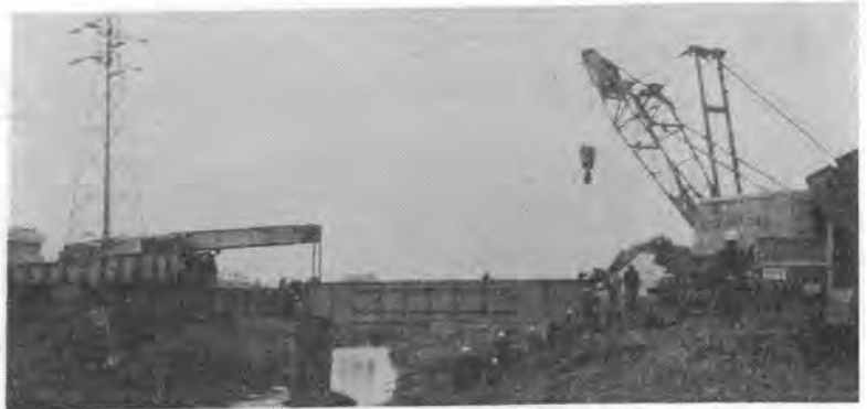
写真-3 操重車とトラッククレーン相づり工法
