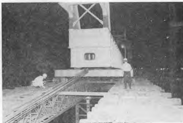
写真-5 移動台車による鋼けたの縦取り
