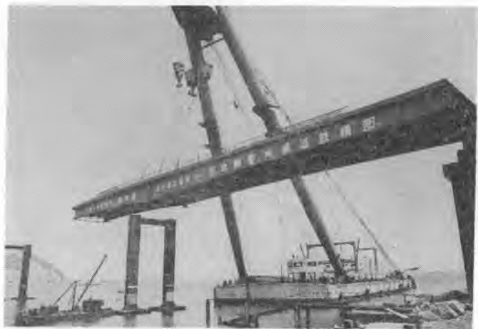
写真-2 フローティングクレーンによる架設
