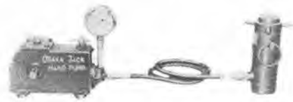
写真-8 (1) 分離式油圧ジャッキ(安全ナットなし)
