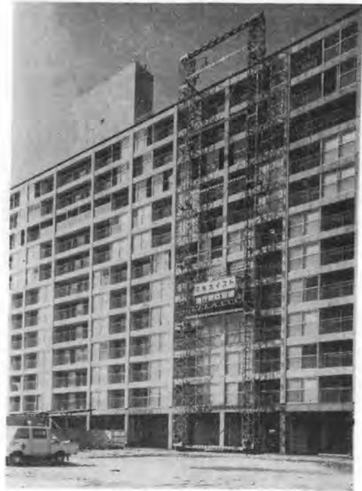
写真-2 走行式昇降足場
