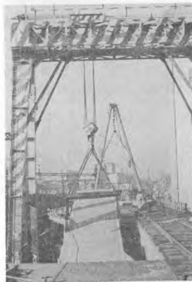
↑ 写真-2 荷卸し地組みに使用した例(その1)
