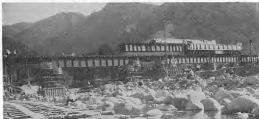
写真—1 橋けた架設に活躍するソ-300形式操重車
