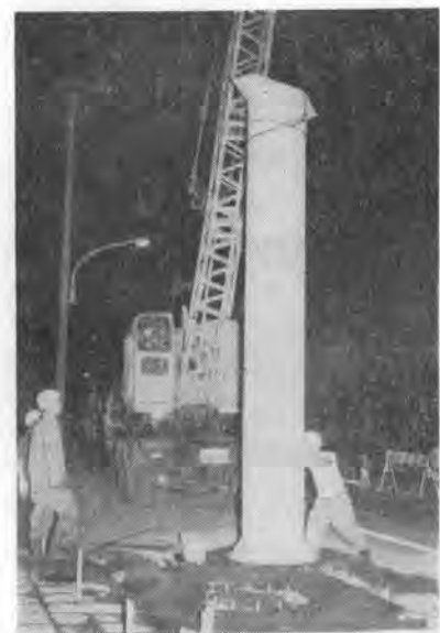
写真-1 支柱の建込み
