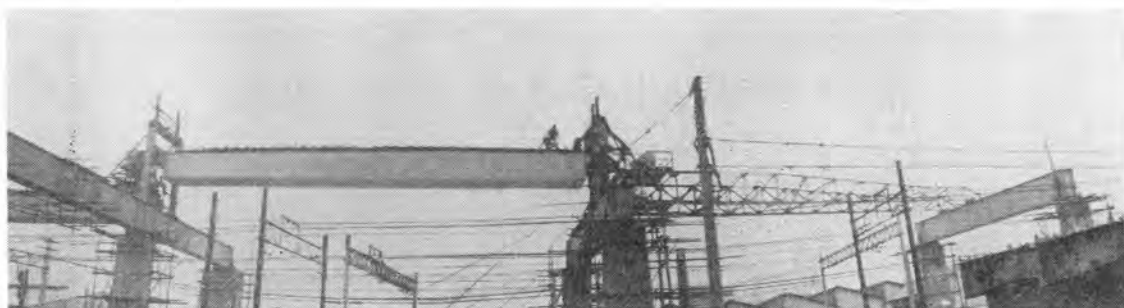
↑ 写真-7 けた引出し完了，降下中
