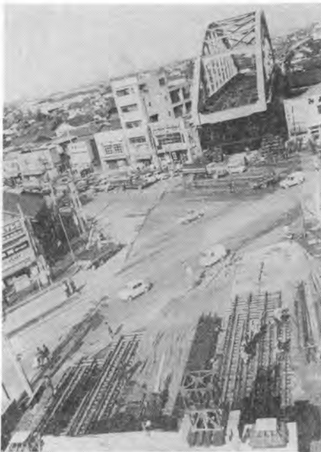
写真-5 移動ベント工法
