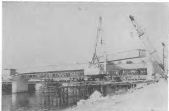
写真-2 支保工兼縦取り用走行路として使用する場合
