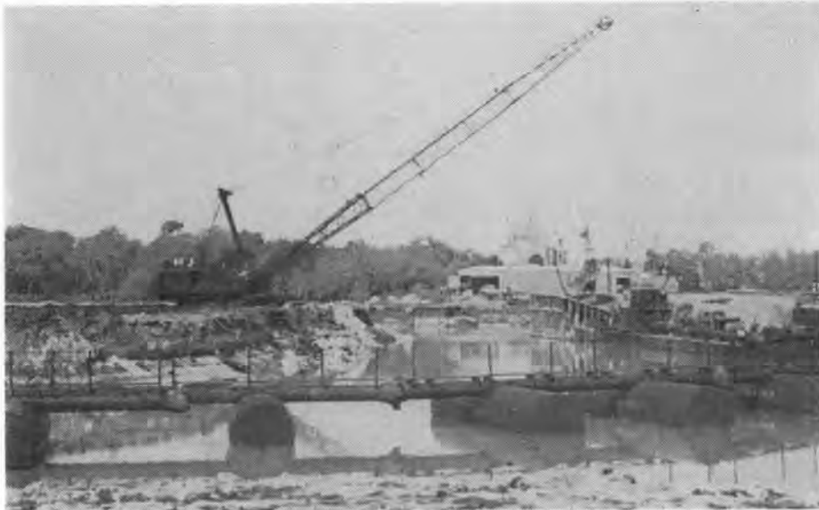
写真-1 作業現場全景
