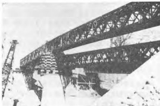
写真-5 木曾川工事において仮通路として架設された重構けた(上構けた支間 45.0m)
