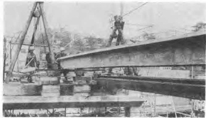
写真-5 2段ローラによる工事
