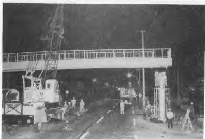
写真-2 主けたの架設
