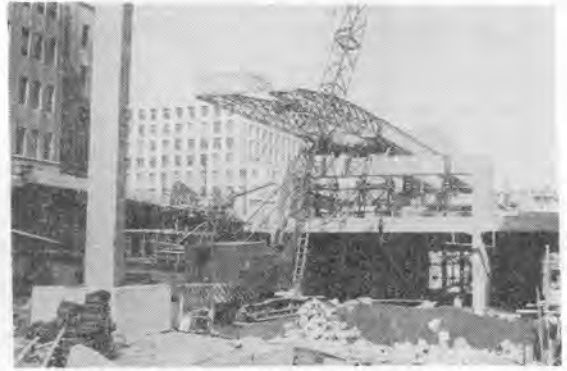
写真-2 半手延機による架設
