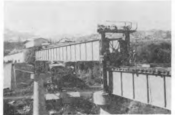
写真-3 降下装置付手延機による架設
