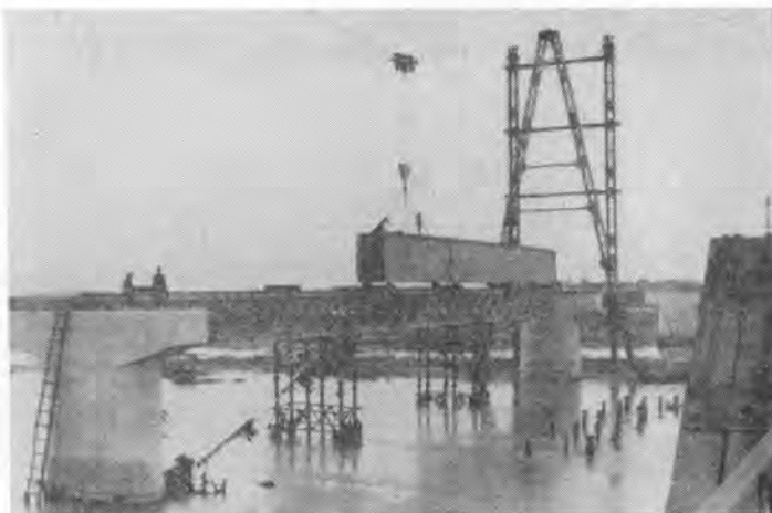
写真-3 支保工として使用する場合
