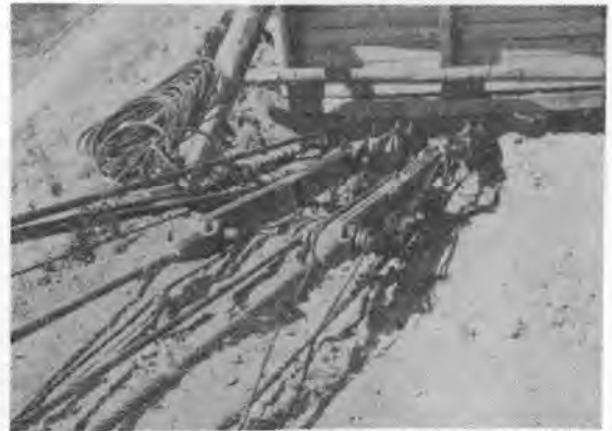
写真-4 トラックケーブル調整装置 (アジャスタブルリンク)
