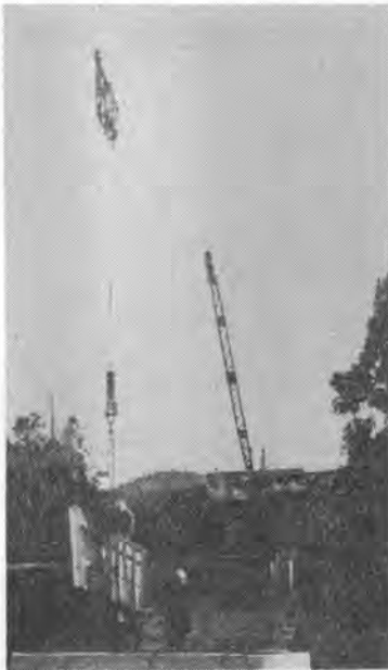
写真-1 ティルトタワー
