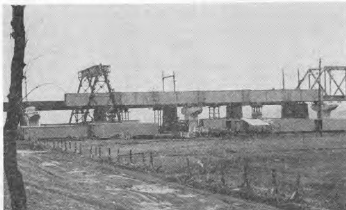
↑ 写真-2 荷卸し地組みに使用した例(その1)
