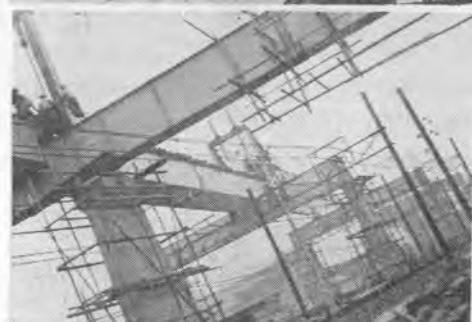
↑ 写真-10 けた降下完了
