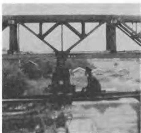
写真-14 片持ち架設の支点
