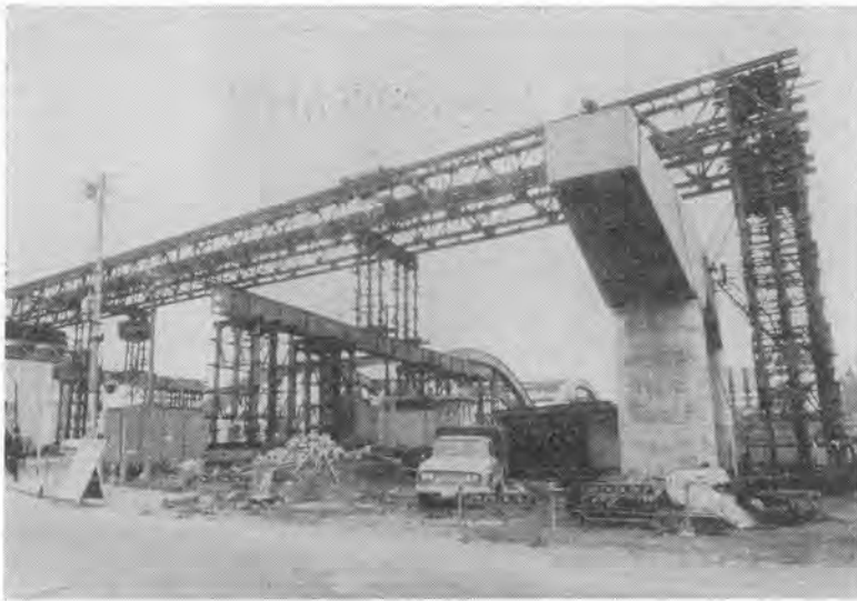
← 写真-1 支保工兼荷役設備として使用する場合
