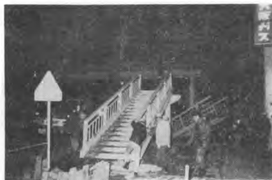
写真-3 階段の取付け
