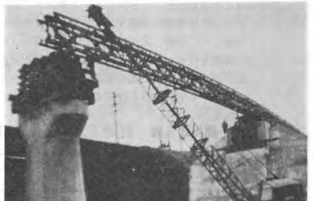
写真-13 片持ちによる引出し(2列同時)
