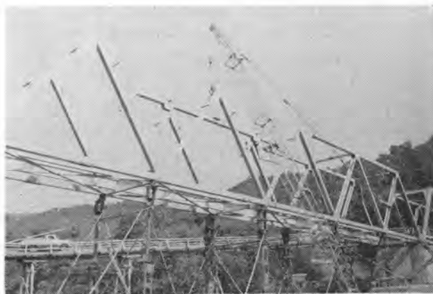
写真-1 自走クレーンによるトラスの架設
