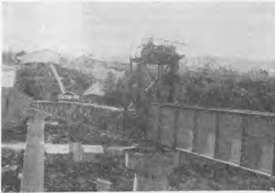
写真-1 長手延機による架設
