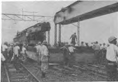
写真-2 操重車相づりによるRCけた縦移動
