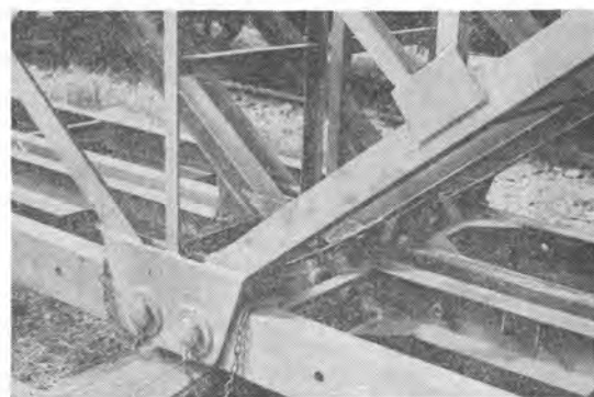
写真-7 上構部分けたとつなぎけたの連結部
