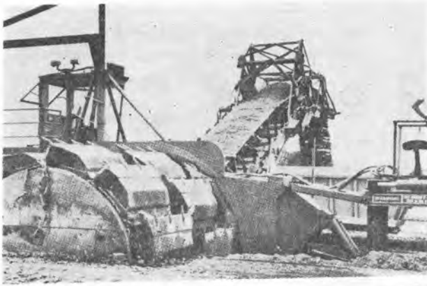
←写真-2 掘削装置の能力に合わせて変速できる 搬送用ベルトを有するエキスカベータ
