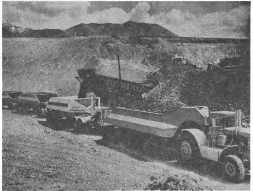
写真-2 ブルドーザで押土運搬し、ベルトローダで積込む
