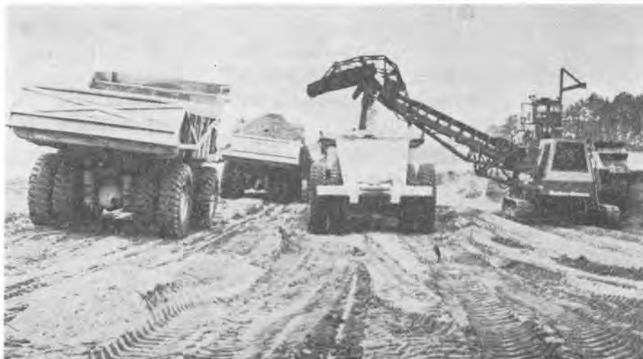
写真-1 エクスカベータのストレッチ装置により2列に並んだ運搬車へ掘削土を積込む
