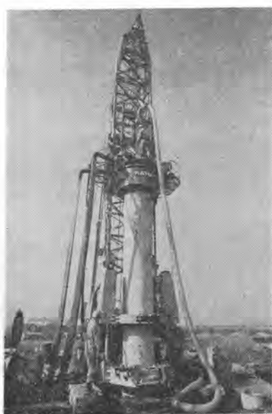
写真-1 STM工法圧入機
