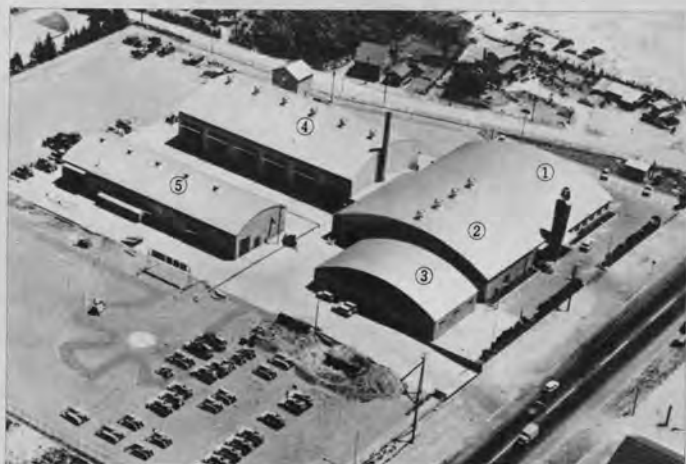
←①は事務所、②、③は部品庫、④は12台の大形機械修理可能な修理工場、⑤は部品再生、塗装工場である。
