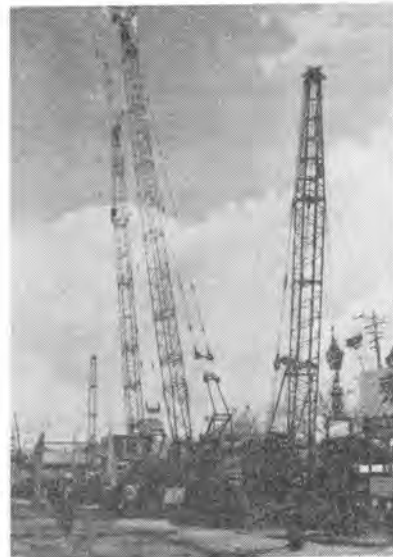
林立するクレーン
