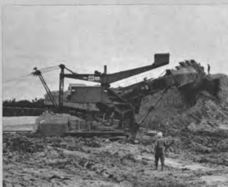
稼働中のホイールエキスカベータ(上) 延々と続くベルトコンベヤ(全延長約20km)(右上) コンベヤ末端で土砂放出するスプレッタ(右下)
