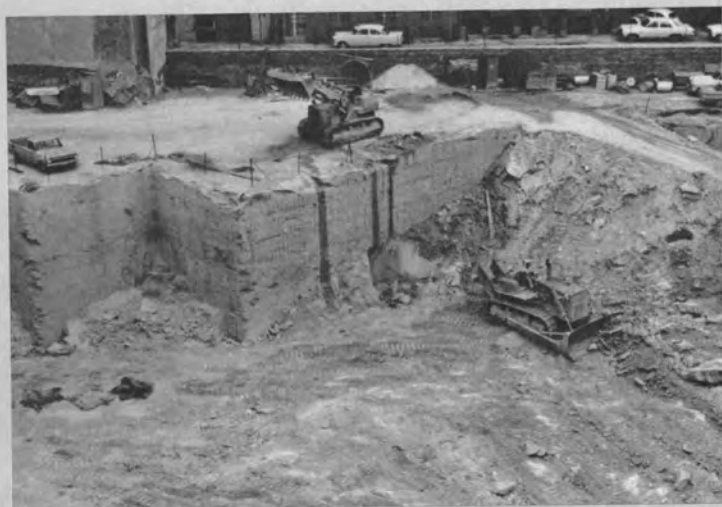
カンタス航空ビルの模型(左) 基礎の掘削(下)
