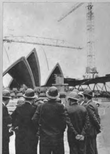
オペラハウス全景(上) 工事説明を聞く(右)
