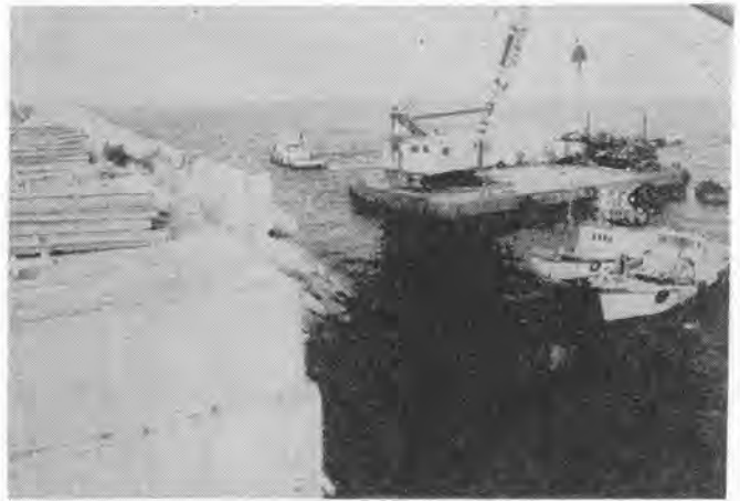
写真-1 マスチックの流込み作業
