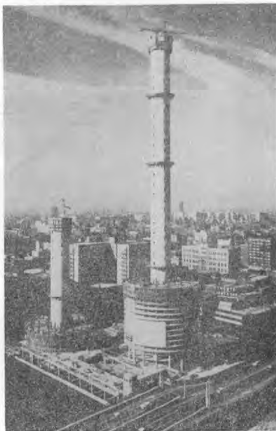
タワークレーンを使った近代的建築工事
