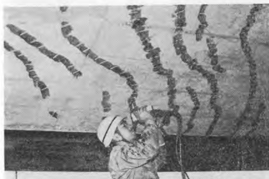
写真-4 高速道路橋りょう床版の補修
