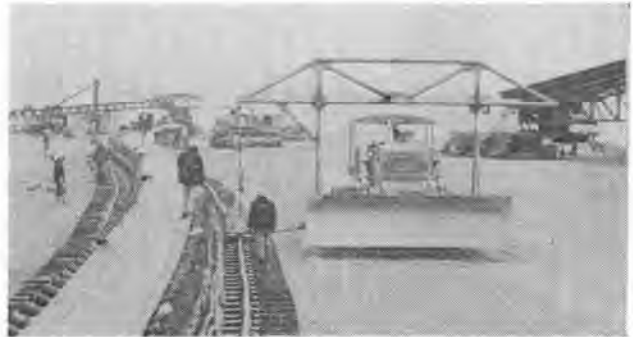
写真-3 シフトの状況
