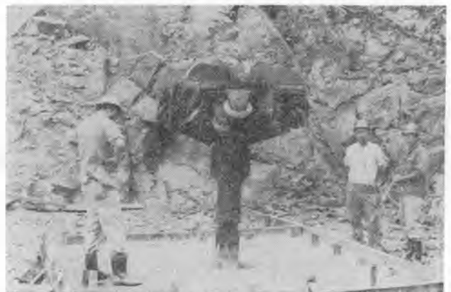
写真-1 リーマカッタの取付
