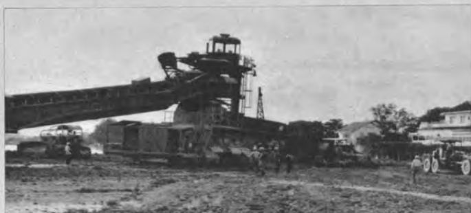
稼働中のホイールエキスカベータ(上) 延々と続くベルトコンベヤ(全延長約20km)(右上) コンベヤ末端で土砂放出するスプレッタ(右下)
