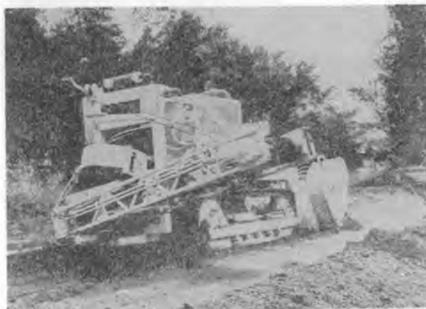
作業中のファイニンググレーダ
