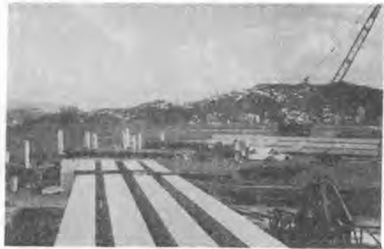
コンテナふ頭建設現場
