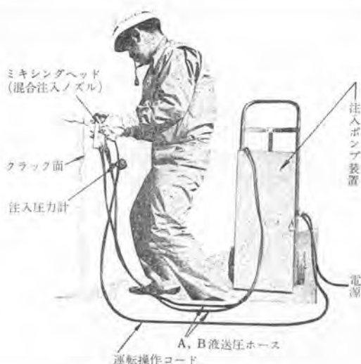
写真-1 ADOX 工法混合注入装置
