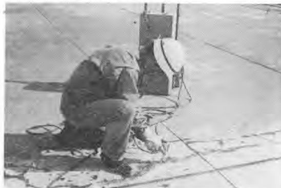
写真-2 建築屋上のクラック補修
