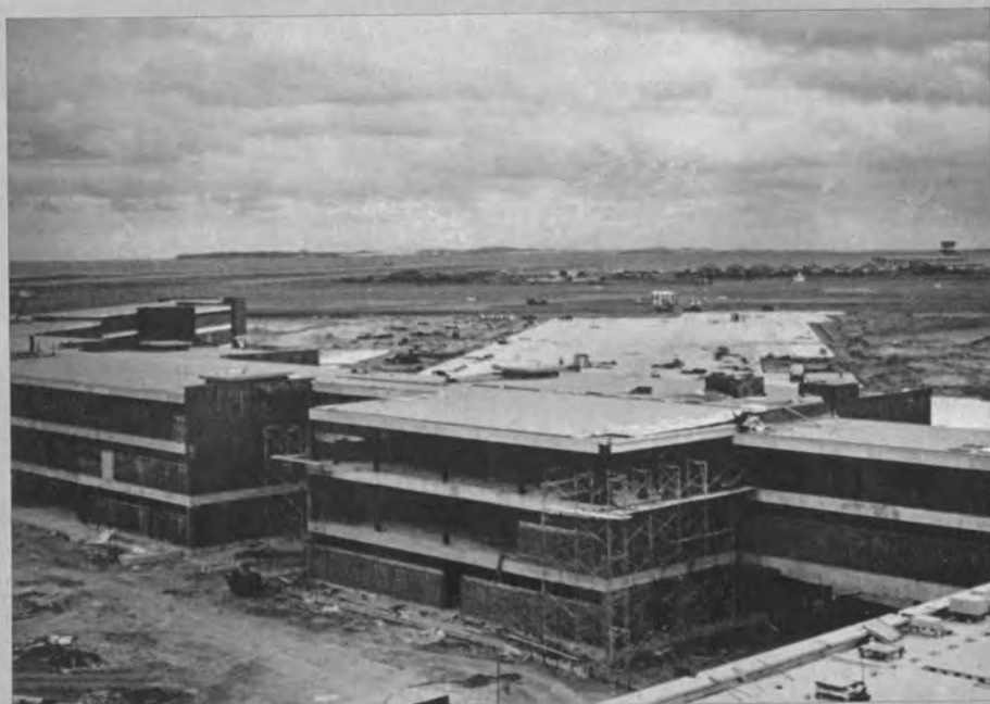
ターミナルビル の工事現場
