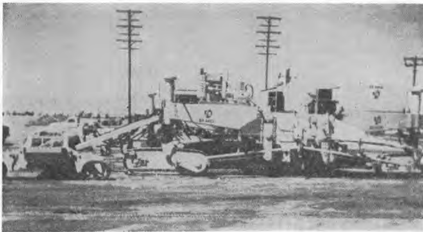
← スリップフォームペーパーおよびスプレッドボックス。
