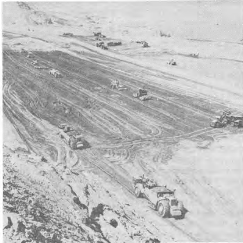
多種大量に投入された建設機械によるアースダムの建設
