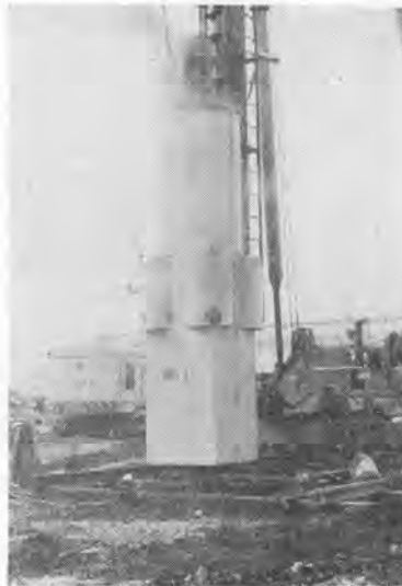
写真-1 ディーゼルハンマの防音カバー(1形)
