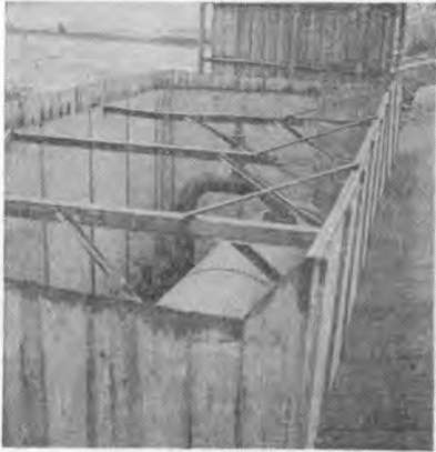
写真-6 防音塀を施している甲陽工区動力室
