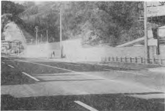
写真-7 ブロック塀を施している鶴甲工区動力室
