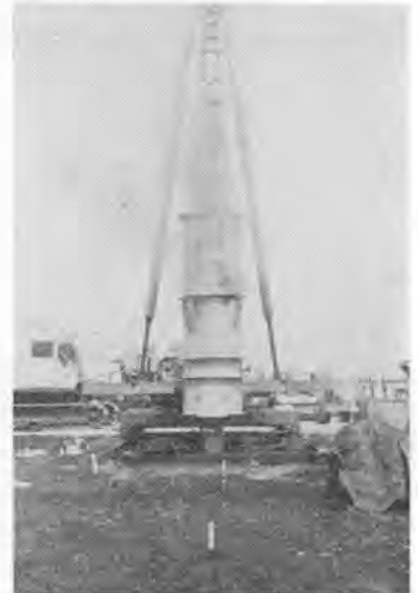
写真-2 ディーゼルハンマの防音カバー(2形)
