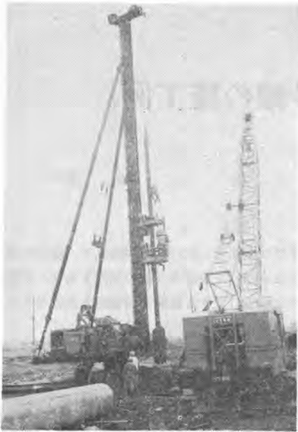
写真-1 掘削機にバケットをつける
