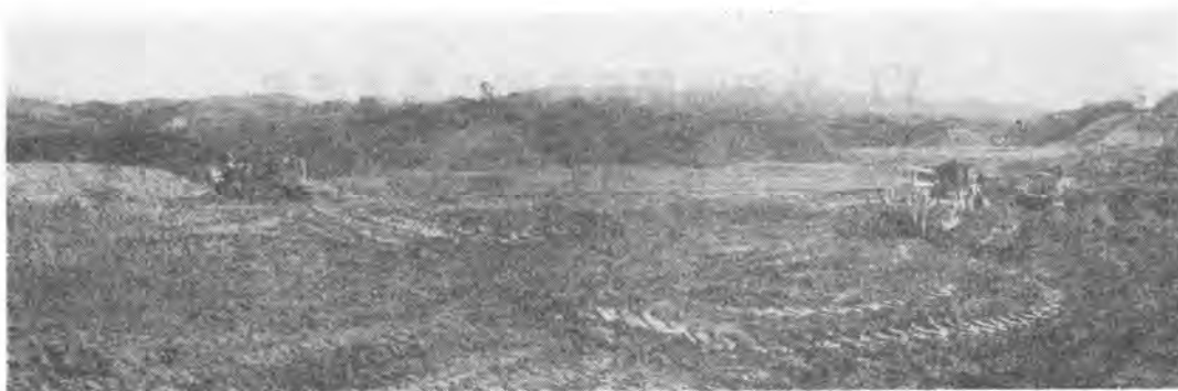
写真-1 重機械による土工作業
