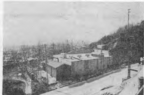
写真-8 建物で囲っている摩耶工区コンプレッサ室
