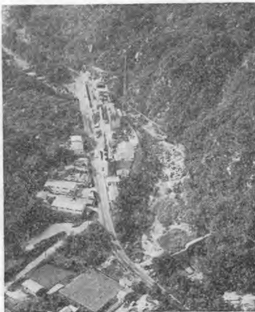
写真-1 北山斜坑（昭和 44 年 8 月）
