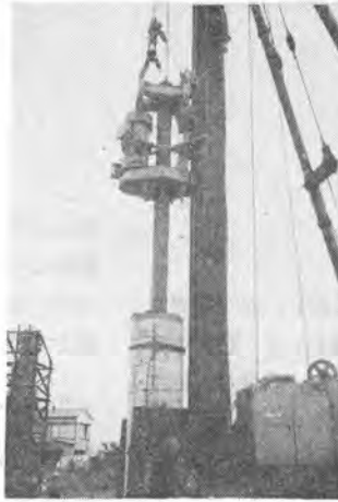
写真-2 バケットによる掘削
