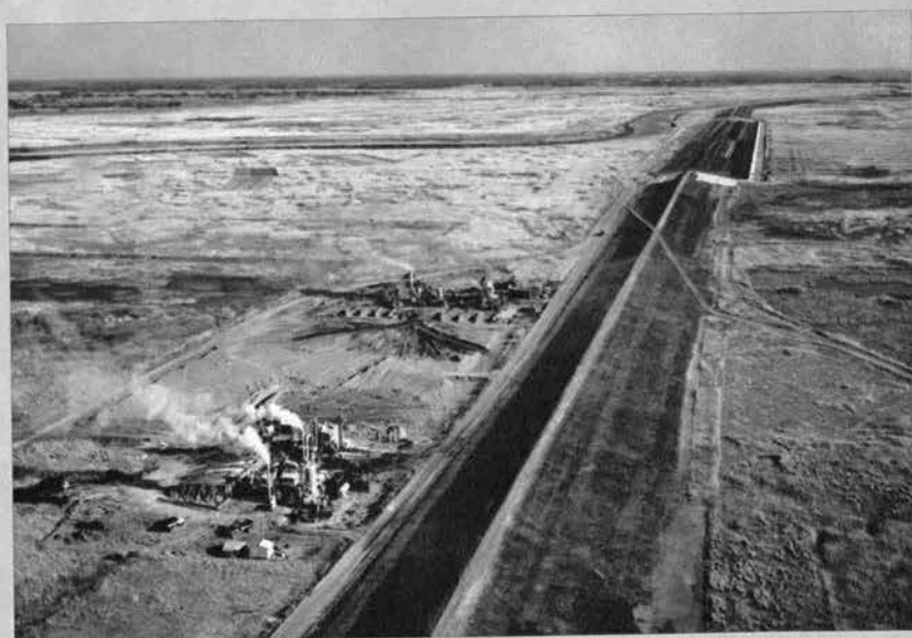
▲ 越流堤アスファルト舗装工事のうち、一番むずかしい施工箇所、囲繞堤との取付部斜面のアスファルト舗装転圧の機械化施工状況 (昭和45年5月)
