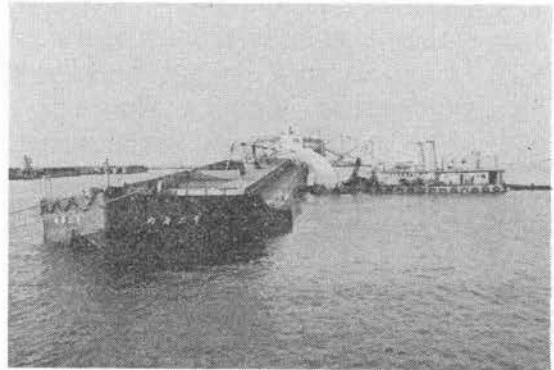
写真-4 陸揚作業状況
