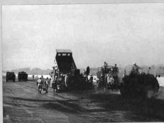
▲ 越流堤本体部のアスファルトフィニッシュによる合材敷きならしおよびタンDEMローラによる初期転圧施工状況 (昭和44年12月)
