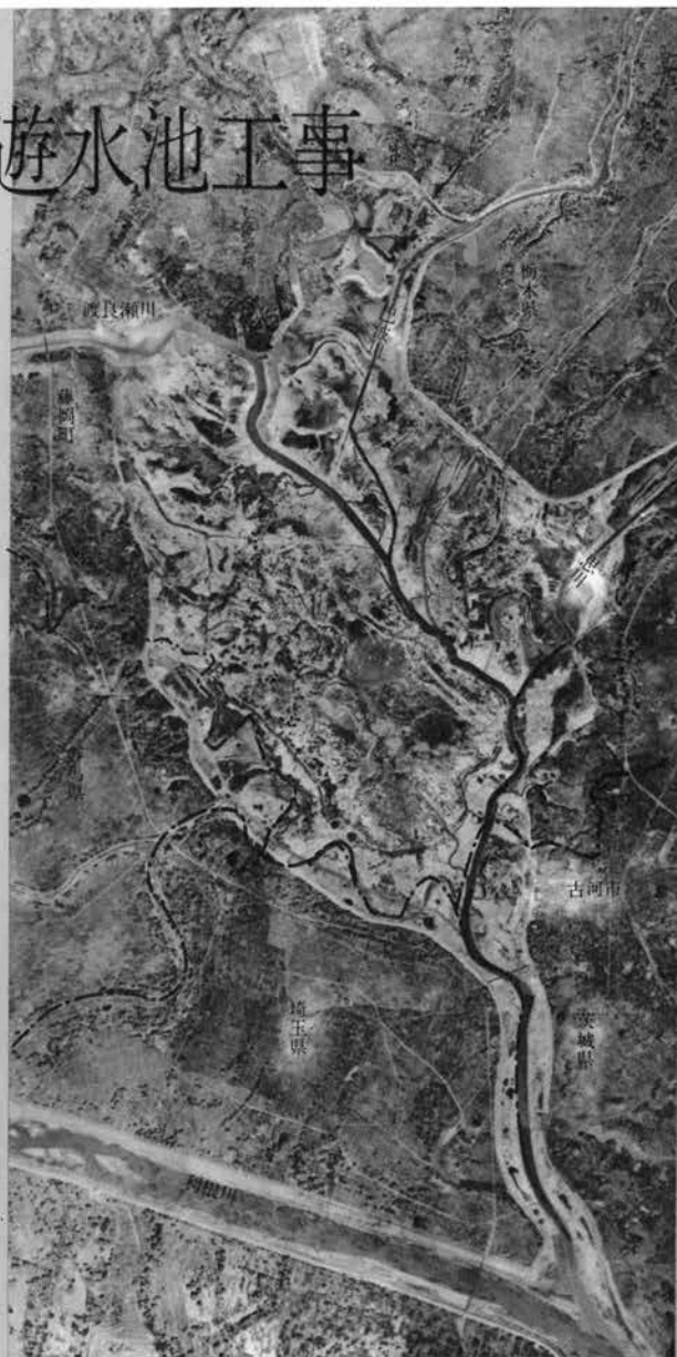
▲ 工事着手前空中からの鳥瞰(昭和34年3月)
