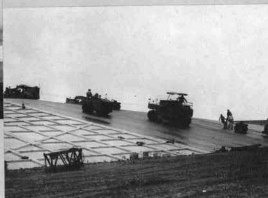
▲ 越流堤アスファルト舗装工事のうち、一番むずかしい施工箇所、囲繞堤との取付部斜面のアスファルト舗装転圧の機械化施工状況 (昭和45年5月)
