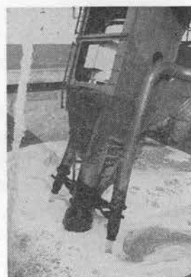
写真-6 吸込状況
