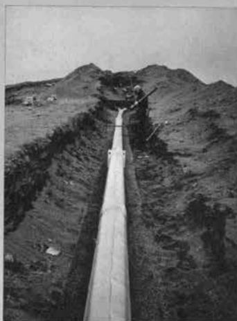
▼ 越流堤天端中央部に堤体内の浸透水によって圧縮される空気を排気するためのステンレス金網を巻いた \phi 250\text{mm} の有孔高圧積層パイプの布設および管周囲に巻立てられるフィルタ等の施工状況 (昭和43年12月)
