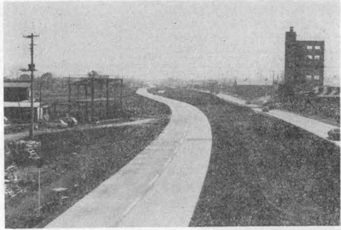
写真-3 浦和市地先上り車線完成 (内側車線試験施工, 外側車線本施工)
