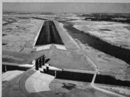
▲ 下流側越流堤アスファルト被覆状況(昭和45年5月)
