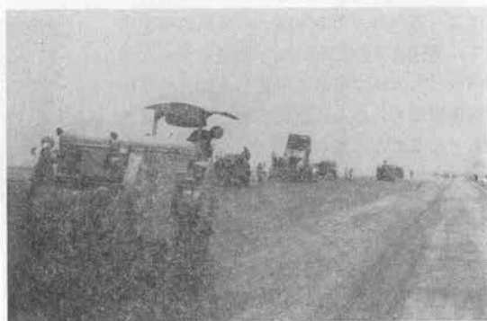
写真-1 越流堤アスファルト合材敷きならし転圧作業
