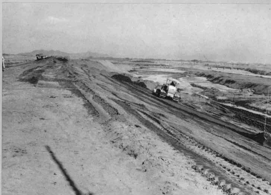
▶ 500HP電動ポンプ 浚渫船で吹き立てた 圍繞堤のブルドーザ 整形作業状況 (昭和43年1月)
