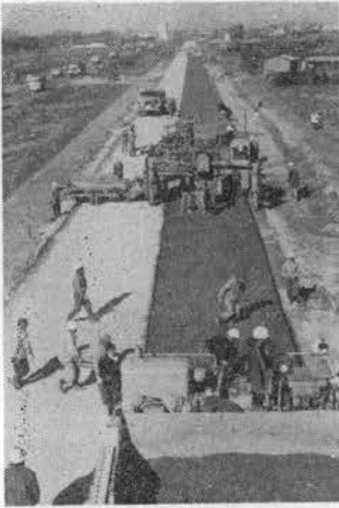
写真-1 2層式施工中
