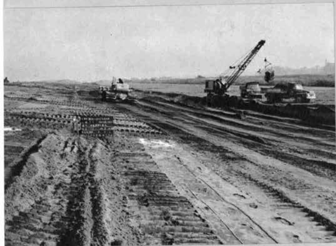
▲ 越流堤路床のドラグライン、ブルドーザ、グレーダ等による整形作業状況 (昭和44年10月)
