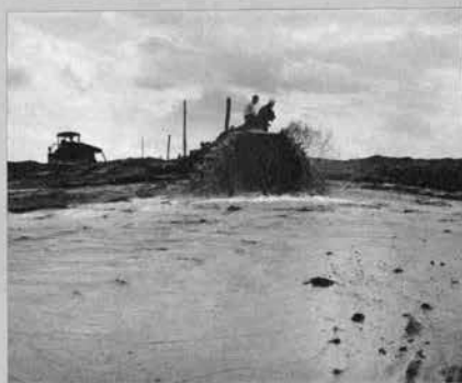
▲ 500HPの電動ポンプ浚渫による築堤個所の送泥施工状況 (昭和43年1月)
