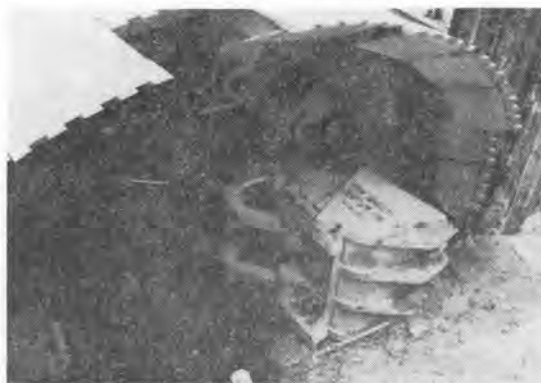
写真-5 ビックジョン横向き掘削中
