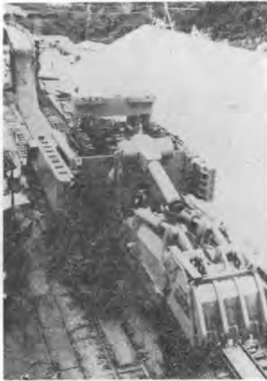
写真-6 ビックジョン本体組立中
