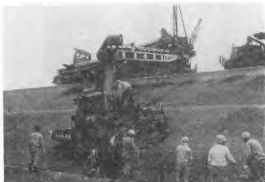
写真-19 斜面用ローダと組合わせたセメント安定処理工
