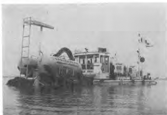
写真-32 水中ブルドーザ S2 形作業状況
