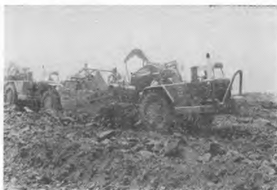
写真-4 モータスクレーバ Cat 657 B プッシュプル作業
