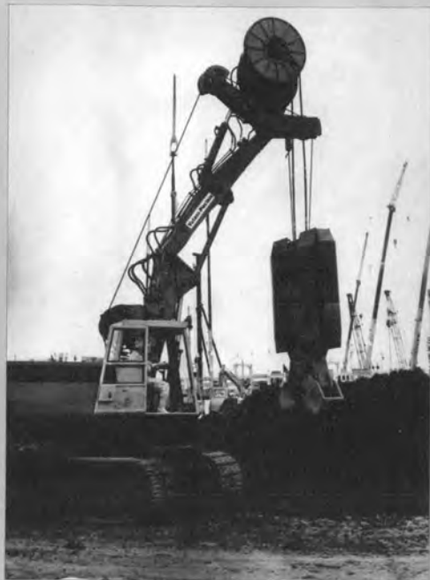
◀ 異容を示す地下連続壁用クラムシェル (油谷 GC120)
