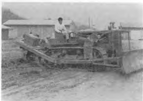
写真-6 サイドレンチャ全景
