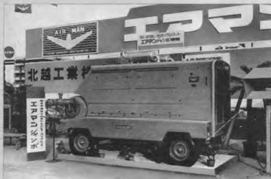
▲世界最大級ポータブルコンプレッサ(北越AMS900)
