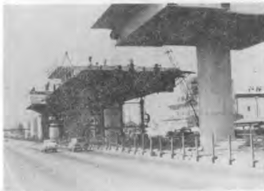
写真-6 つりげた支保工
