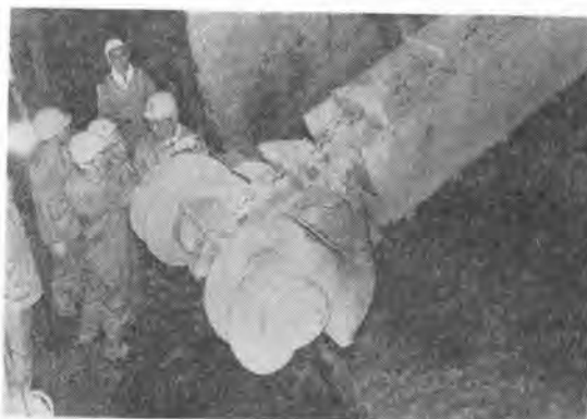
写真-11 シールド用スクリーエクスキャベータ
