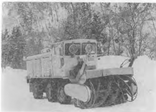
写真-11 高速ロータリ除雪車 (700 PS)
