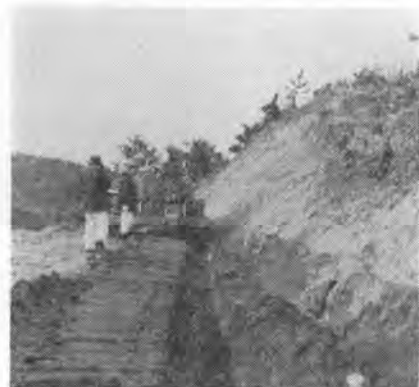
写真-7 サイドレンチャによる側溝掘削
