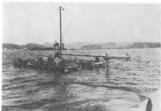
写真-9 傾動自在形試錐機の海底ボーリング
