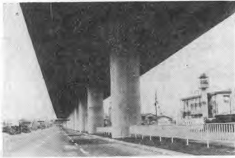
写真-1 完成したPCゲルバーげた橋
