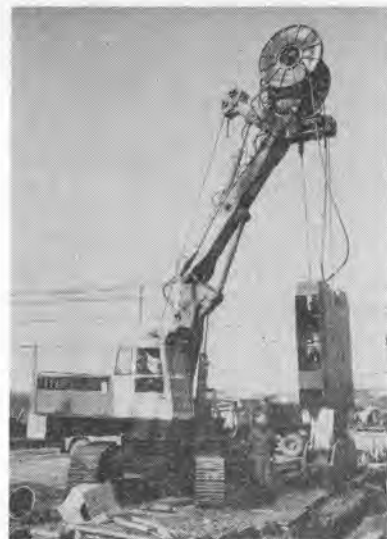
写真-17 ディープディギングクラムシェル
