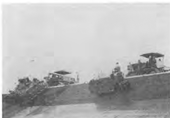
写真-20 斜面用アスファルトフィニッシャとローラ
