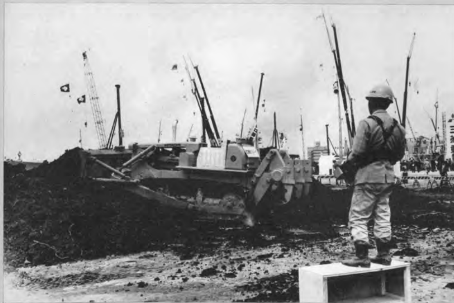
◀遠隔無線操縦のリッ パ付ブルドーザ (日立T20)
