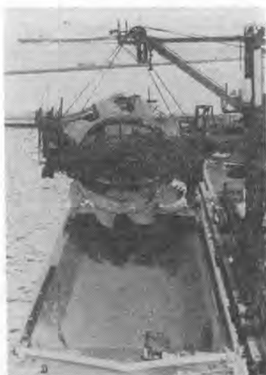
写真-31 半円形 3,000 t 土運船と土砂揚げ装置
