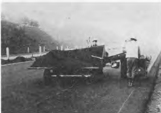
写真-24 アスファルトカーバとローダ
