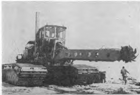
写真-4 水陸両用掘削機
