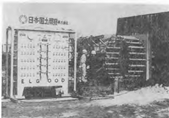
写真-10 エルグッド引管装置 (右側はけん引ジャッキ)
