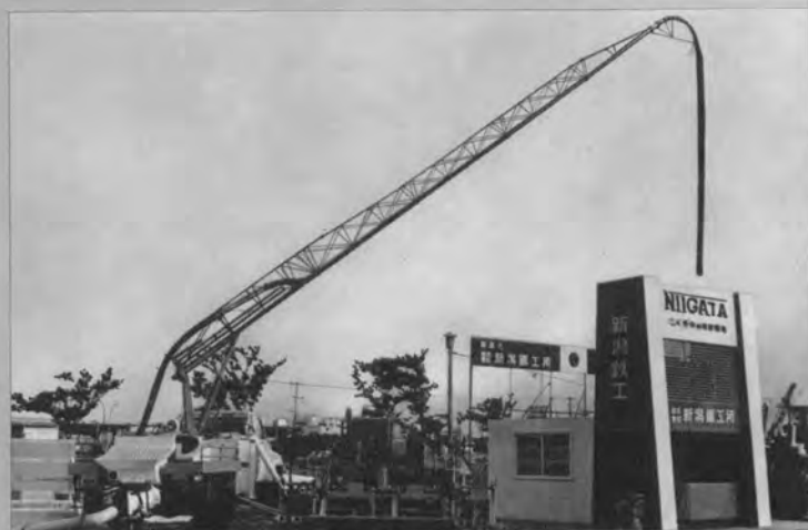
◀ブーム付コンクリートポンプ車 (新潟NCP640A)
