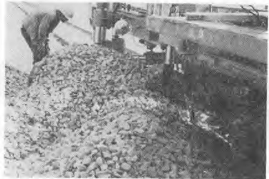
写真-4 バラストかき寄せ機稼働状況
