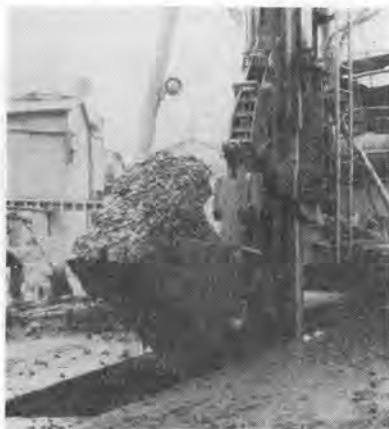
写真-15 エルゼ工法施工状況
