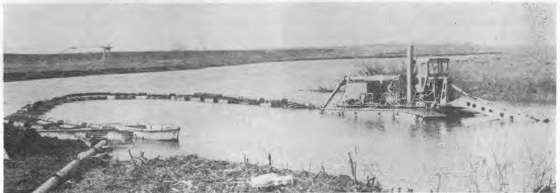
写真-5 水陸両用掘削機の稼働状況
