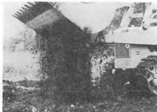
写真-8 スクリーン形バケットの採集ふるい状況
