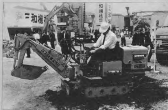
▲ ブレード付超小形バックホウ (岩手富士 CT10)
