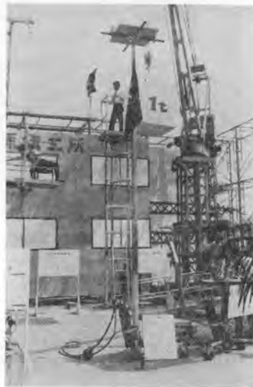
伸縮作業足場等(越原)
