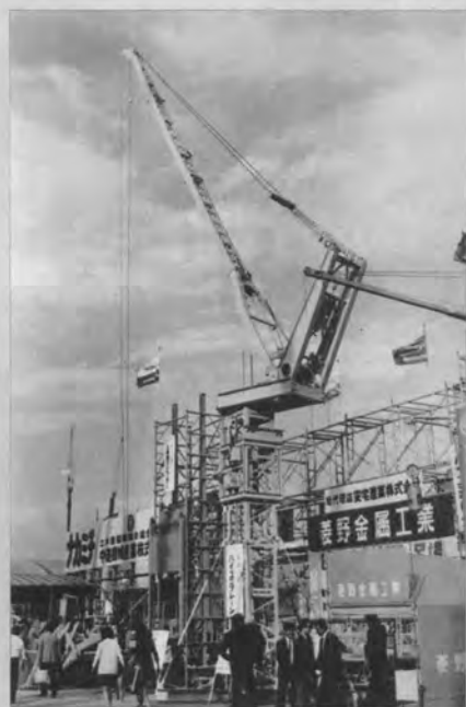
▲空にのびるタワークレーン(菱野)
