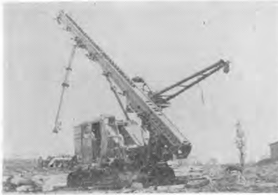
写真-3 護岸造成機
