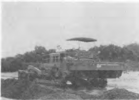
写真-1 路盤成形機
