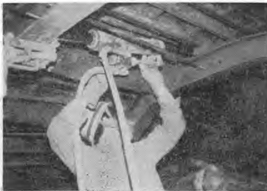
写真-1 8t油圧ジャッキ推進状況
