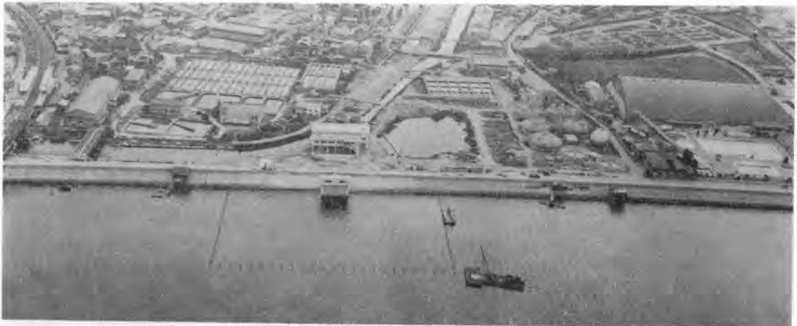
写真-1 竣工した分水施設、取水樋門および高見機場
