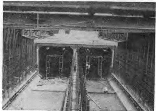
写真-3 工事中の分水路
