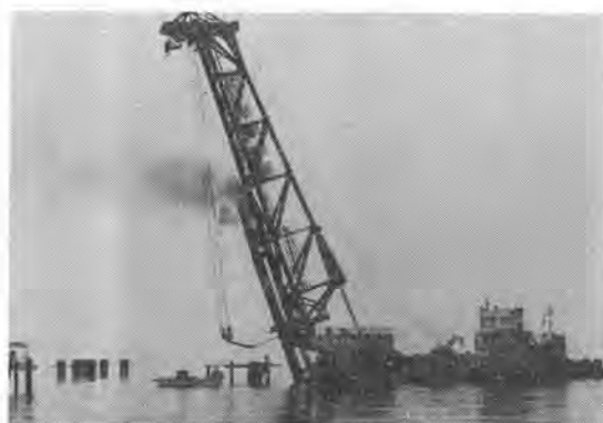
写真-1 D-70形ハンマによる斜ぐい打ち
