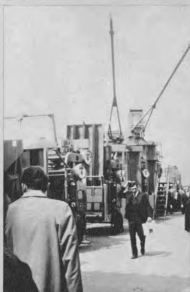
▲クレーン付バッチャプラント
