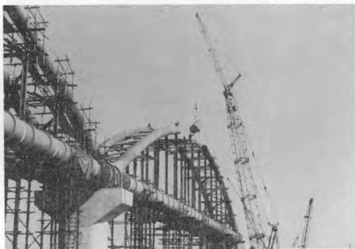
写真-7 調整管の落とし込み
