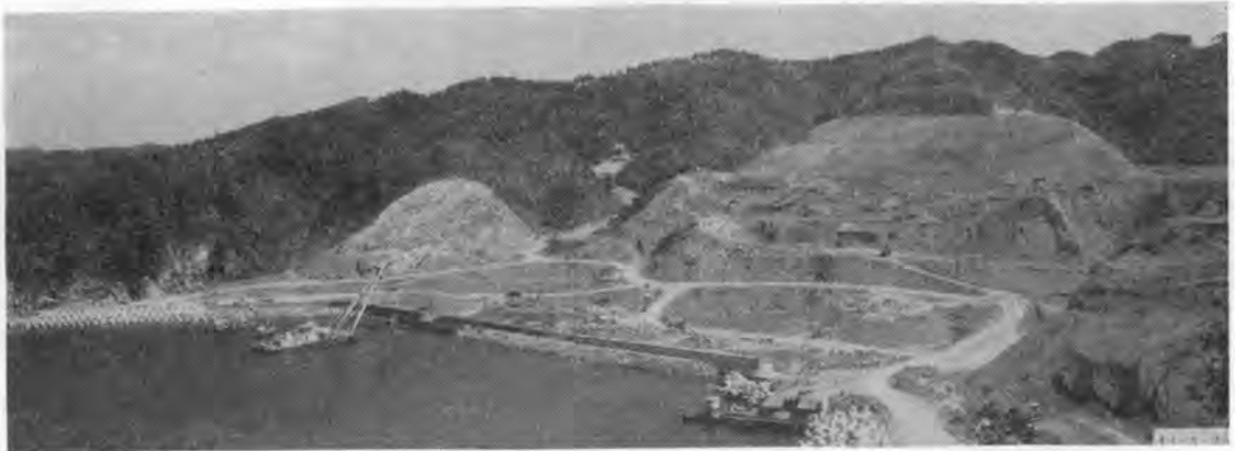
写真-3 敷地および護岸工事のサイトの全景(44年8月26日)
