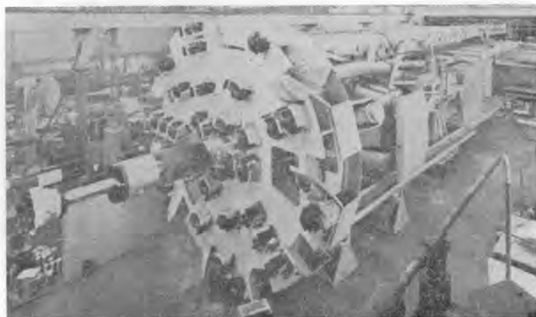
トンネル掘進機の全景である。24 in 径の先進導坑の掘進長は 11 ft で、この掘削後、パイロットアンカーが 2 ft のトンネル掘削のできるように油圧で拡張される。
