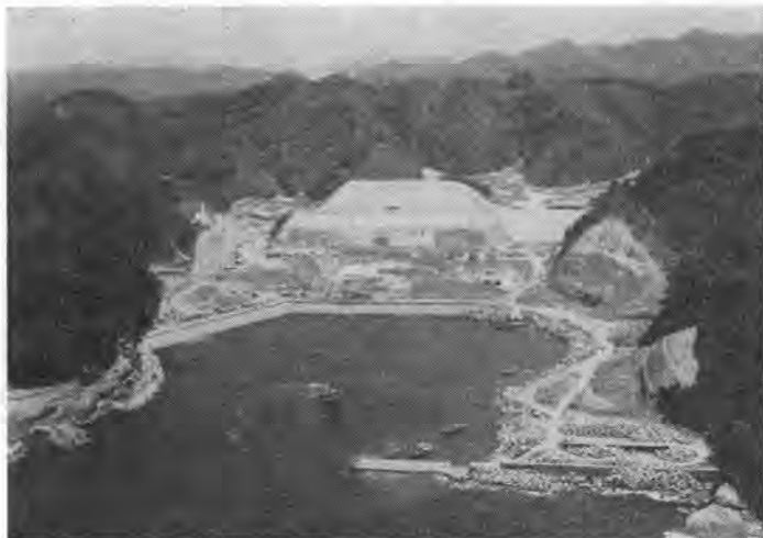
写真-1 工事中の島根原子力発電所サイトの全景(45年5月30日)
