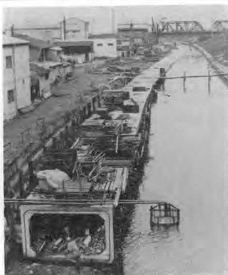
写真-4 工事中の工業用水導水設備
