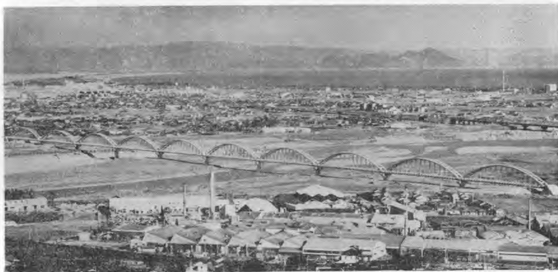
写真-1 富士川水管橋全景
