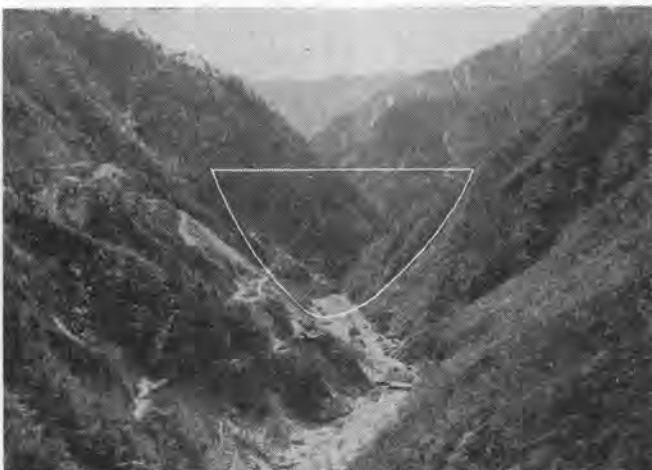
写真-1 ダムサイト
