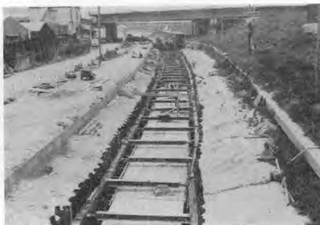
写真-5 工事中の排水設備
