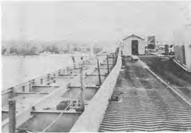
歩道部と鋼床版（ドナウブリュッケ）
