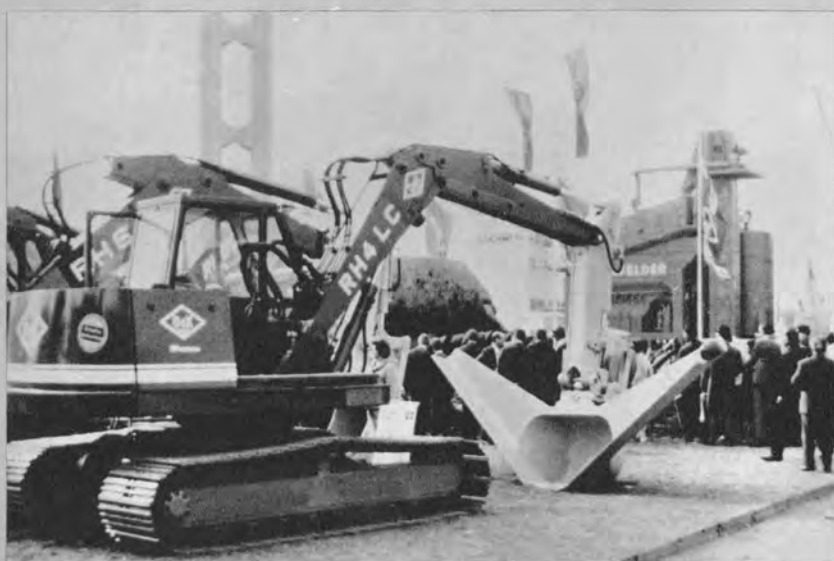
◀油圧式掘削機のアタッチメン ト (V溝整形)
