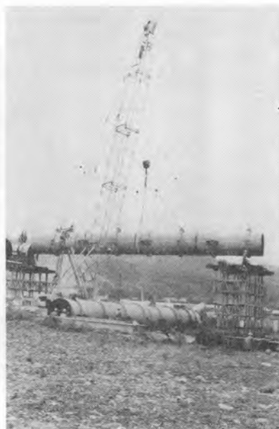
写真-5 送水本管つり込み
