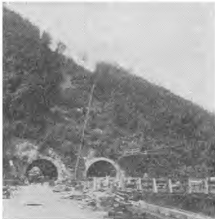
トンネルとケーブルクレーンの可傾式タワー (イタリア)
