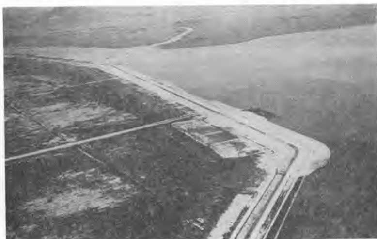
写真-3 正面堤防
