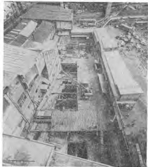
写真-2 山留全景
