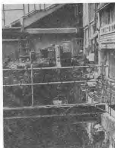
写真-1 第1段第1次根切り
