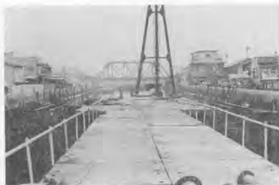
写真-1 工事用仮栈橋
