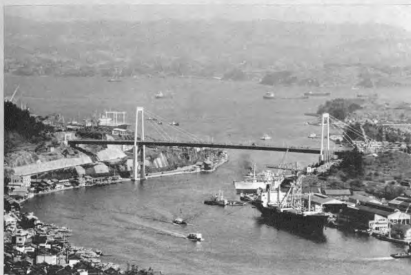
尾道大橋 —日本道路公団提供—
