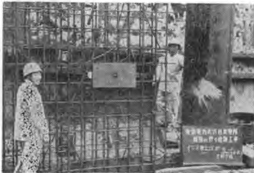
写真-8 イコスコンクリート打設状況
