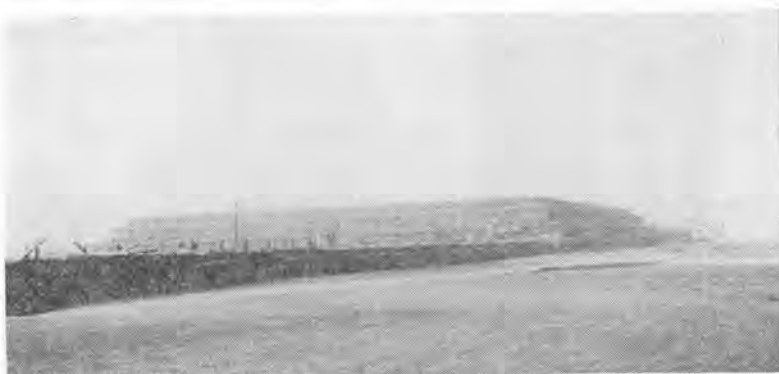
写真-4 盛土載荷の状況
