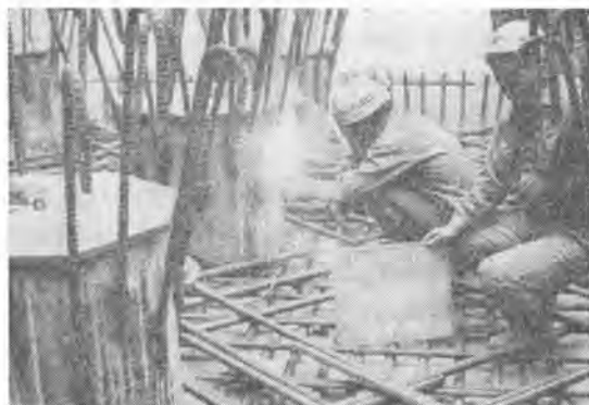
写真-5 鋼管くい頭の施工
