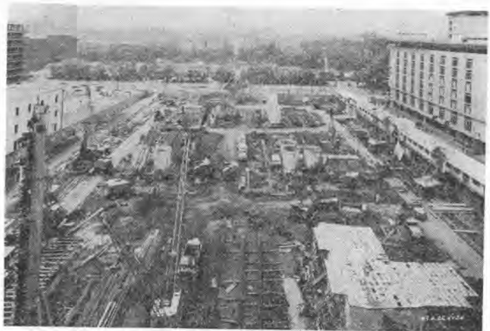
写真-3 山留壁施工状況
