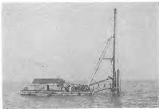
写真-3 サンドドレーン船による八代港の砂ぐい施工
