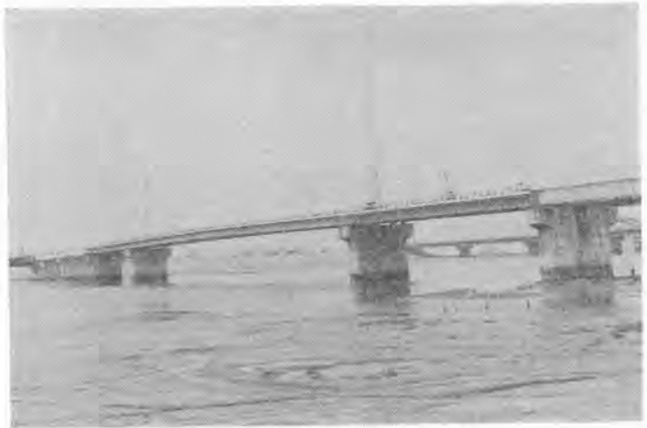
写真-6 完成した荒川橋りょう
