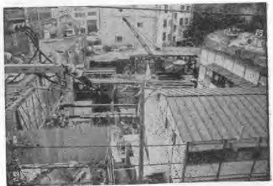
写真-9 現場状況
