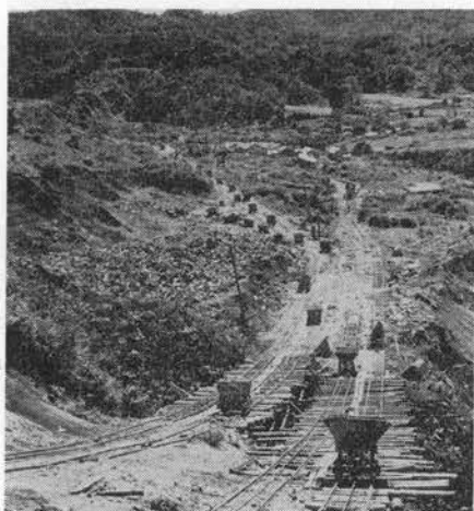
写真-1 エンドレスによる用土の運搬(山王海ダム)
