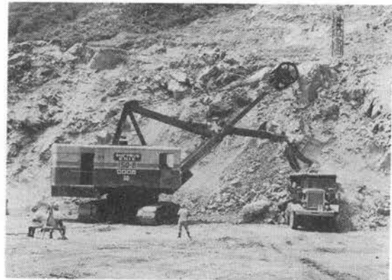
写真-16 ユークリッド 60 TD 22 t ダンプとピサイラス 150 B ショベル
