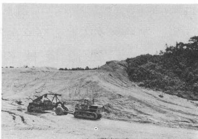
写真-2 8yd 3 スクレーパによる盛土作業(船木池ダム)
