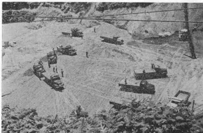
写真-7 ダンプトラックによる盛土作業(相野々ダム)
