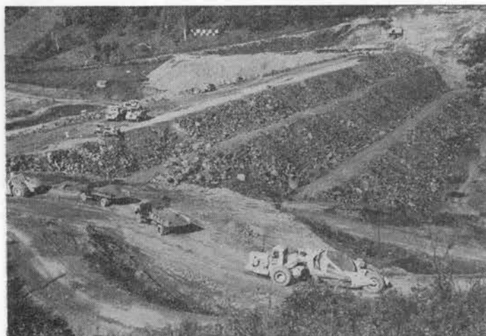
写真-19 盛土作業中の ZG 11 ダンプトラックと 12yd 3 モータスクレーバ (岩洞ダム)
