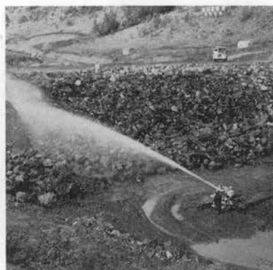
写真-20 モニターで石塊の水締め作業 (噴射圧力約 7 kg/cm 2 ) (岩洞ダム)
