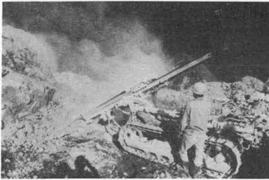
写真-15 クローラドリル
