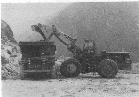
写真-18 7.65 m 3 ホイール式トラクタショベルと 32t ダンプトラック
