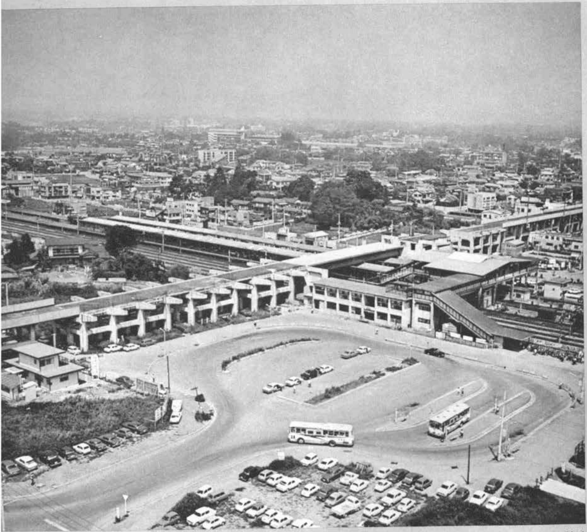
▲武蔵野線南浦和駅付近
