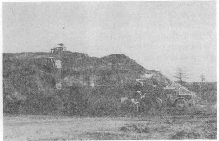
写真-2 ホイールローダによる積込み (運土距離 500 m 以上の土工はダンプトラックが多い)
