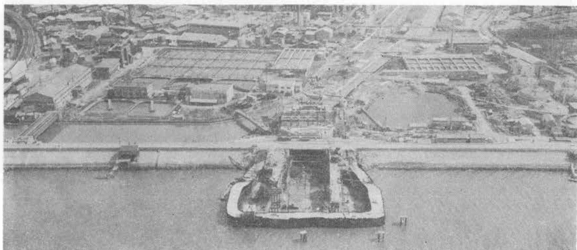
写真-6 正蓮寺川利水高見機場淀川取水樋管
