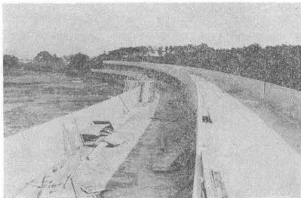
写真-1 常磐支線高架橋上より北小金方を望む
