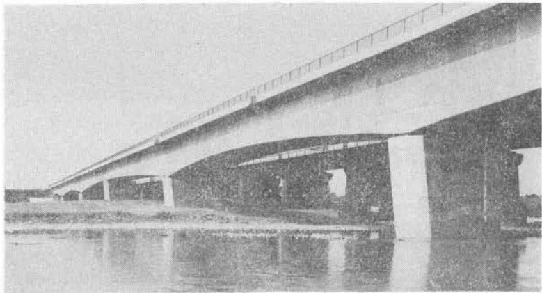
写真-3 多摩川橋りょうを新鶴見方より与野方を望む
