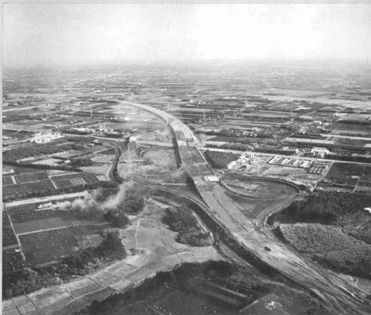
▲千葉インターチェンジ付近
