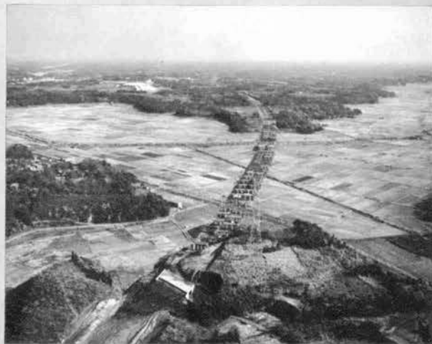
▲四街道町物井高架橋付近
