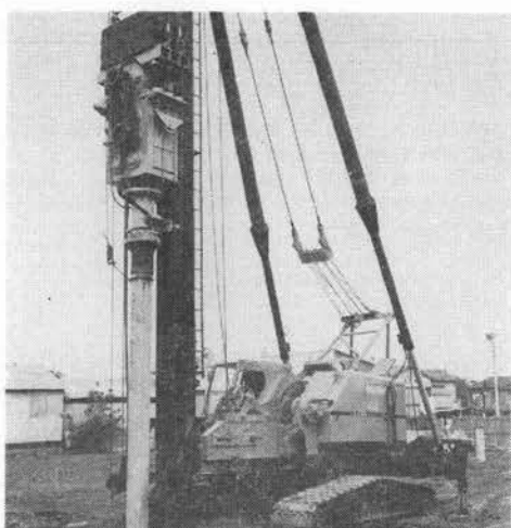
写真-2 振動式くい打ち機 “333 AHS ハイマック”
