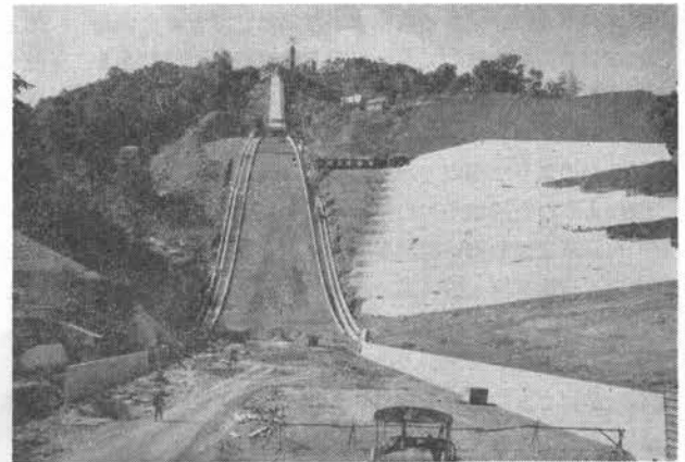
写真-2 大倉山ジャンプ競技場工事完成近し
