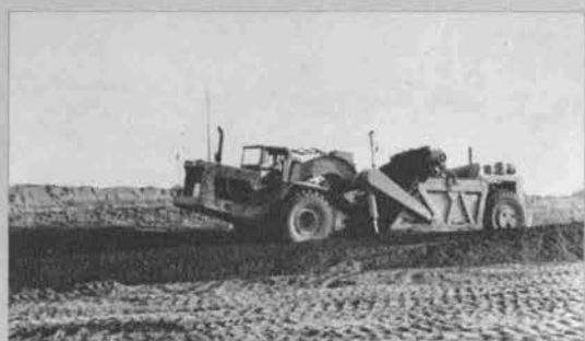
モータスクレーバ（上）とエレベータ スクレーバ（左）による陸削 — 昭和45年 —
