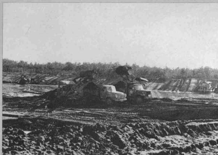
◀ パワーショベルとダンプ による中央航路陸削 — 昭和42年 —
