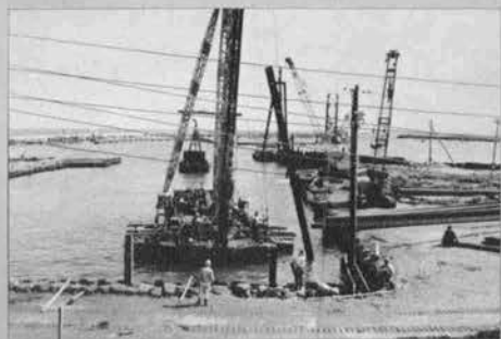
▼ケーソンドックの築造 — 昭和40年 —
