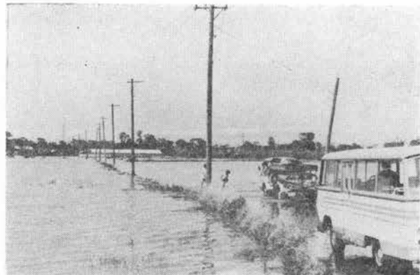
写真-3 湛水状況
