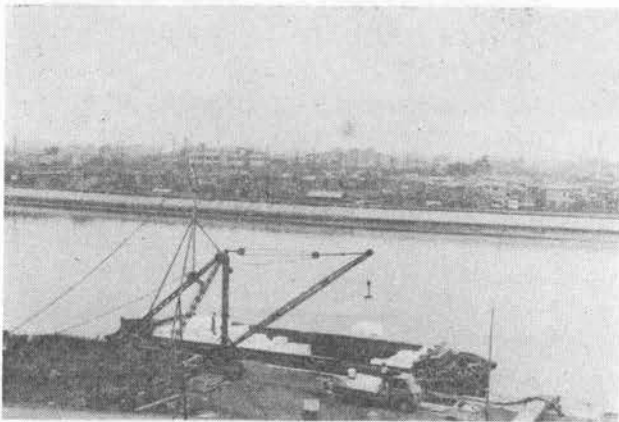
写真-2 中川下流部
