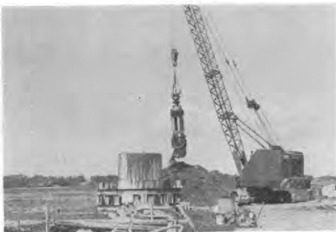
写真-3 東京電力送電線用鉄塔基礎（茨城県境町）に用いられたPCウェル（2,500φ）の施工状況
