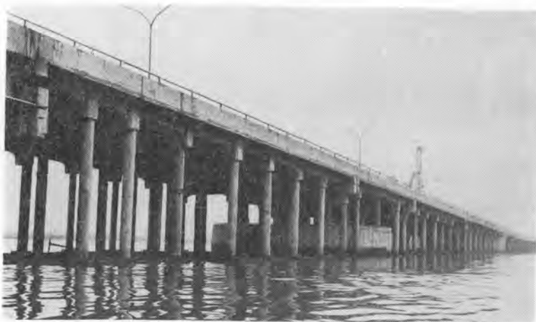
写真-1 首都高速道路公団高速1号線中のPCぐい
