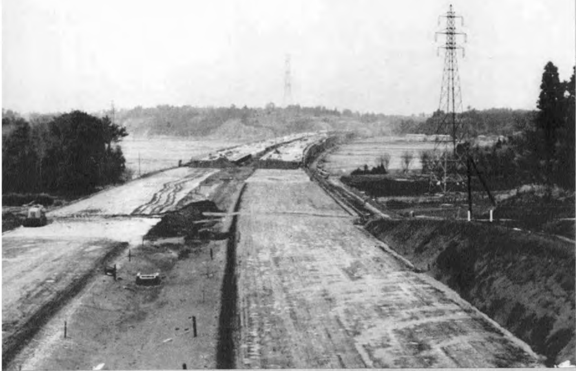
▲ 東関東自動車道鹿島線四街道町物井付近で、前方は床版工事中の物井高架橋である（手前が東京側）。
