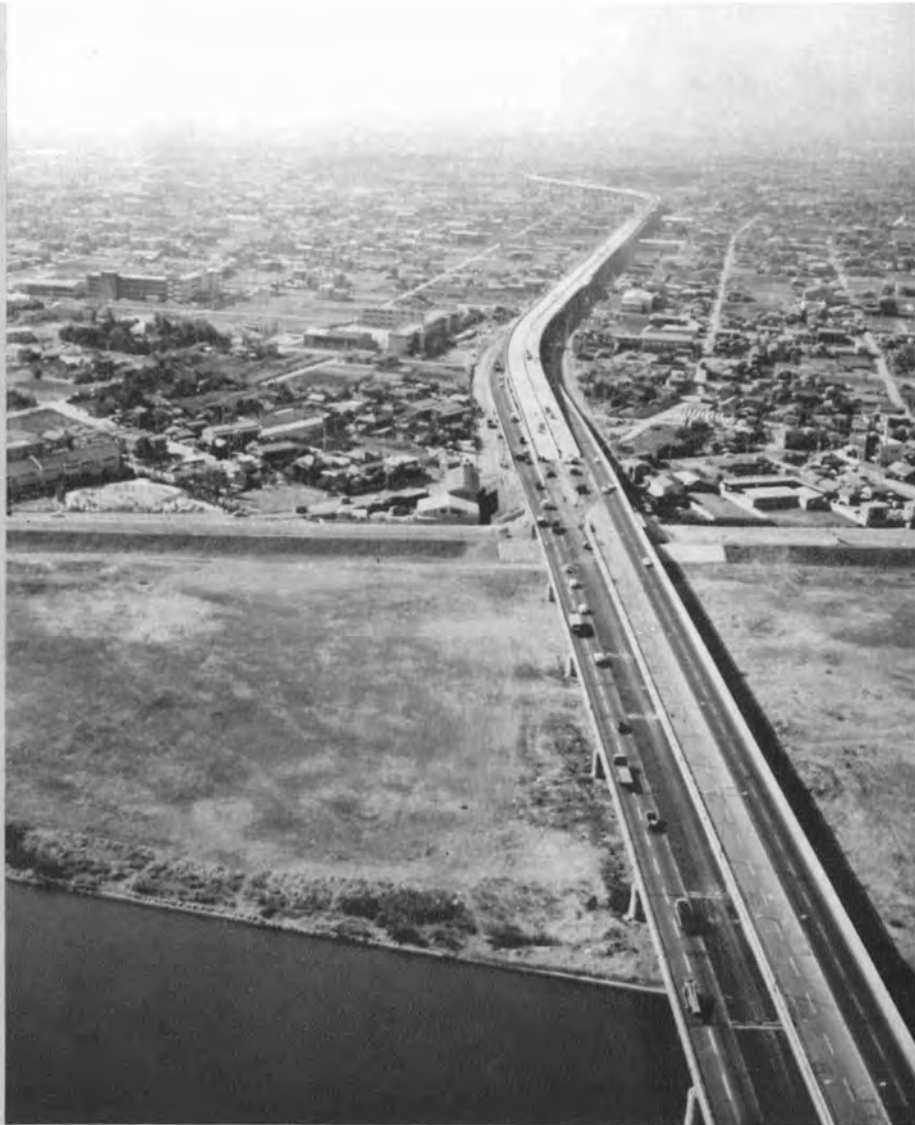
▲京葉道路の江戸川付近より都心方面を見る。今回はここまで供用開始された。
