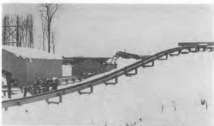
写真-4 米国ミシガン州のホワイトバイン 銅鉱山の約 9 km の鉱石輸送システムの一部で、手前の上昇角16°、後方に見えるガイドウェイの降下角は 35°である。
