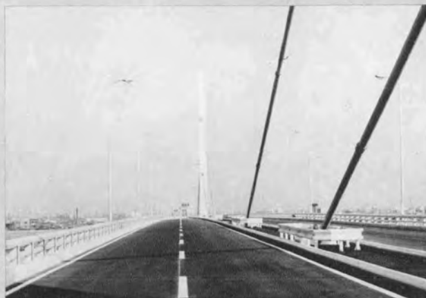
▲荒川大橋の橋面上より成田方面を見る。
