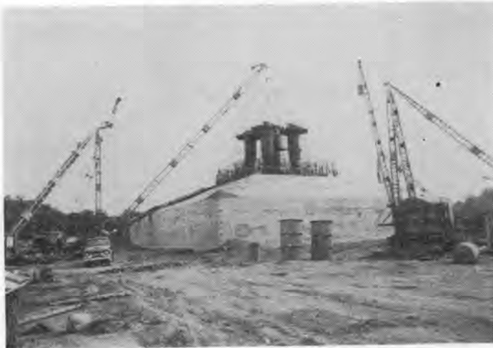
写真-1 P 3 ケーソンの外観
