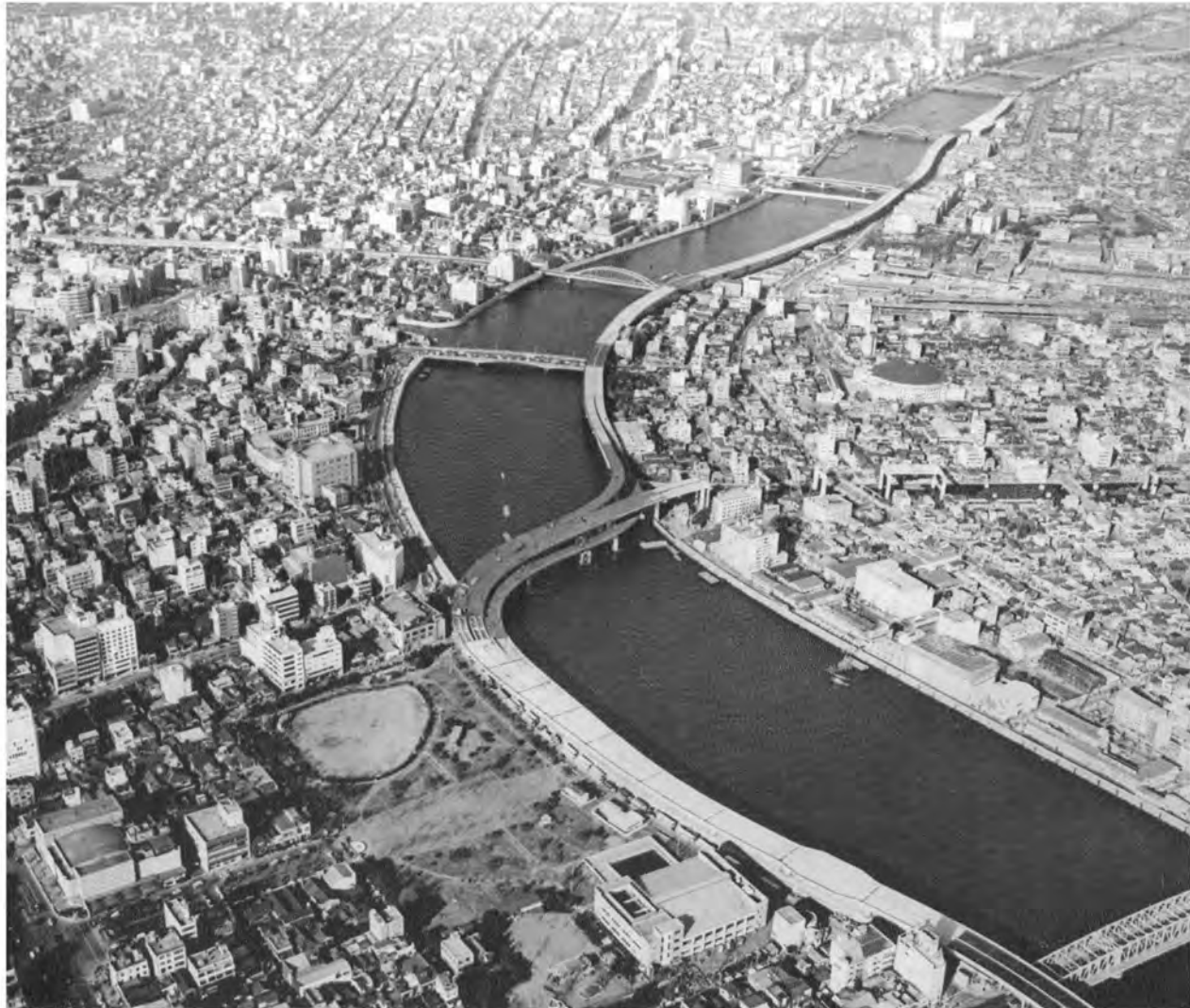
▲隅田川を渡る東両国インターチェンジ（両国大橋）で、上方へ伸びるのは6号線、右の方へ伸びるのは7号線である。主要構造は3径間鋼床版連続箱げた5連、中央径間80mである。
