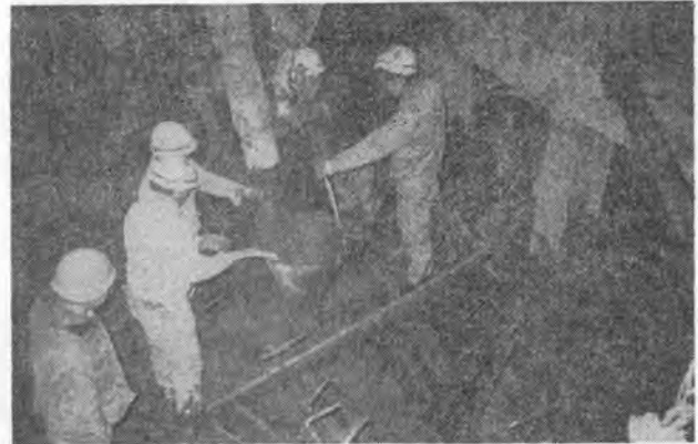
写真-5 コンクリート打設 (トレミー管使用中)
