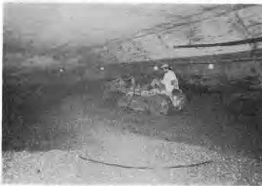
写真-2 電気ブルドーザによる作業状況
