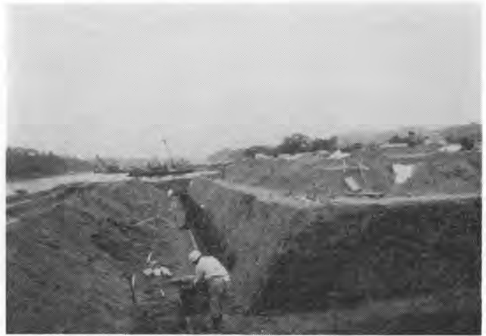
写真-3 砂セントルの作業状況
