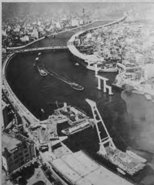
▲東両国インターチェンジのけた架設には125tのフローティングクレーンを使用した。
