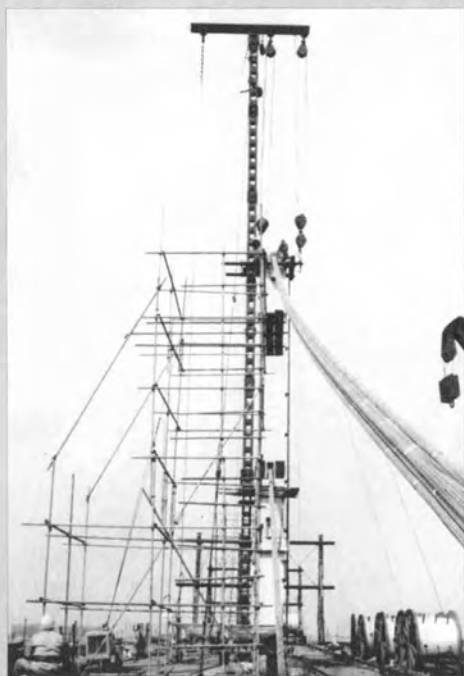
▼斜張橋の平行ワイヤの引込作業
