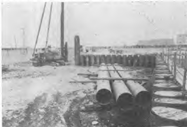
写真-1 内側締切鋼管矢板打込状況 (P 3 )
